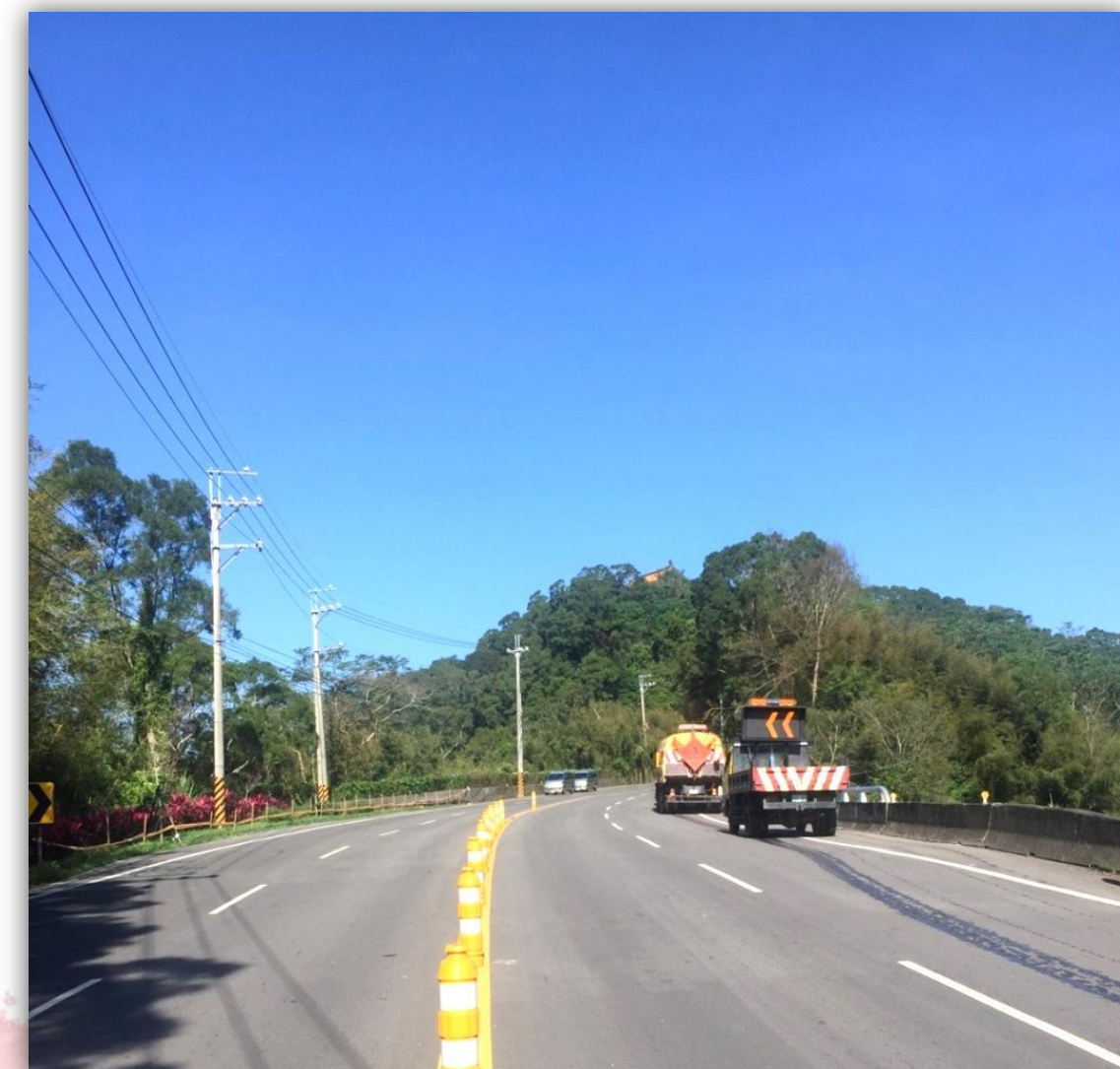
路面清掃作業
