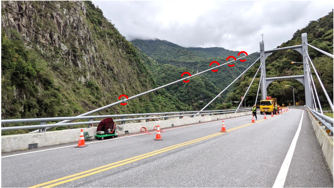
圖 3-3 鋼纜模態檢測試驗之感測器裝設完成案例
