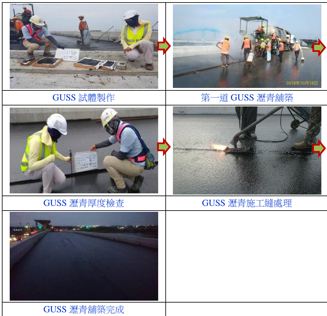
相片 5 流動性瀝青混凝土(GUSS)鋪面施工流程
