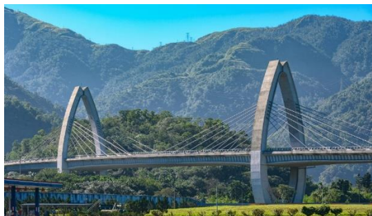
台 9 線白米景觀橋
