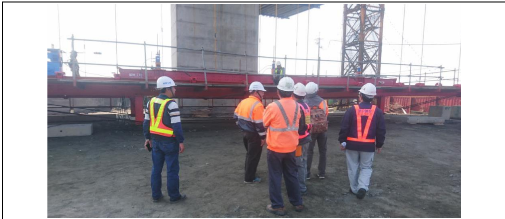
懸臂施工前施作全載重試驗驗證工作車結構
