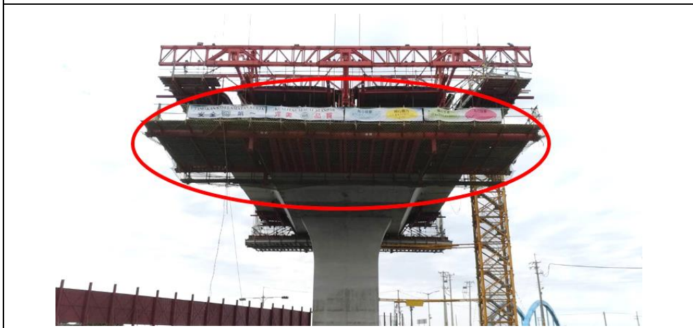
臨台 17 線側增設防落底板
