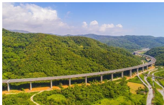
台 9 線南迴安朔高架橋
