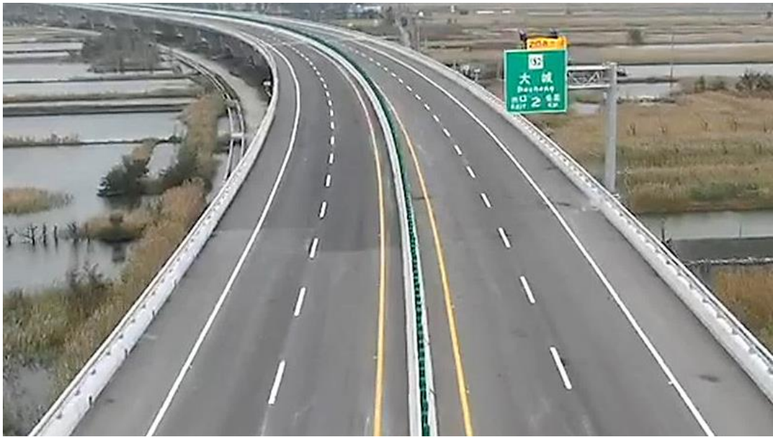
相片 14 WH52 標高架橋 AC.完成路面實景
