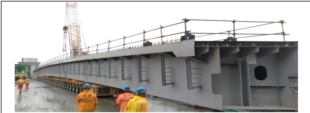
自走式多輪軸運引車實際運梁情形
