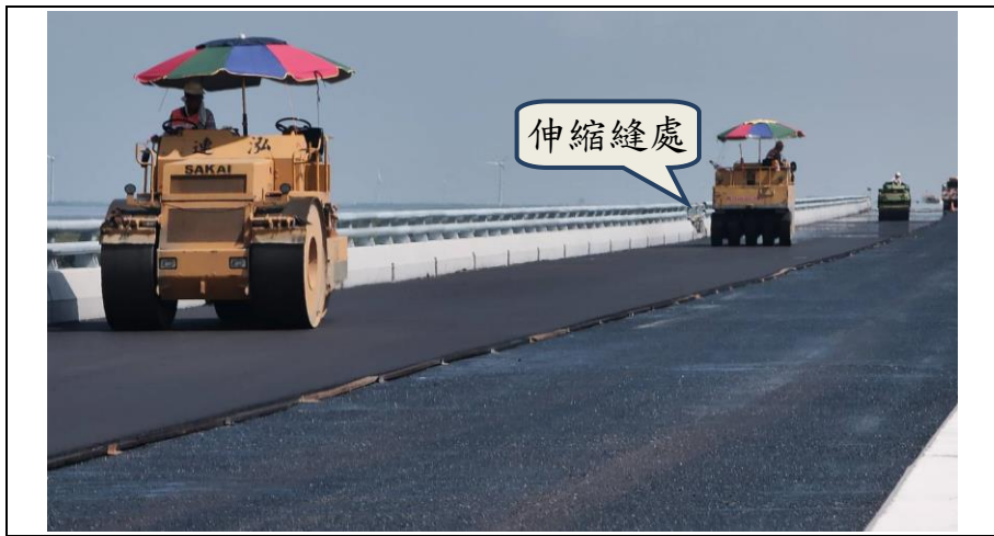
相片 12 橋面板與伸縮縫處同時連續鋪設瀝青路面
