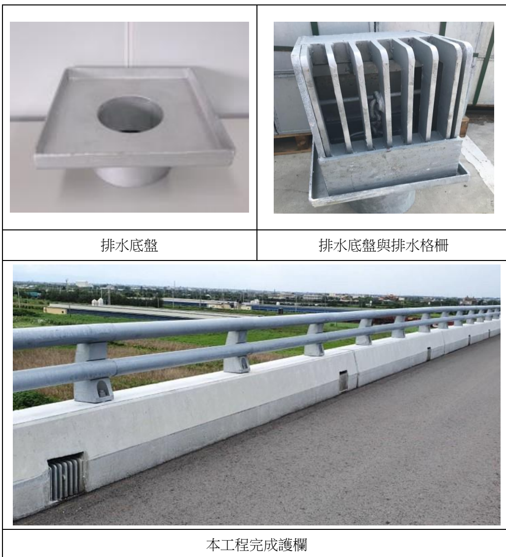
相片 10 排水底盤、排水格柵及實際完成護欄
