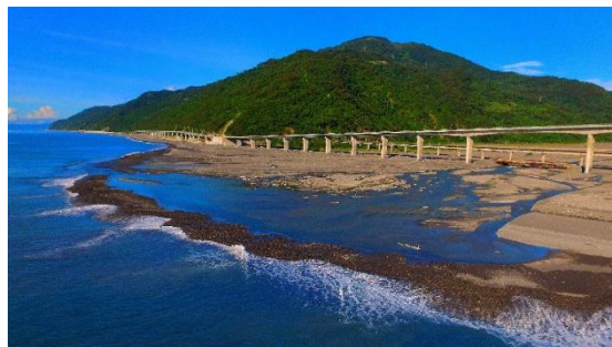
台 9 線金崙大橋
