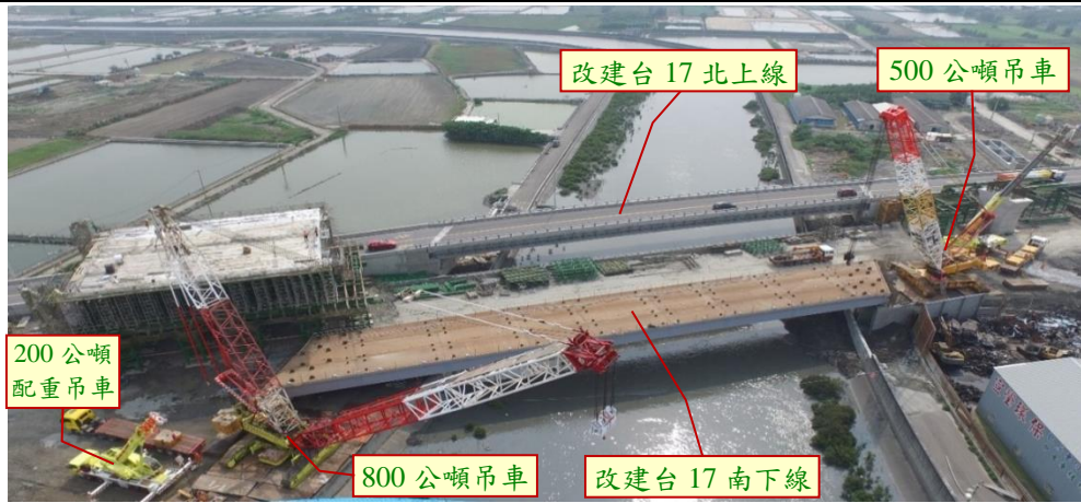
改建台 17 線路段採用 2 部人字臂起重機實際吊梁情形
