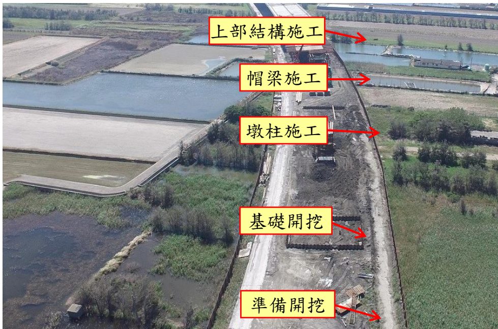
相片 1 基礎、墩柱、帽梁接續施工情形
