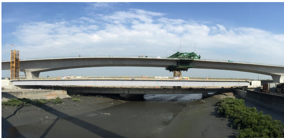
相片 3 U42B 懸臂工法完成線形
