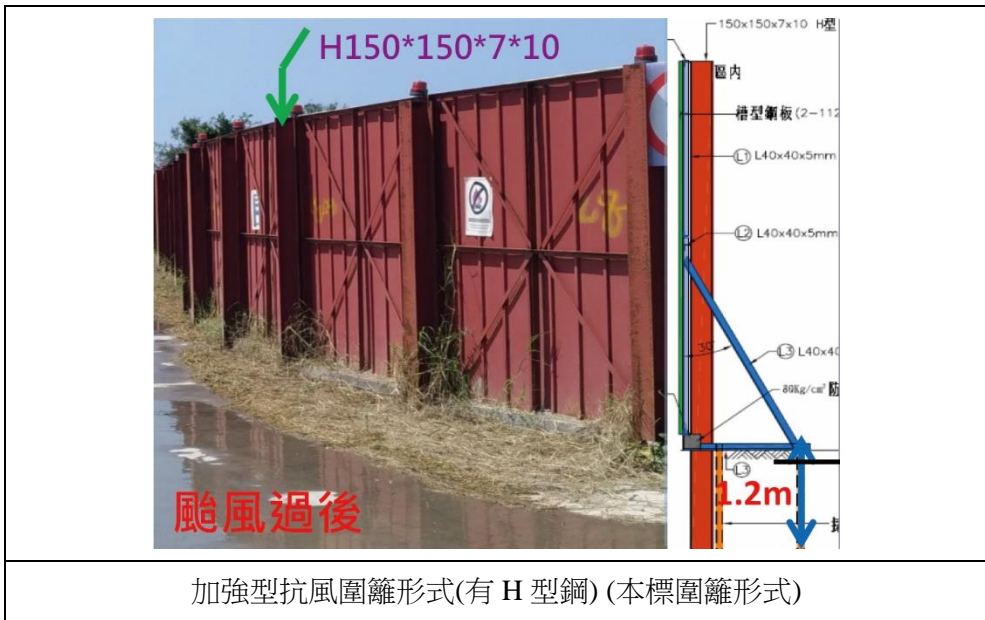
圖 14 一般型圍籬與加強型抗風圍籬形式與颱風過後差異圖
