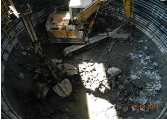
圖 4-3 井式基礎機械開挖及設計深度抽查
