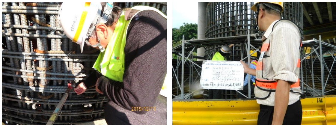
圖 4-10 墩柱鋼筋續接器扭力抽查及鋼筋檢查
