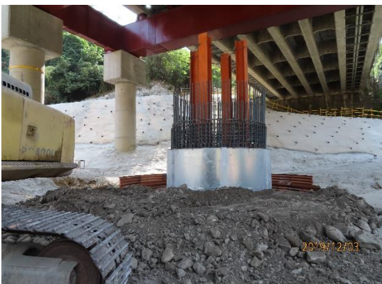
圖 4-7 水中混凝土澆置作業
