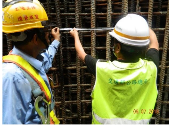
圖 4-5 鋼筋檢查
