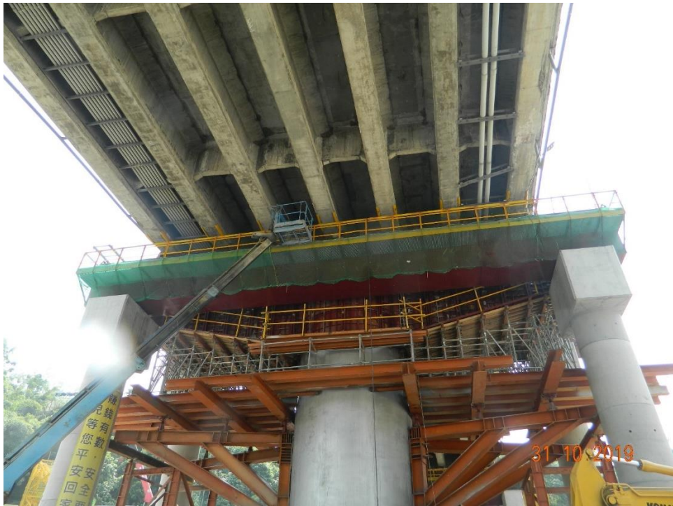
圖 4-15 設置安全護欄以防墜落
