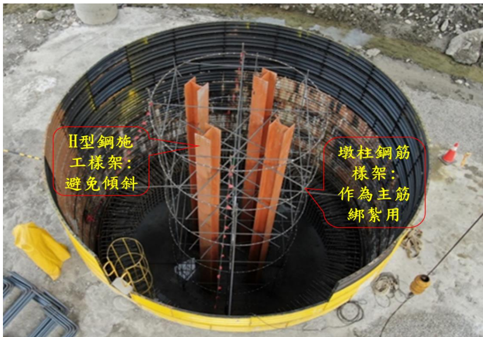
圖 4-9 墩柱施工樣架
