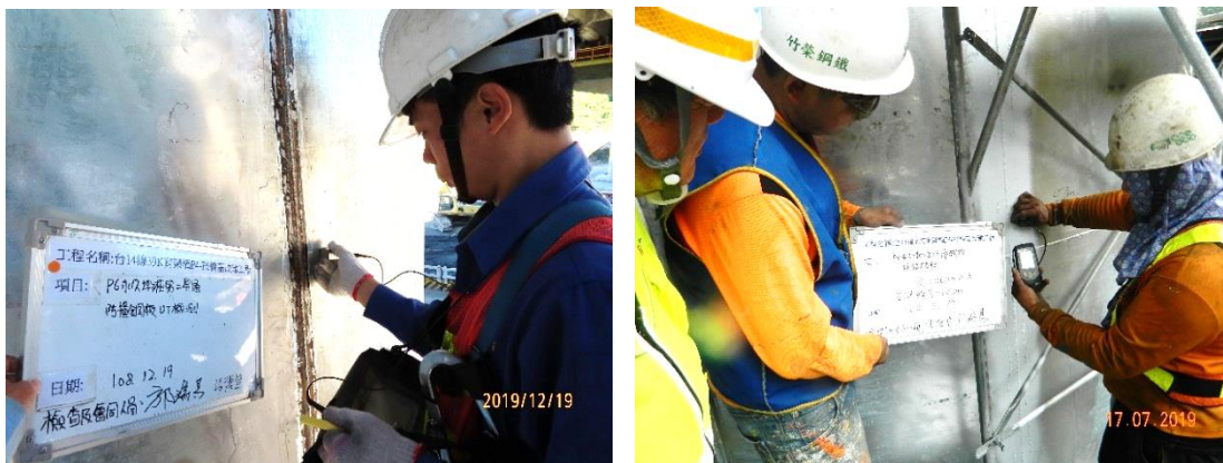
圖 4-11 防撞鋼版鋅鋁融射防鏽
