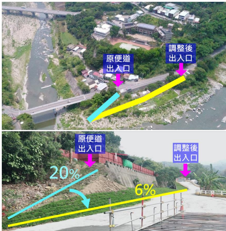
圖 6-1 調整路線將坡度由 20%降為 6%以下
