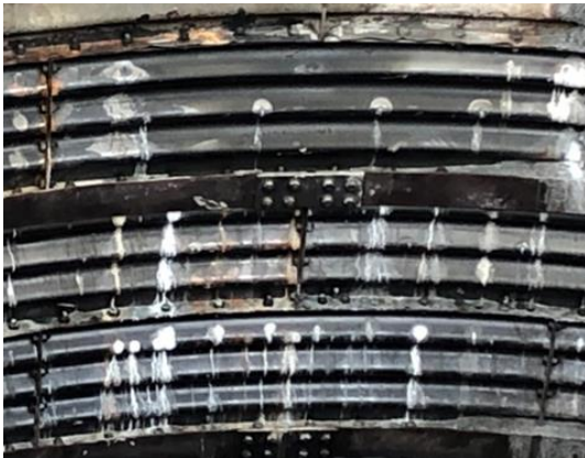
圖 4-4 鋼環襯回漿觀測孔及襯板高度抽查
