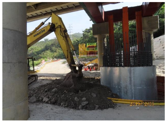
圖 4-7 水中混凝土澆置作業
