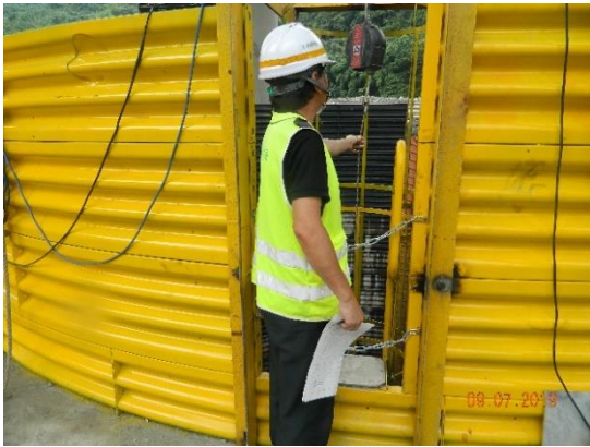
圖 4-5 鋼筋檢查
