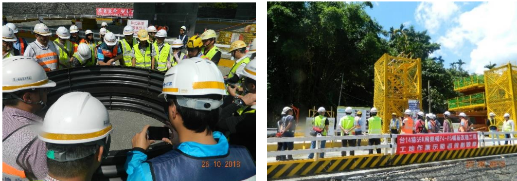
圖 5-2 井式鋼環襯版組立作業品質觀摩及工地作業示範規劃觀摩
