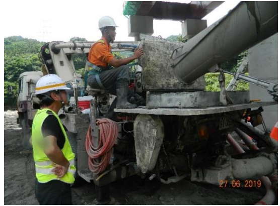
圖 4-6 水中混凝土澆置作業
