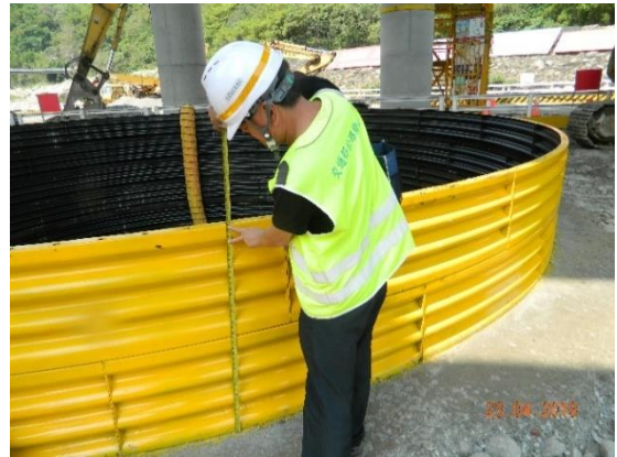
圖 4-4 鋼環襯回漿觀測孔及襯板高度抽查
