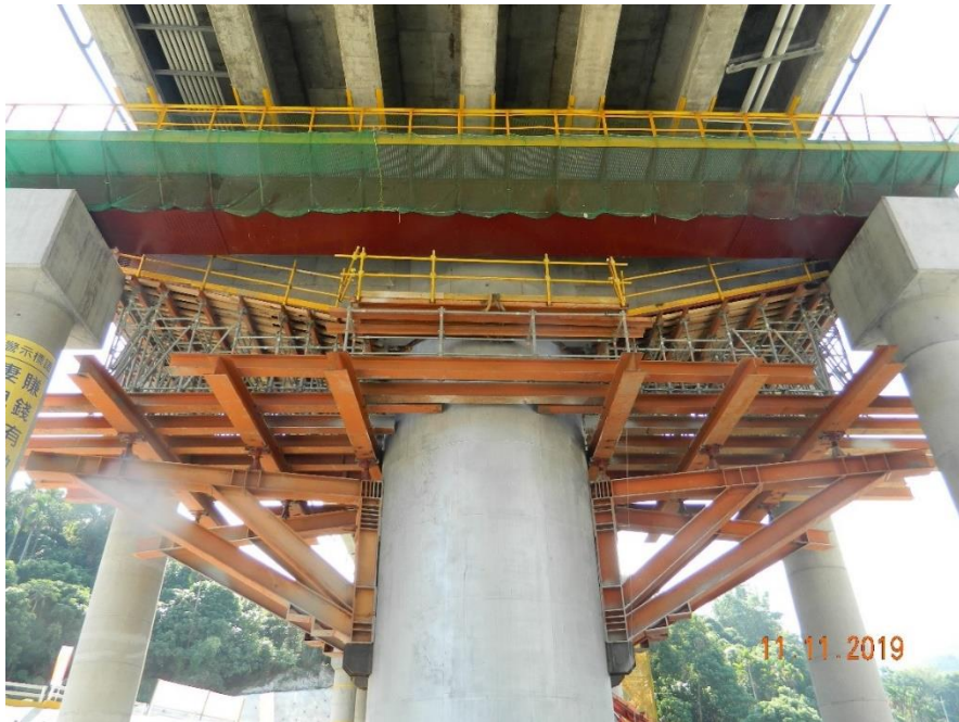
圖 4-16 帽梁側模拆除養護中
