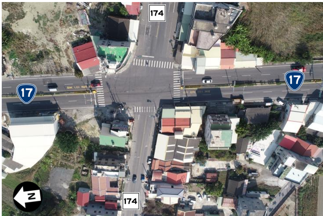
圖 3-4 台 17 線與市道 174 線路口改善前空拍俯視
