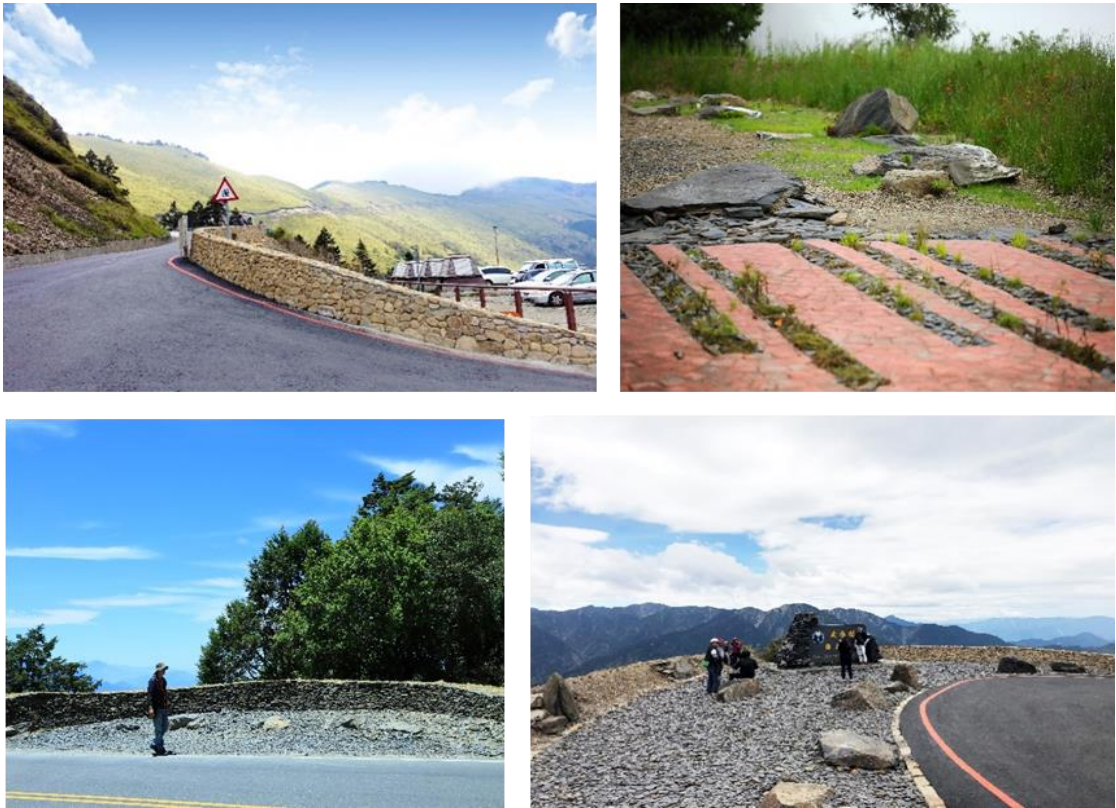
圖 11 利用現有環境資材及在地植物，柔化工程的創新環保公路。
