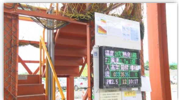
圖 33 AIoT 環境監測電子資訊看板
