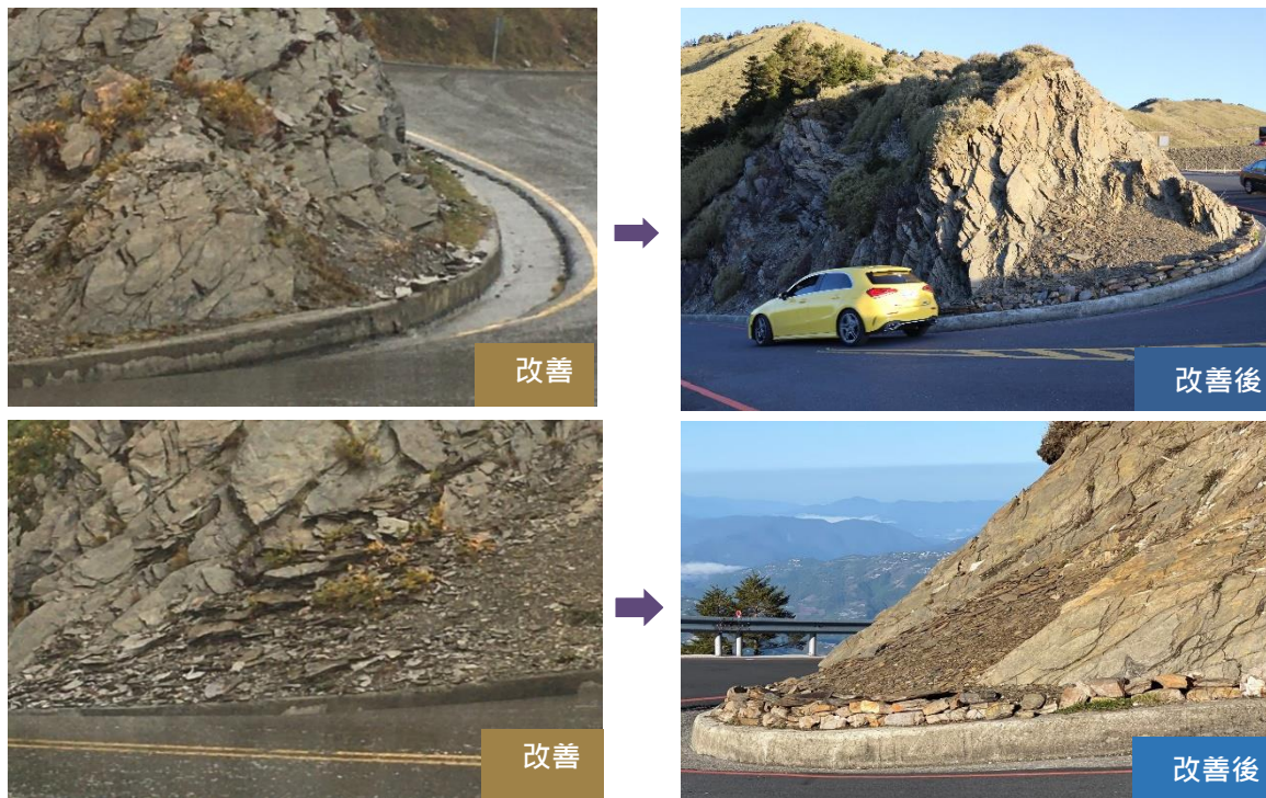
圖 9 清理公路兩側因凍融產生頁岩的碎石，柔化路堤的視覺量，行車中產生穿越於岩層景觀之中感覺。
