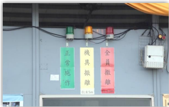
圖 30 IoT 物聯網監測安全警示
