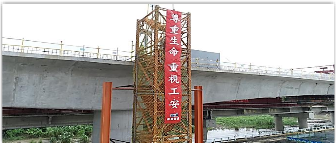
圖 9 完善 H 型鋼上下設備
