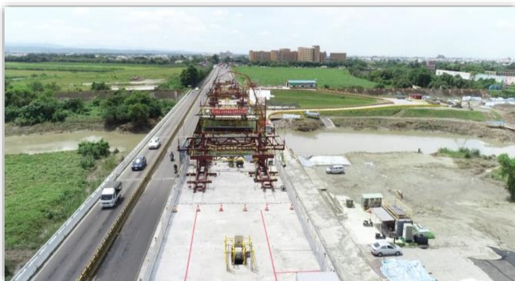
圖 10 高空作業警示圈圍
