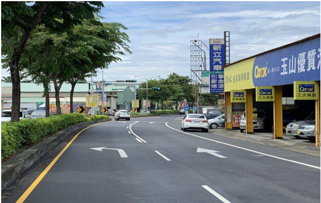
圖 3-4 台 3 線草溪路路面刨鋪，同時調整車道標線劃設
