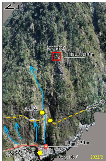
f. 111年本次崩塌後之邊坡情形
