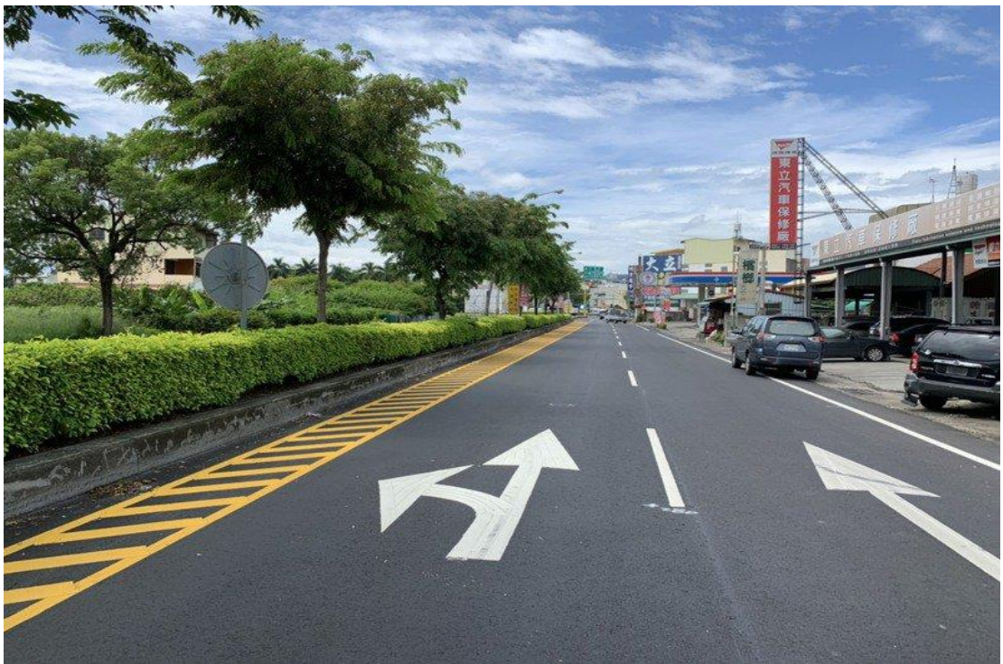
圖 3-5 台 3 線草溪路路面刨鋪，同時調整車道標線劃設
