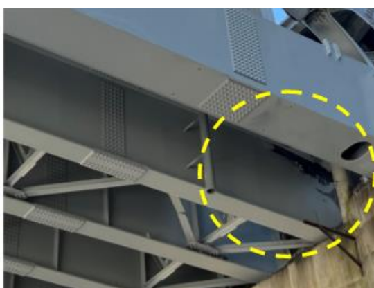
d. 鋼板梁塑性變形
