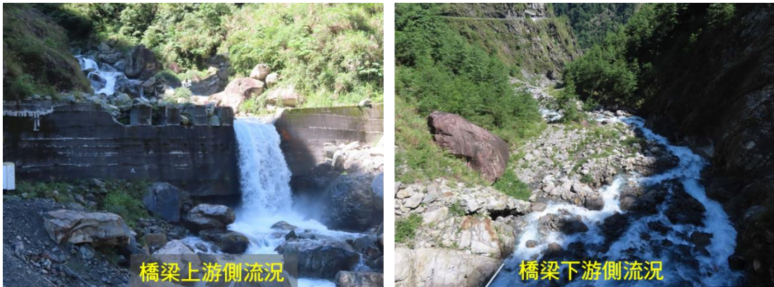
圖 19 鋼便橋上下游登仙溪之流況
