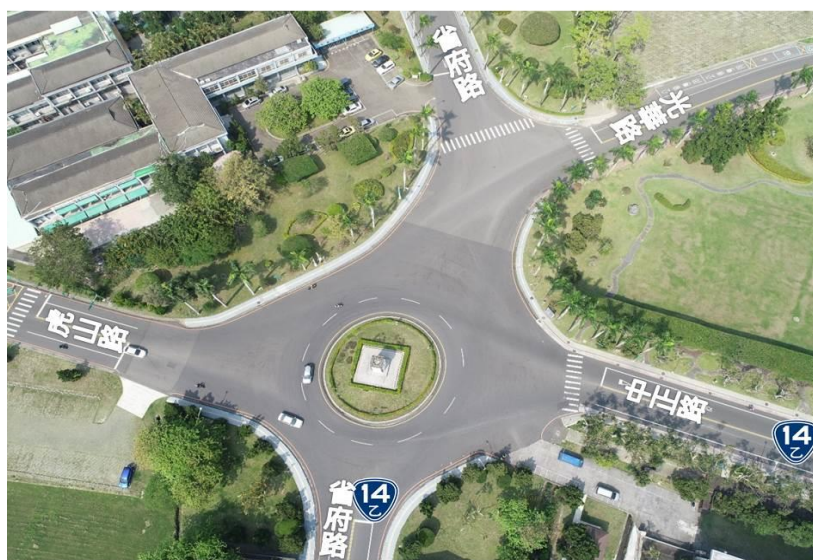
圖 6-2 台 14 乙線中興新村圓環標線改善前空拍圖
