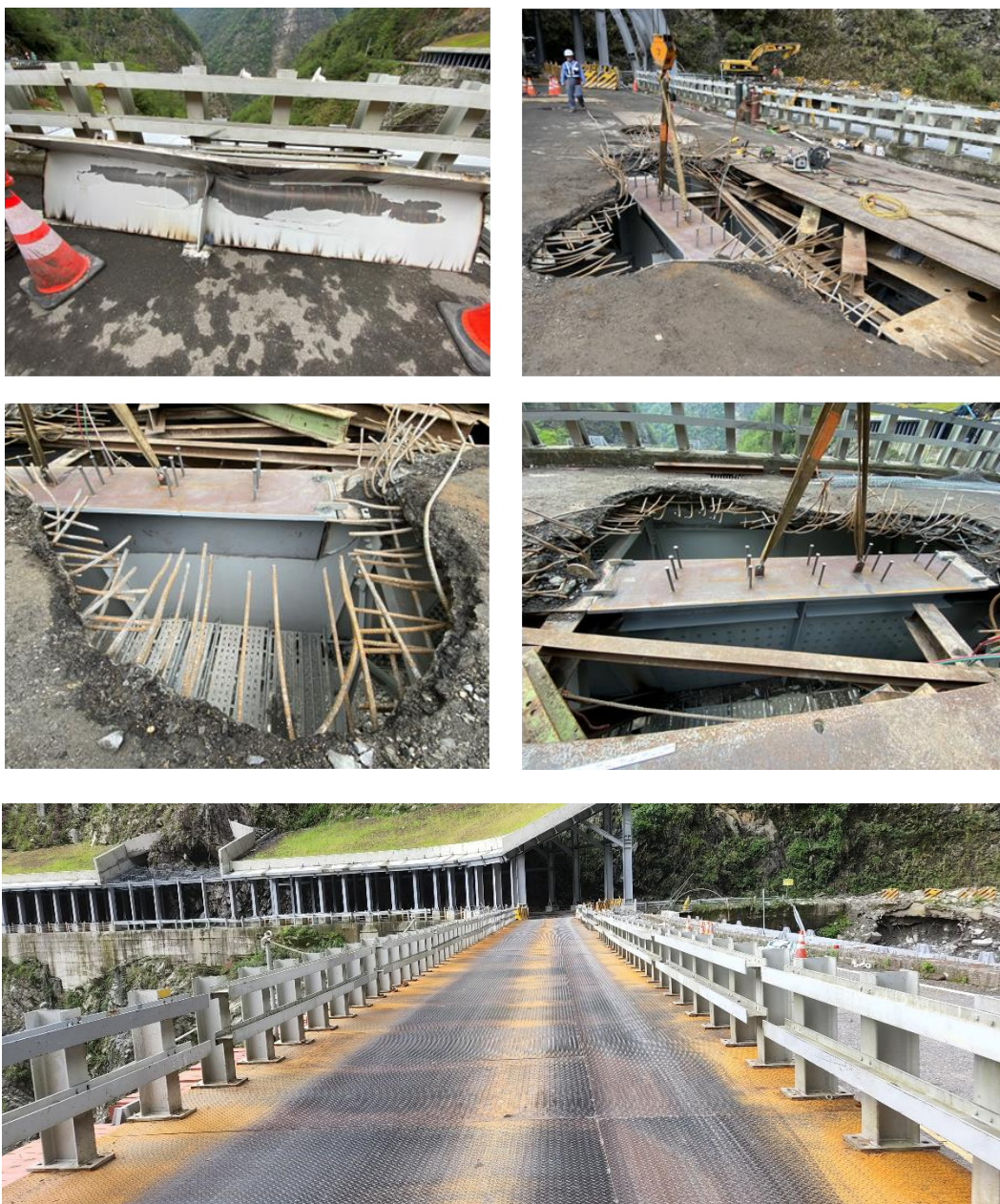
圖 21 G2 大梁修復及下游側上構補強拓寬後可供通行情形
