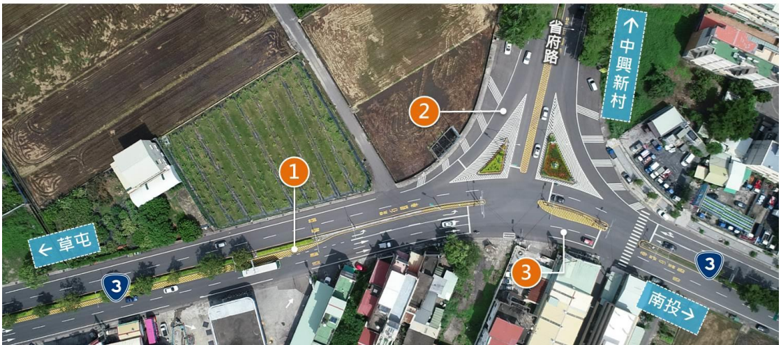
圖 3-9 台 3 線路段與省府路口看見標線改造
