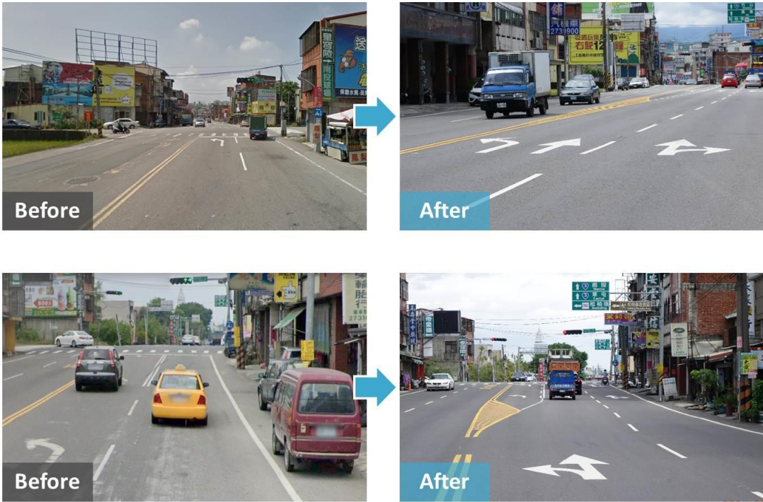
圖 4-5 台 3 線與 139 乙線路口車道重新配置及標線改造成果
