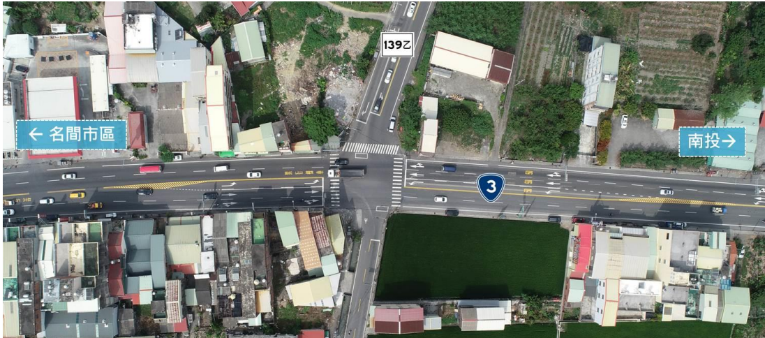
圖 4-3 台 3 線與 139 乙線路口車道重新配置及標線改造成果
