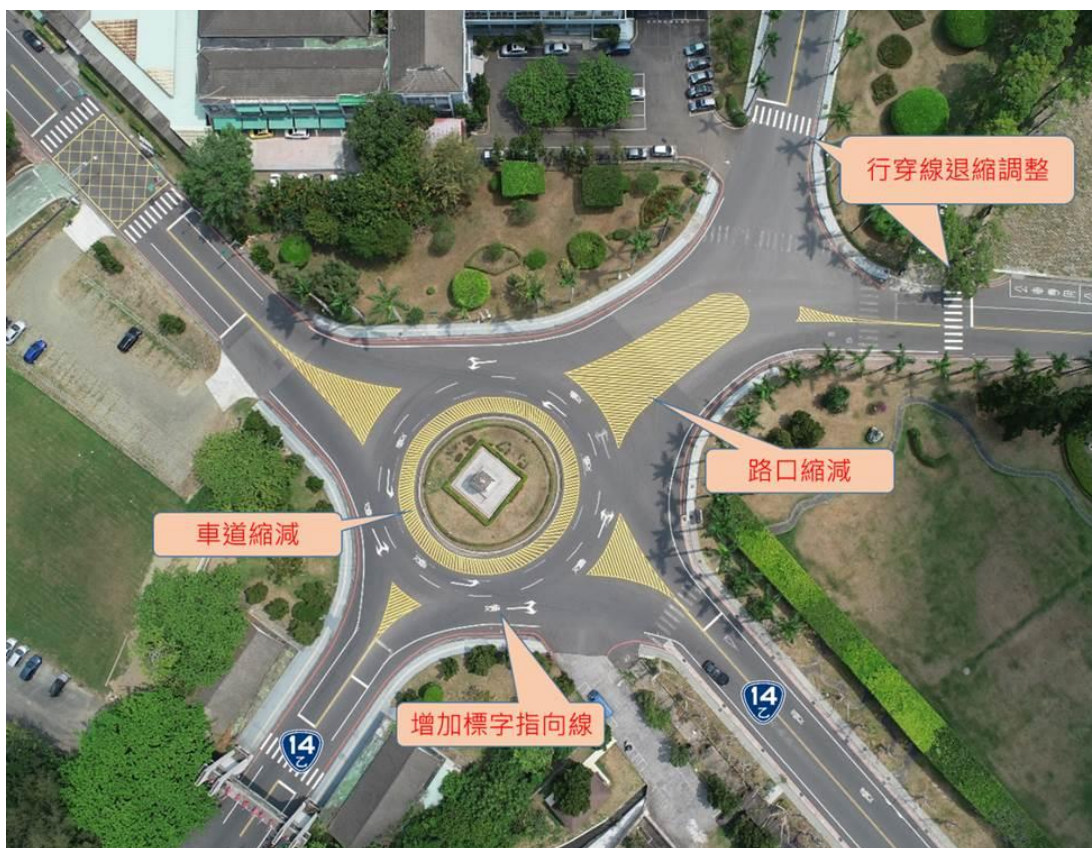
圖 6-8 台 14 乙線中興圓環標線槽化成果空拍
