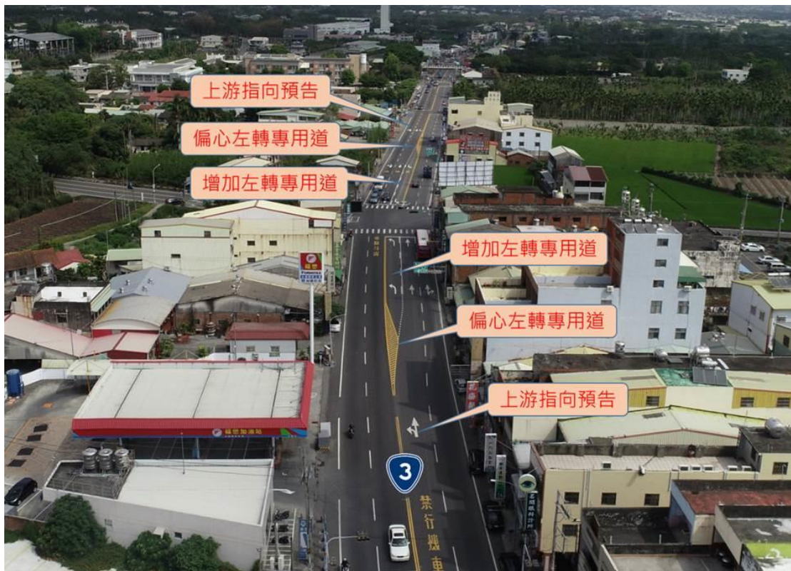
圖 4-4 台 3 線與 139 乙線路口車道重新配置及標線改造成果
