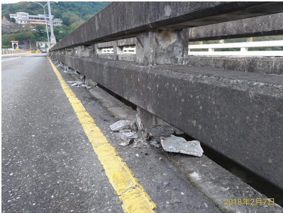
圖 7 P9~P10 二代橋護欄剪斷
