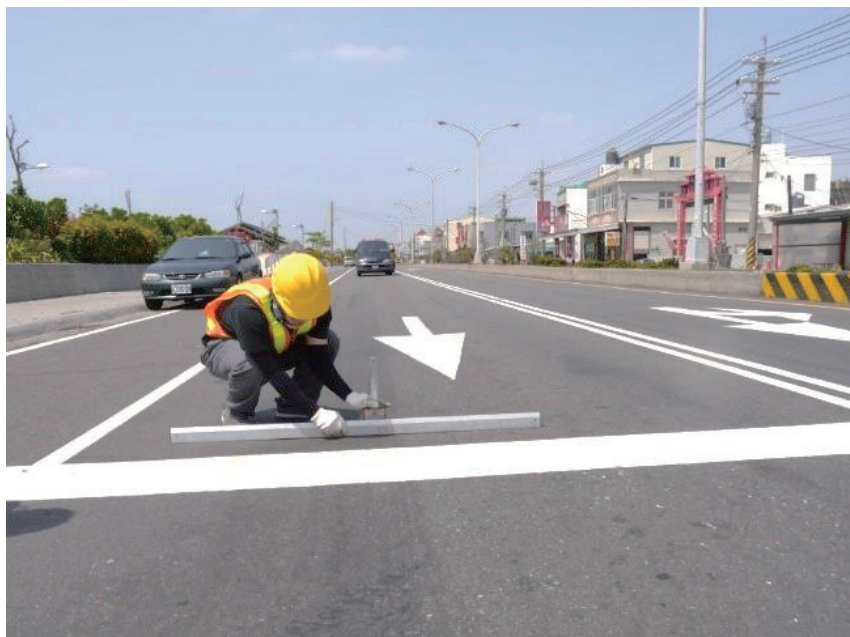
圖 1 現場目視鋪面狀況進行量測
