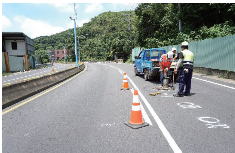
圖 3 瀝青混凝土回收黏度試驗試體取樣
