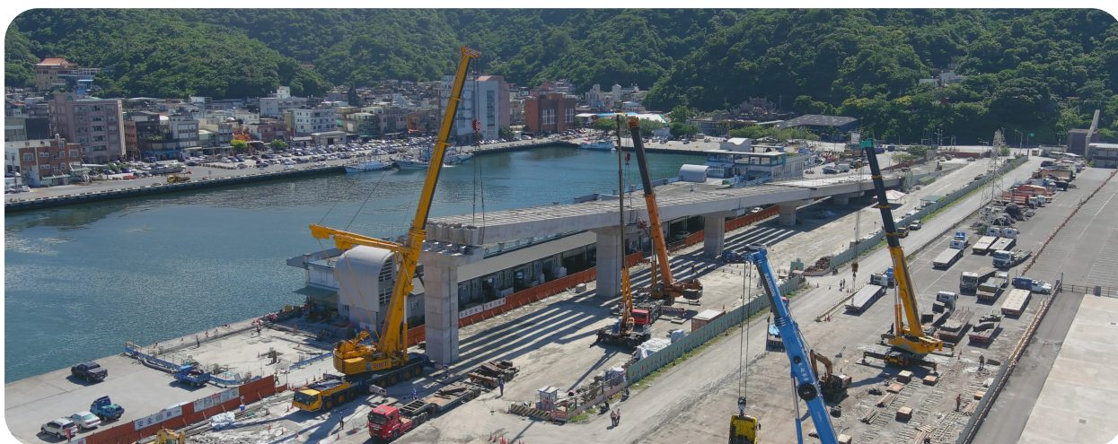
預鑄U型梁吊裝 Precast U-Beam Hoisting
