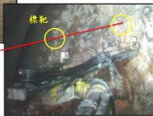
經緯儀設定後投射雷射線，計算得知雷射線方位角及高程，由鑽槍移至雷射線上，使前後標靶中心均在雷射線上，鑽實電腦輸入上述參數，自行算出鑽堡於隧道線形上之位置。
