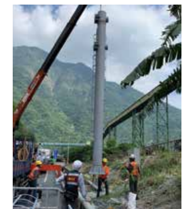
● 鋼構吊裝施工作業
