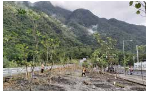
● 中仁隧道南口南下線邊坡黃槿（灌木）種植
