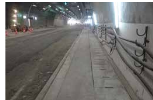
● A、B 型導線管群及消防管槽完成
