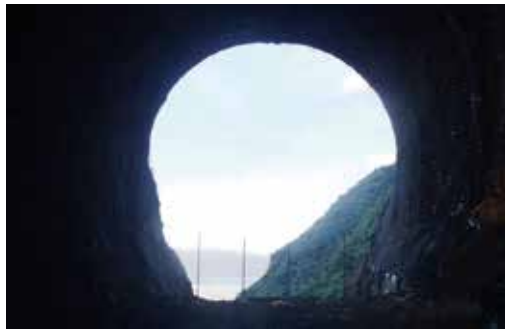
● 排氣排煙隧道開挖完成
