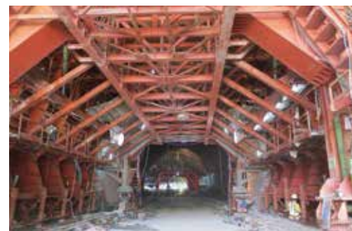
● 谷風隧道 10K 通風橫坑鋼模組裝
