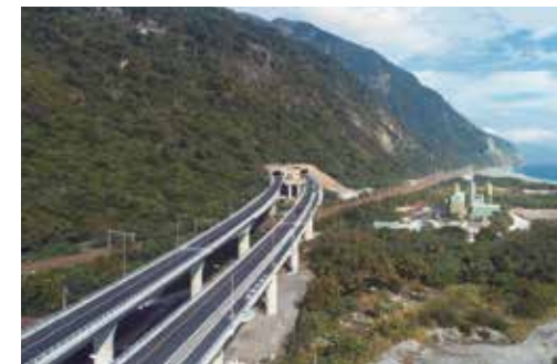
● 漢本高架橋空拍
