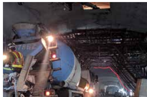
● C1A 通風隔板完成
