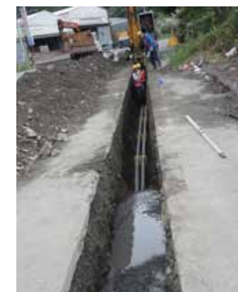
● 克尼布東路管道施工
