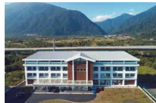
● 南澳基地 交控中心建築
