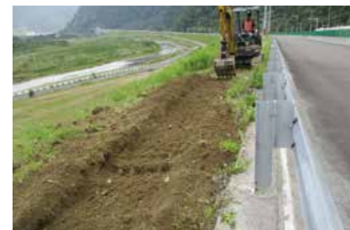
● 路堤北上車道沃土換置
