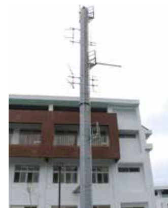
● 無線電鐵塔及天線實景
