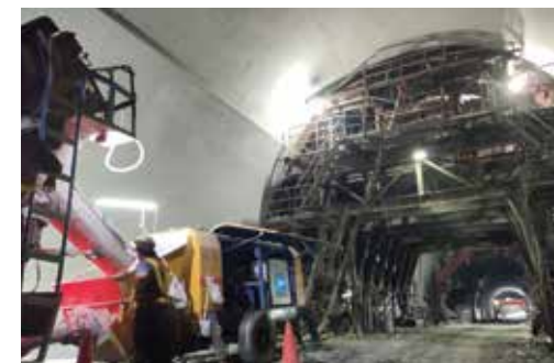
● 襯砌鋼模混凝土澆置
