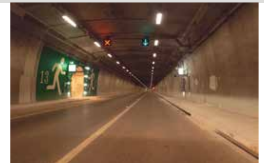
● 觀音隧道完工
