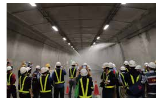
● 觀音隧道水霧系統全自動啟動噴灑
