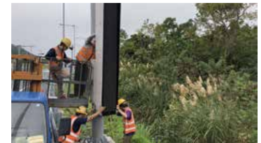
● 資訊可變標誌吊裝施工作業
