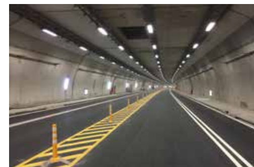
● 路面 AC 鋪設完成
