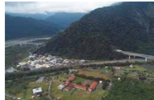
● 南澳路堤及武塔高架橋
