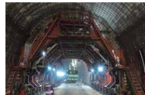
● 谷風隧道抽坍段襯砌混凝土澆置
