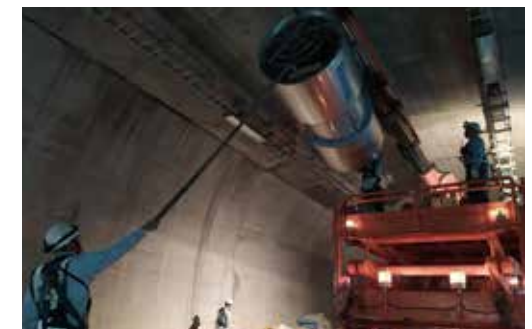
● 隧道噴流式風機安裝
