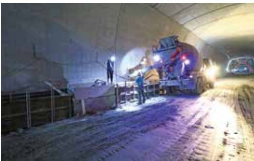
● 第 1 層層混凝土澆置
