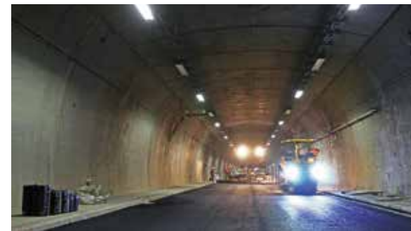
● 瀝青混凝土鋪築
