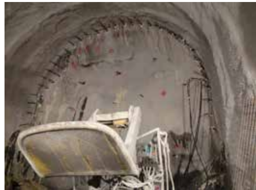
● 排氣排煙隧道開挖
