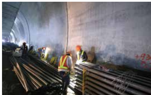
● 東側 A 型導線管群配管
