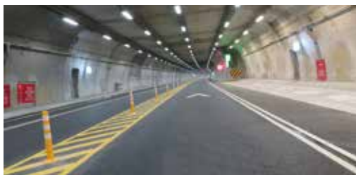
● 隧道內部區照明
