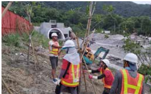
● 中仁隧道南口左側邊坡喬木種植
