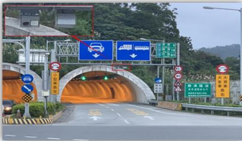
圖 3-4 蘇花改車牌辨識系統架設位置及實際相片
