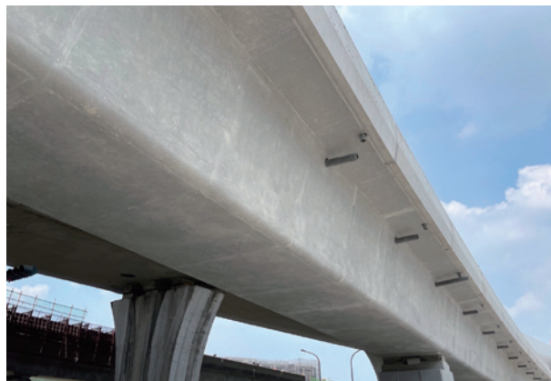
腹板採用一次性灌漿施工，無施工縫，外型美觀
