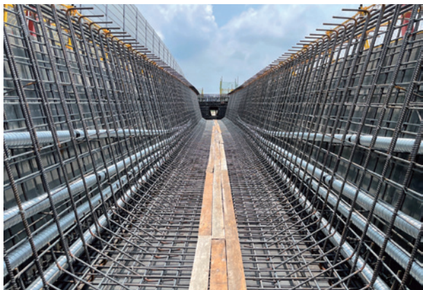
底腹板與預力套管配置平順、間距符合規範
