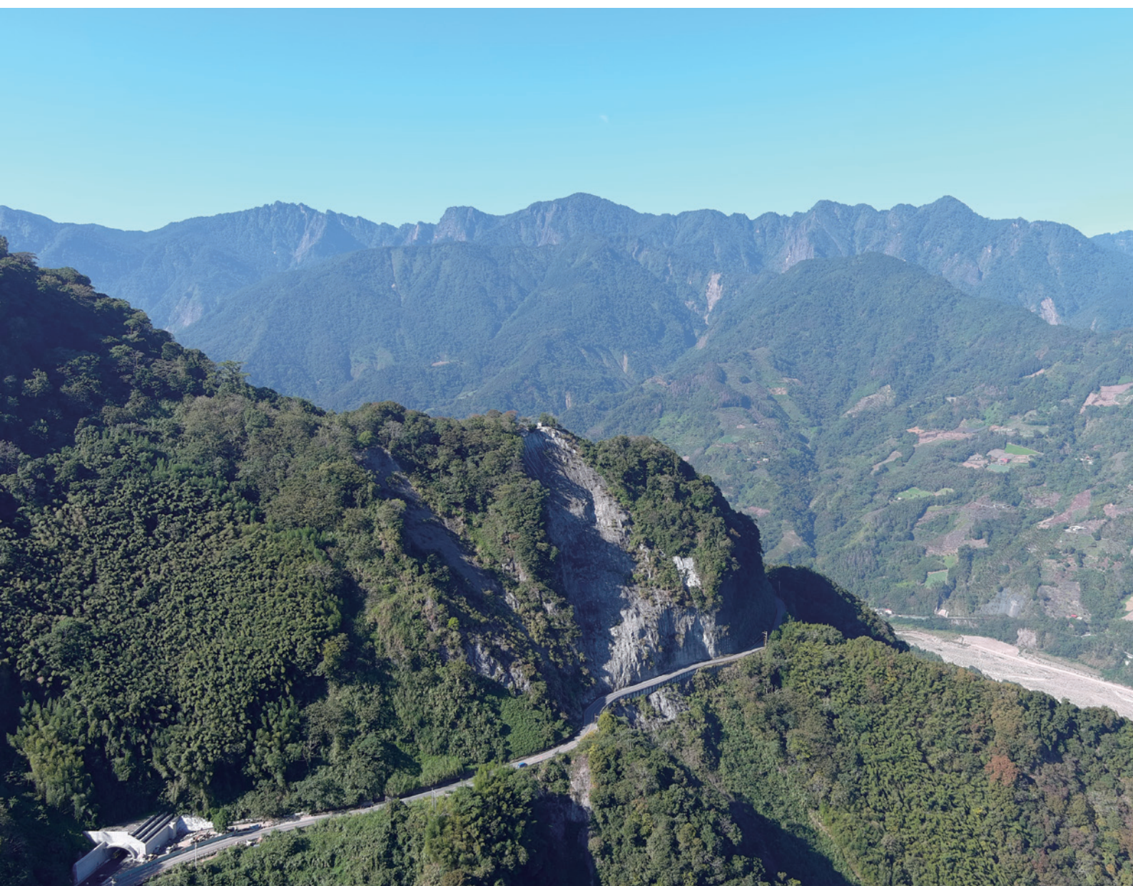
隧道東洞口空拍
