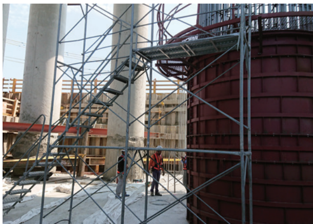
第一階段 P423 墩柱組模
