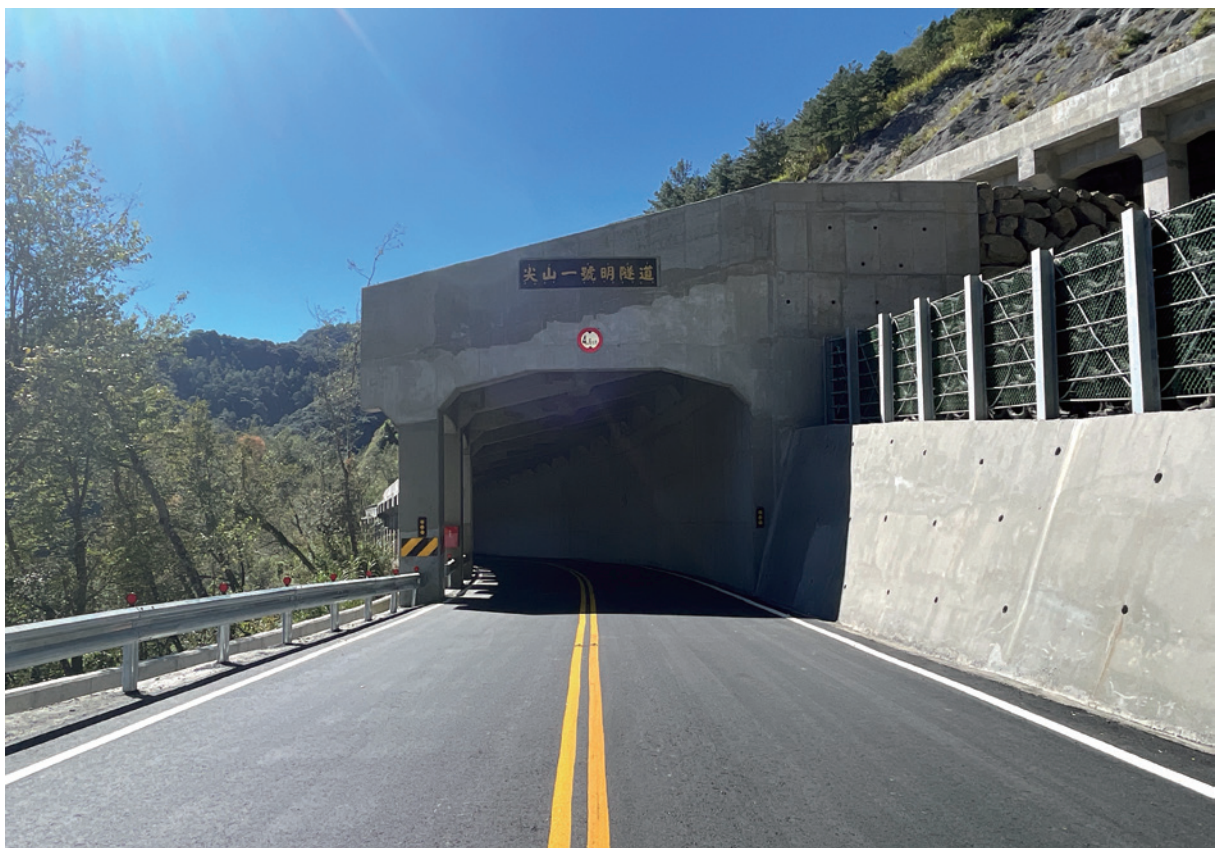
全工區完工照片
