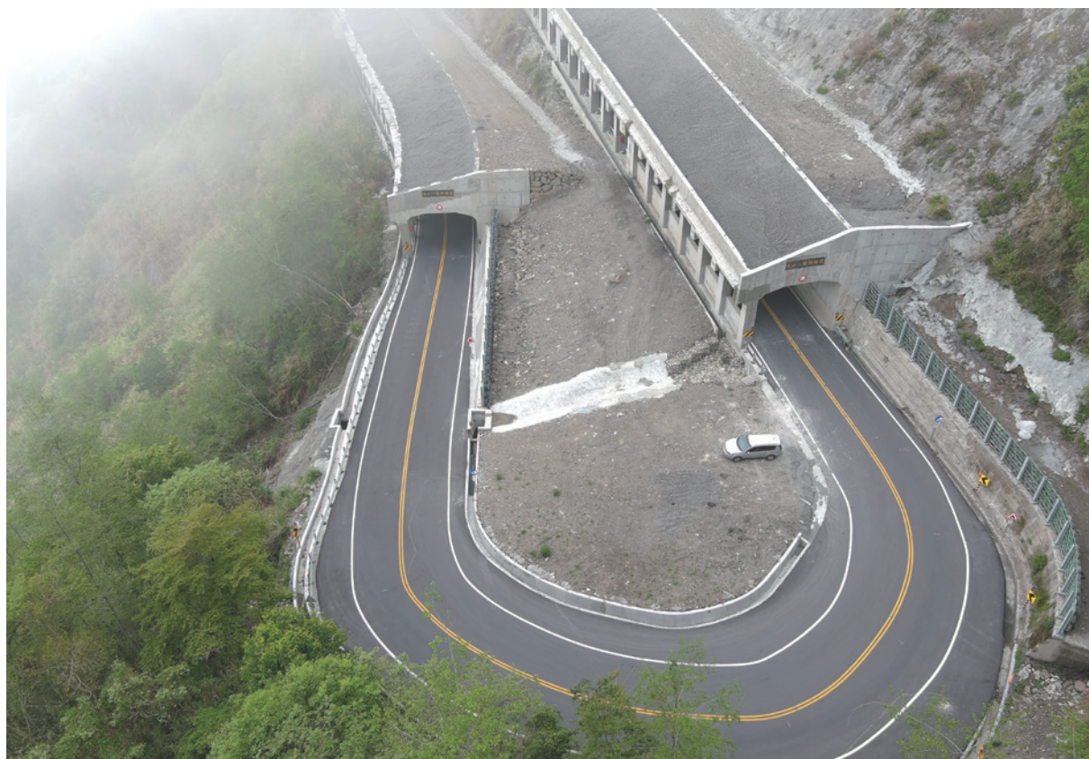
兩隧道間之髮夾彎情形
