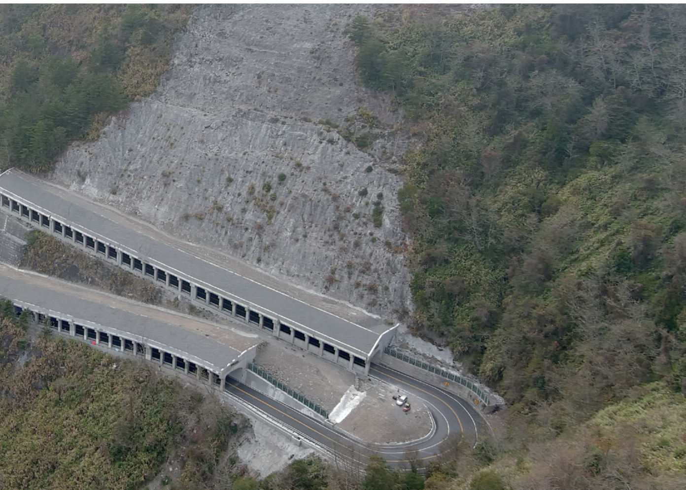
尖山一、二號明隧道全景
