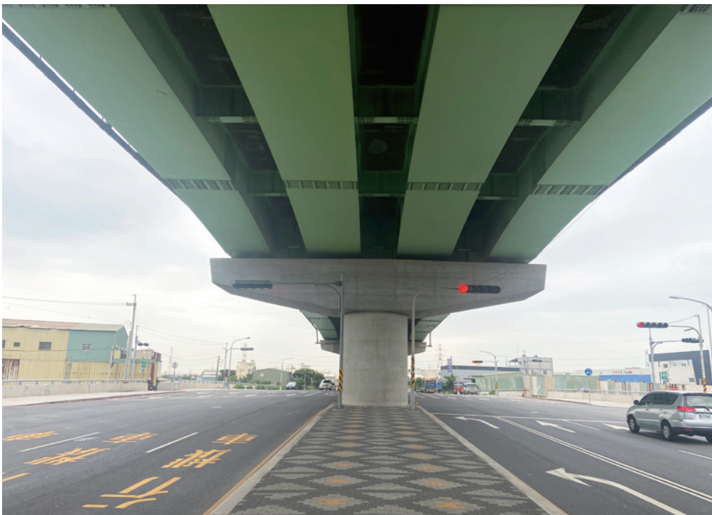
台 61 線山腳大排橋改建工程竣工照片
