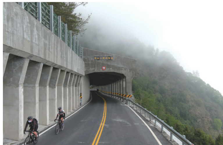
尖山二號明隧道內照片
