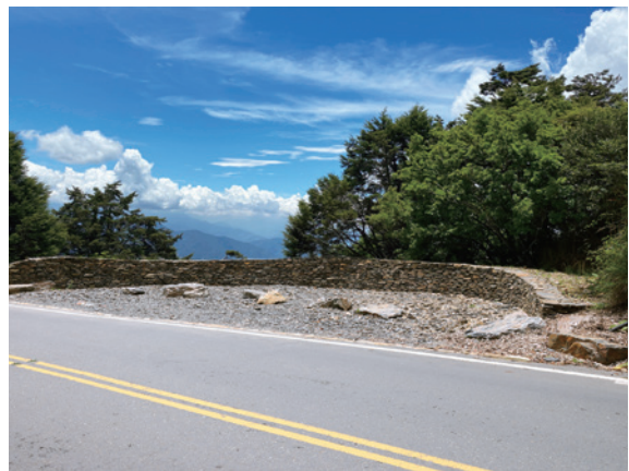
運用現地頁岩作為隙地矮牆素材，拆除礙景人造物，再造旅人休憩觀景平台，具體的公路景觀改善成效，對於高山生態及視覺質量服務加值
