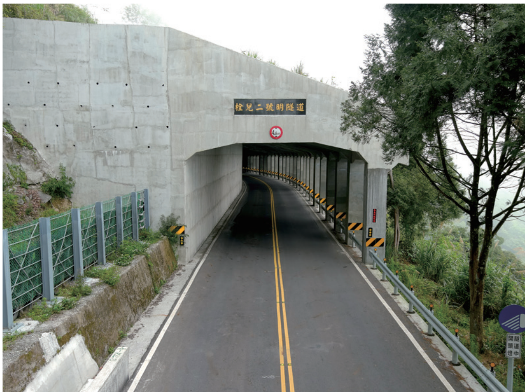
全工區完工照片
