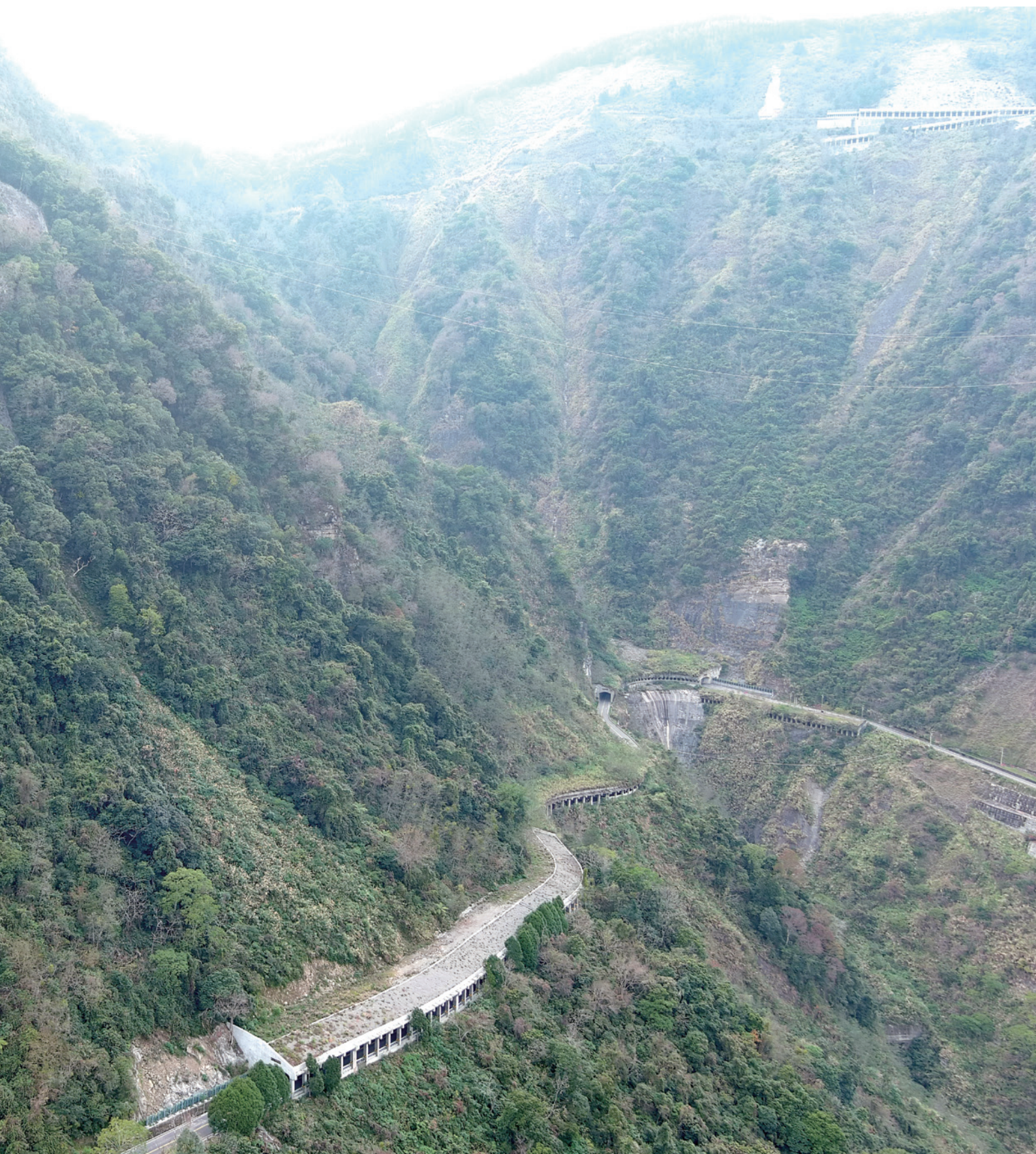
新建完成之日月隧道
