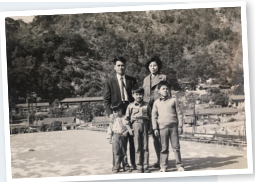
三代東卯橋，橋長 100 公尺，橋寬 7.5 公尺，主辦工程師趙世治（後左一）帶著家人在橋上合影，趙令杰（前右一）當時 10 歲，攝於 1973 年。
