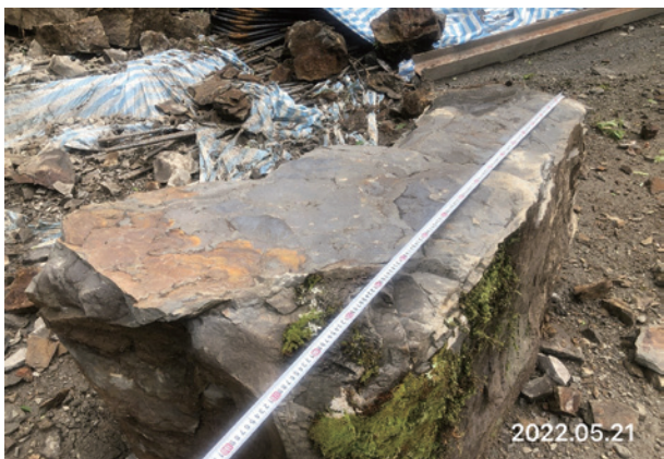
隧道洞口落石及枯樹掉落情形
