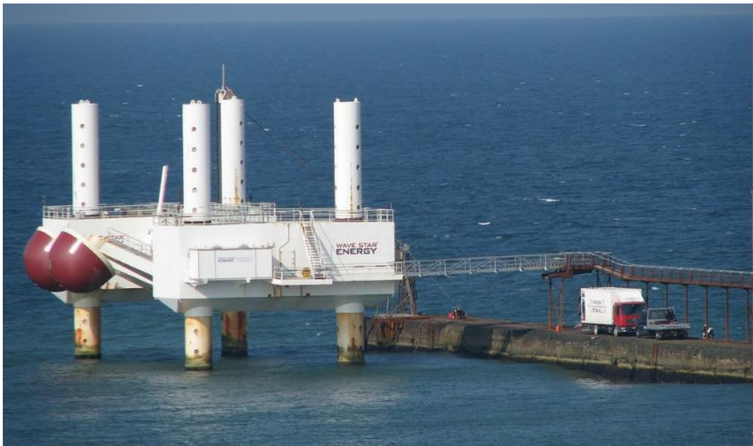
位在丹麥的Wave Star波浪能機組。圖片來源：維基百科Martin Měřinský ( CC BY-SA 4.0 )
