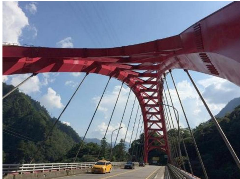
照片來源：台8線33K路段 篤銘橋
