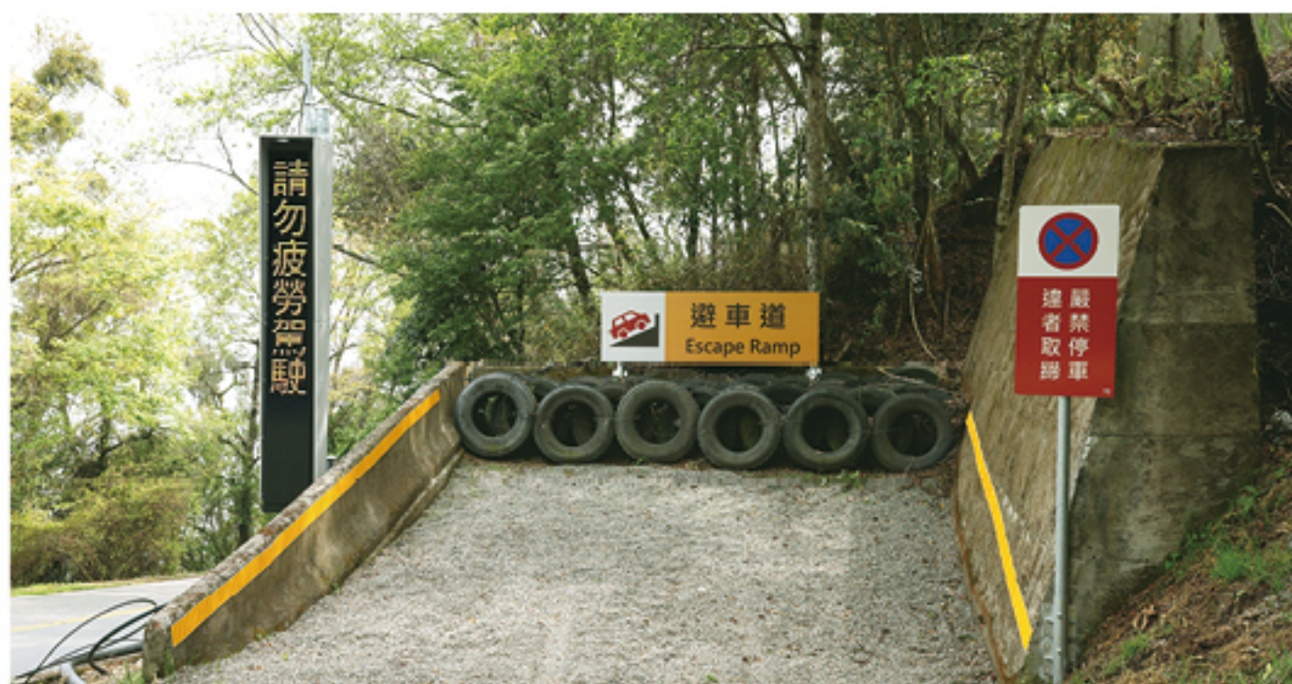
台 14 甲設置避車道緩衝空間
