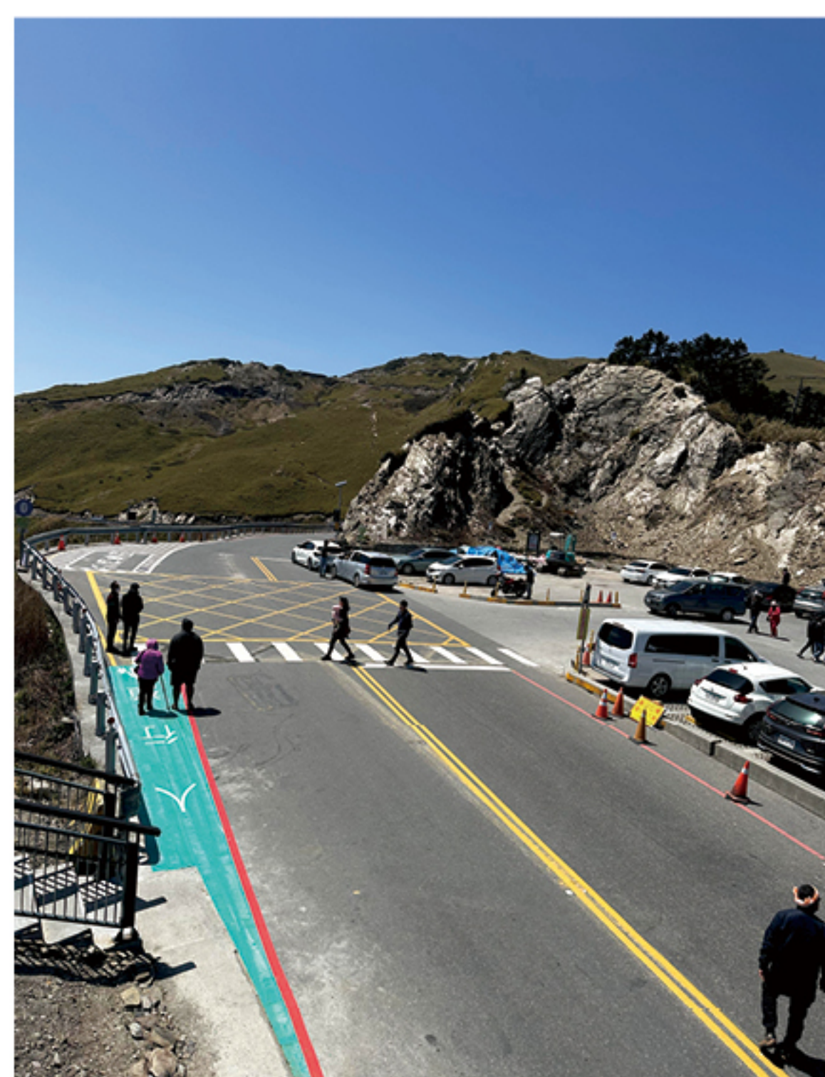
武嶺亭路口改善
