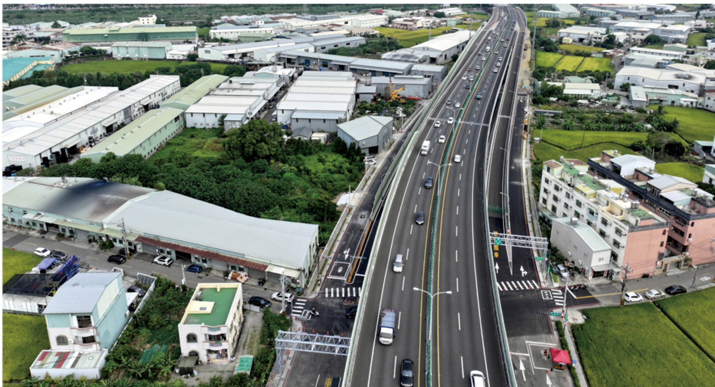
台 74 線大里及霧峰地區增設匝道工程（台 74 線草湖交流道）全景
