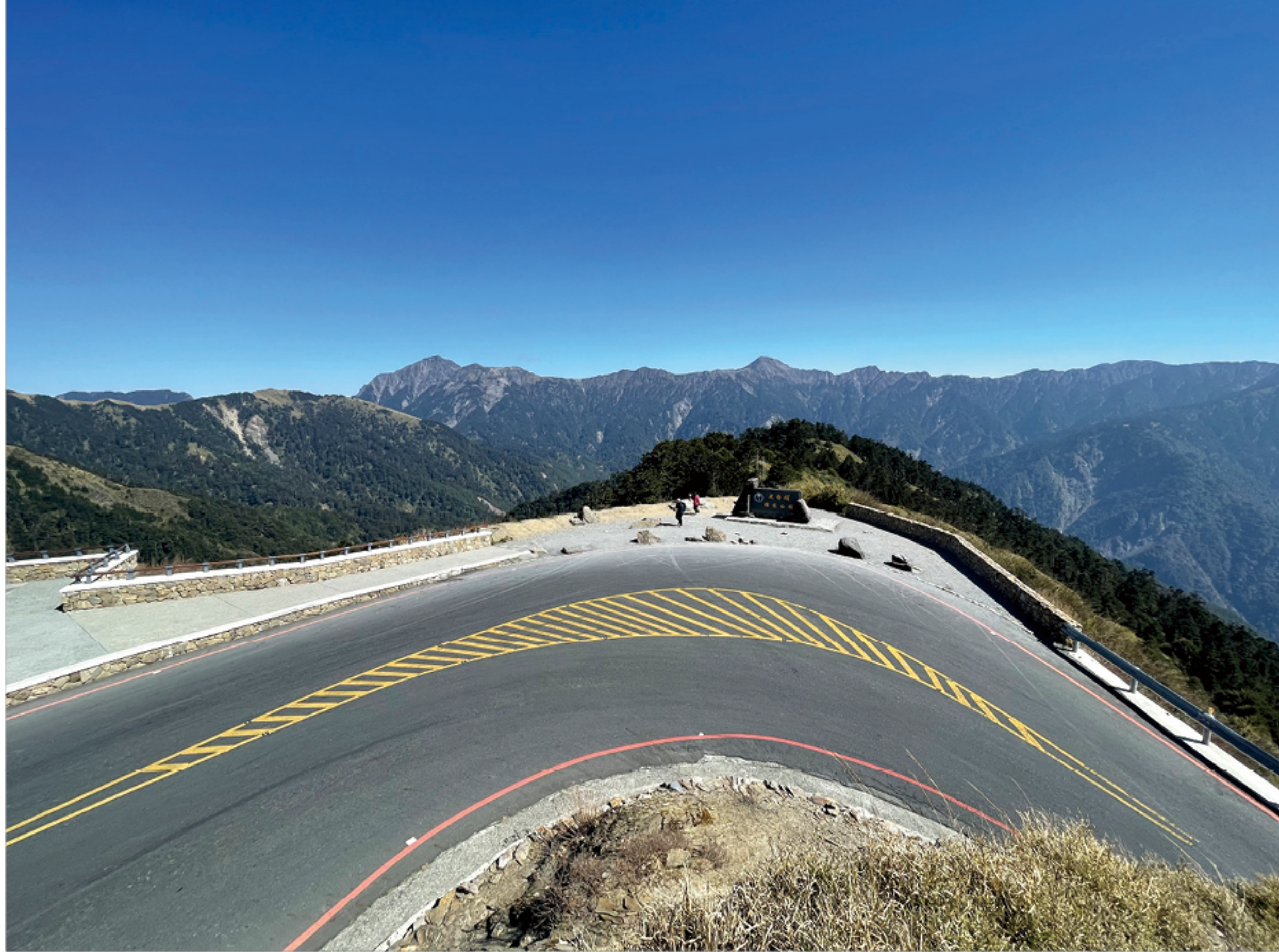
增設月牙彎槽化線分隔車流，提升公路安全
