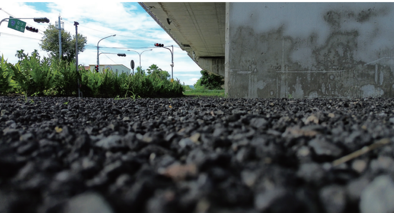
循環經濟實踐：再生瀝青刨除料（RAP）
