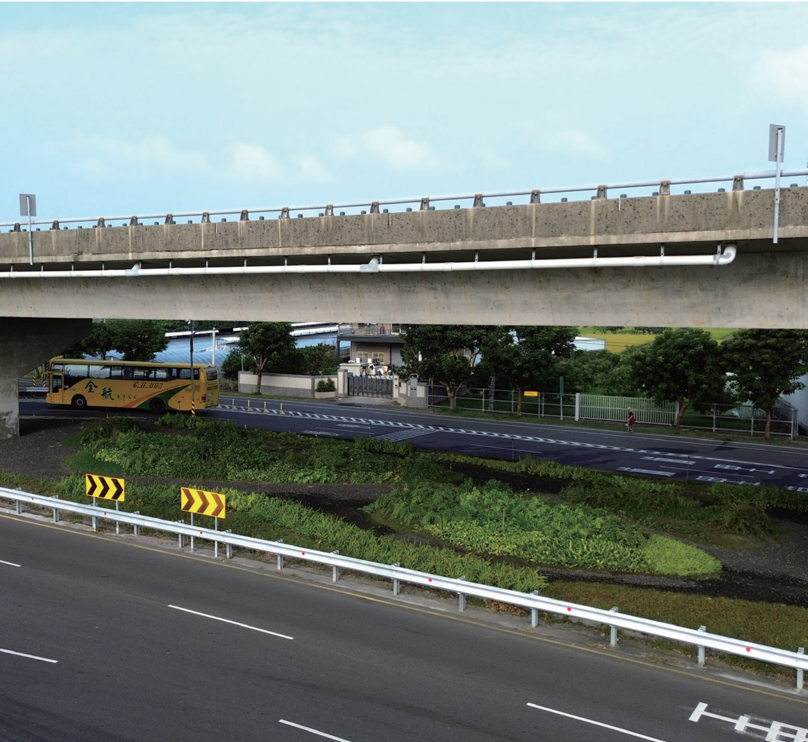
結合再生瀝青鋪面與複層植栽，將閒置橋下空間轉化為具生態效益的綠色廊道
