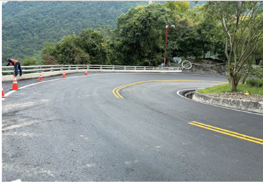
瀝青混凝土路面修護完成
