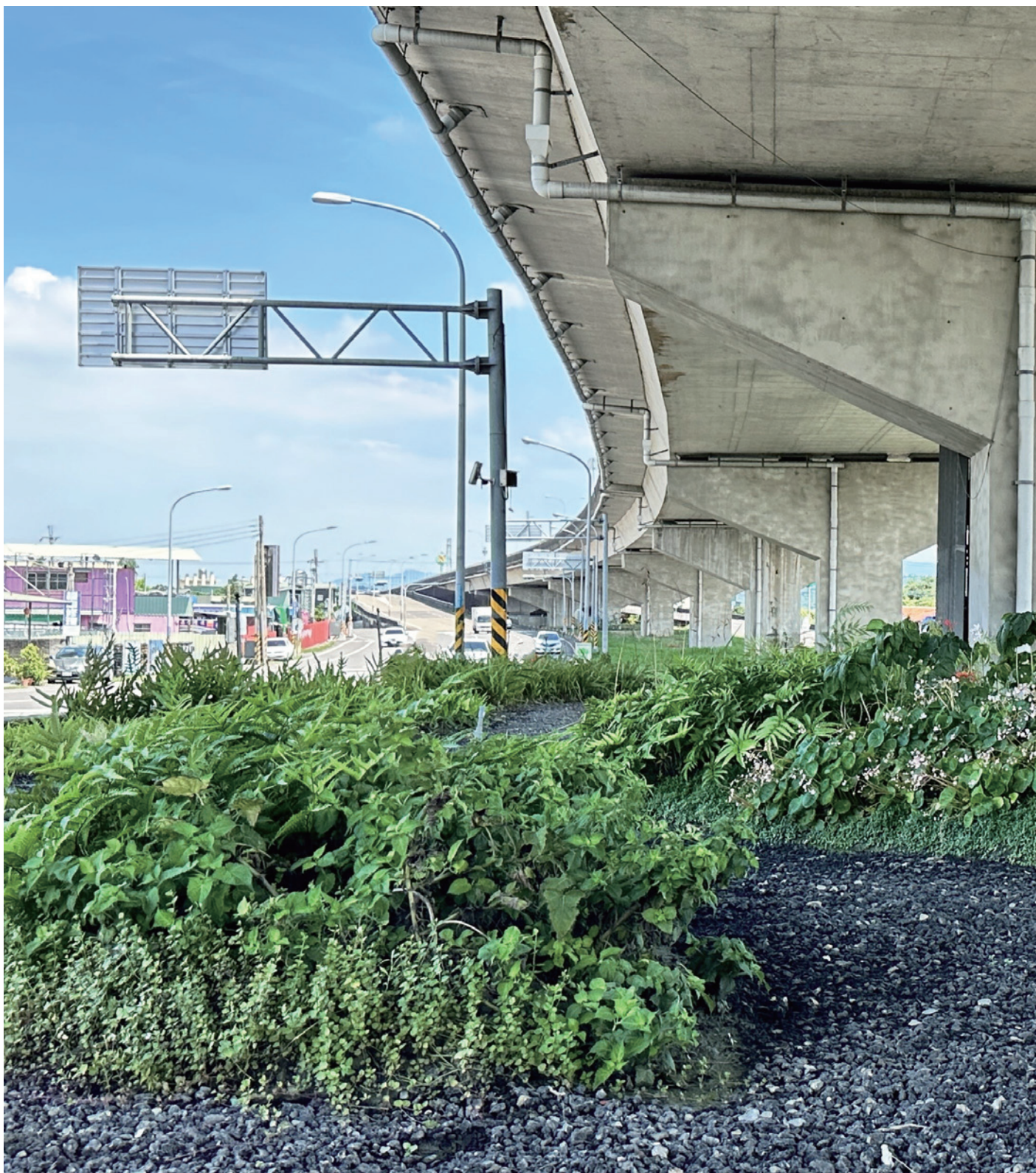
結合再生瀝青鋪面與複層植栽，將閒置橋下空間轉化為具生態效益的綠色廊道
