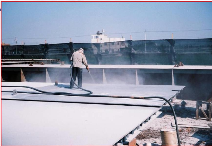
人工噴砂(鋼床板噴砂)
