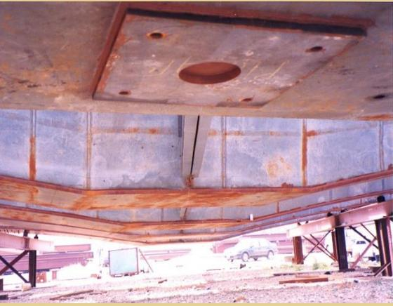
檢測位置為下翼板支承中心（承壓加勁板厚度方向中心）引至上翼板之位置
