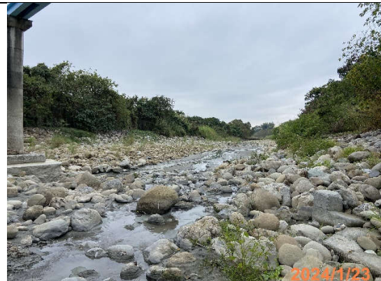
基地內環境現況
