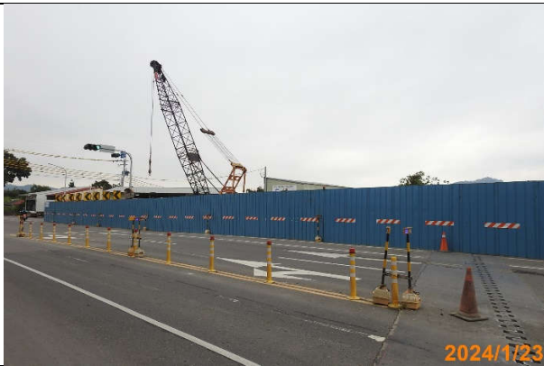
基地內環境現況
