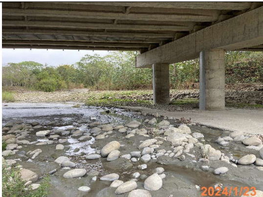
基地內環境現況
