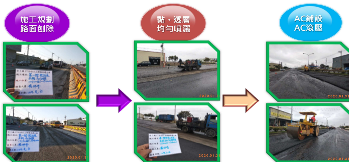
圖3-5瀝青混凝土施工流程
