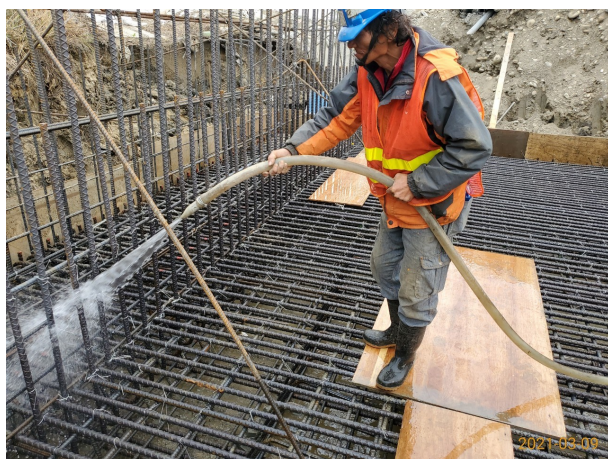
5. 懸臂式擋土牆基礎鋼筋清洗
