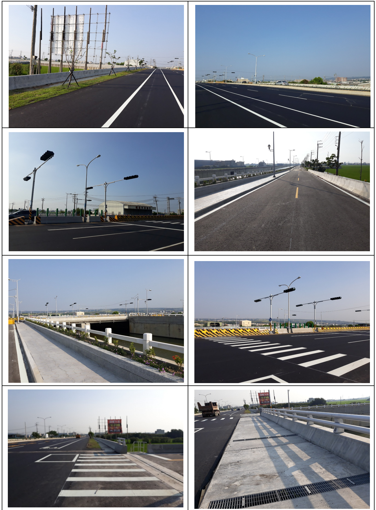
圖 4-10 竣工精彩照片
