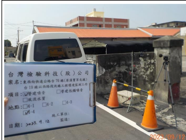
照片說明：營建噪音 拍攝地點：4-4 監測時間：112.09.12
