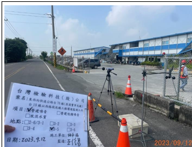
照片說明：營建噪音 拍攝地點：3-5 監測時間：112.09.12
