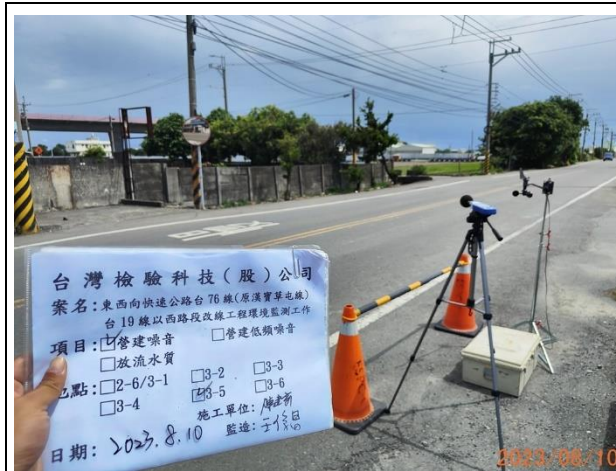
照片說明：營建噪音 拍攝地點：3-5 監測時間：112.08.10
