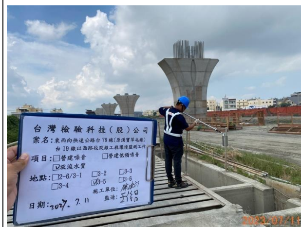
照片說明：工區放流水 拍攝地點：3-5 監測時間：112.07.11
