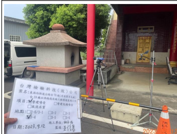
照片說明：營建噪音 拍攝地點：3-4 監測時間：112.09.12
