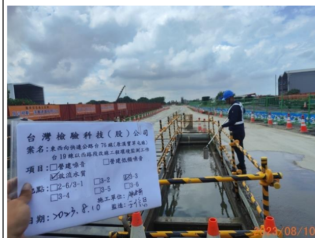
照片說明：工區放流水 拍攝地點：3-3 監測時間：112.08.10
