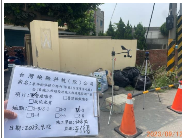
照片說明：營建噪音 拍攝地點：3-3 監測時間：112.09.12
