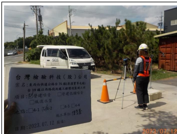
照片說明：營建噪音 拍攝地點：4-2 監測時間：112.07.12
