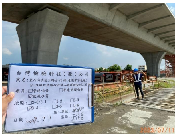
照片說明：工區放流水 拍攝地點：3-4 監測時間：112.07.11
