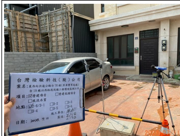
照片說明：營建噪音 拍攝地點：2-6/3-1 監測時間：112.07.11
