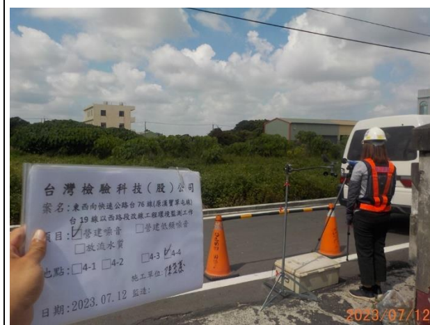
照片說明：營建噪音 拍攝地點：4-4 監測時間：112.07.12
