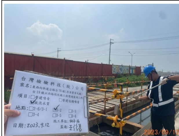
照片說明：工區放流水 拍攝地點：3-2 監測時間：112.09.12
