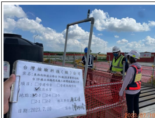
照片說明：工區放流水 拍攝地點：2-3 監測時間：112.07.10
