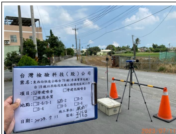
照片說明：營建噪音 拍攝地點：3-2 監測時間：112.07.11
