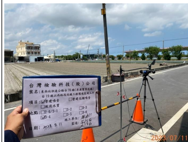
照片說明：營建噪音 拍攝地點：3-4 監測時間：112.07.11
