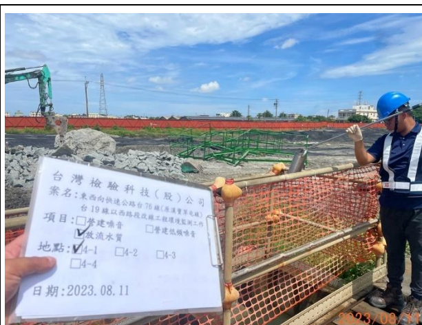
照片說明：工區放流水 拍攝地點：4-1 監測時間：112.08.11
