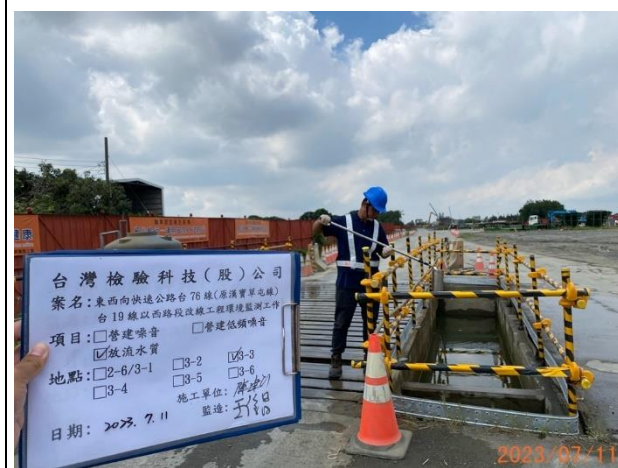
照片說明：工區放流水 拍攝地點：3-3 監測時間：112.07.11
