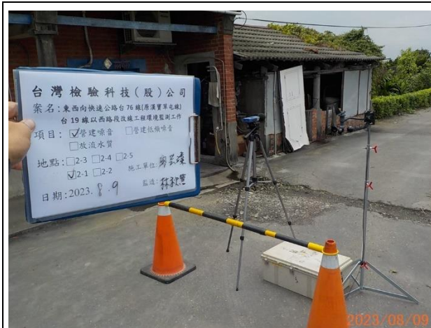
照片說明：營建噪音 拍攝地點：2-1 監測時間：112.08.09
