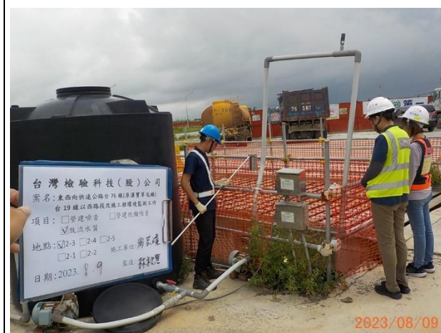
照片說明：工區放流水 拍攝地點：2-3 監測時間：112.08.09
