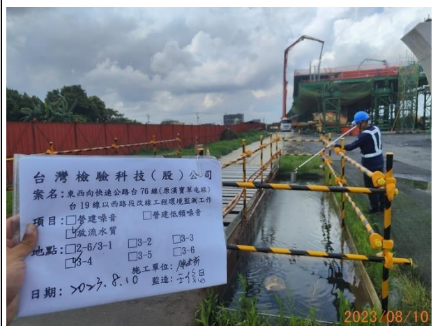
照片說明：工區放流水 拍攝地點：3-4 監測時間：112.08.10
