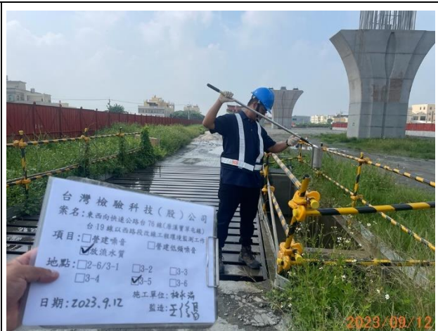
照片說明：工區放流水 拍攝地點：3-5 監測時間：112.09.12
