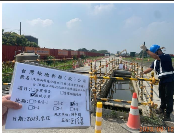
照片說明：工區放流水 拍攝地點：3-3 監測時間：112.09.12
