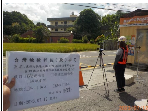
照片說明：營建噪音 拍攝地點：4-3 監測時間：112.07.12
