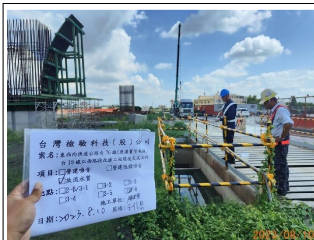
照片說明：工區放流水 拍攝地點：3-6 監測時間：112.08.10
