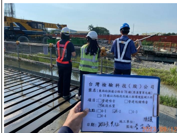
照片說明：工區放流水 拍攝地點：4-2 監測時間：112.09.12
