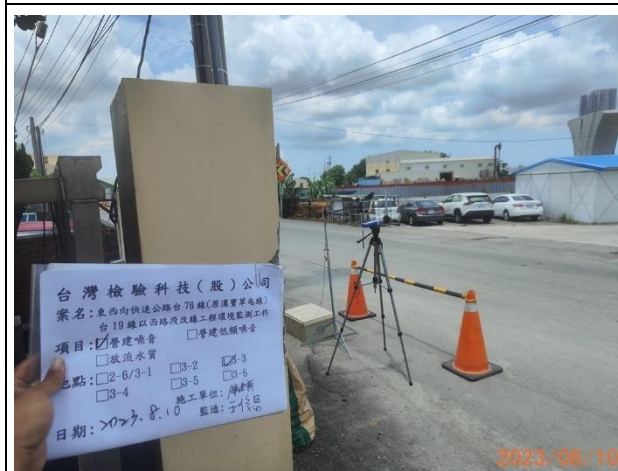
照片說明：營建噪音 拍攝地點：3-3 監測時間：112.08.10
