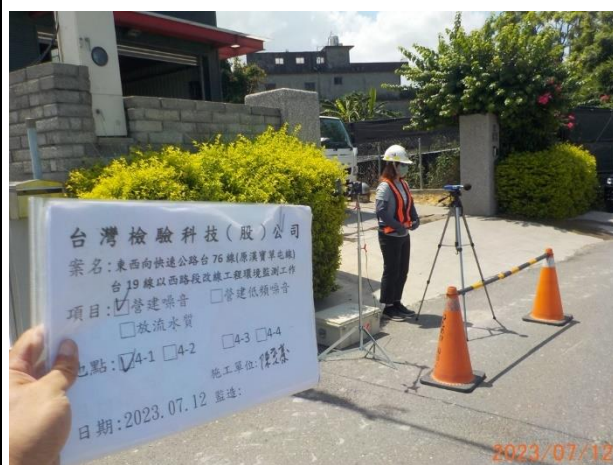
照片說明：營建噪音 拍攝地點：4-1 監測時間：112.07.12
