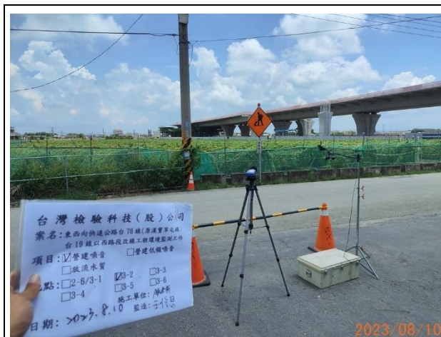
照片說明：營建噪音 拍攝地點：3-2 監測時間：112.08.10
