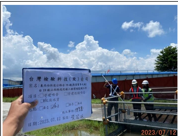
照片說明：工區放流水 拍攝地點：4-2 監測時間：112.07.12
