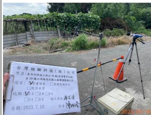
照片說明：營建噪音 拍攝地點：2-3 監測時間：112.07.10
