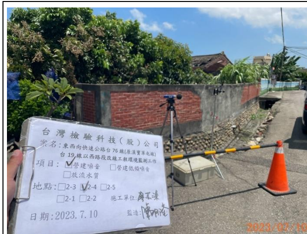
照片說明：營建噪音 拍攝地點：2-4 監測時間：112.07.10
