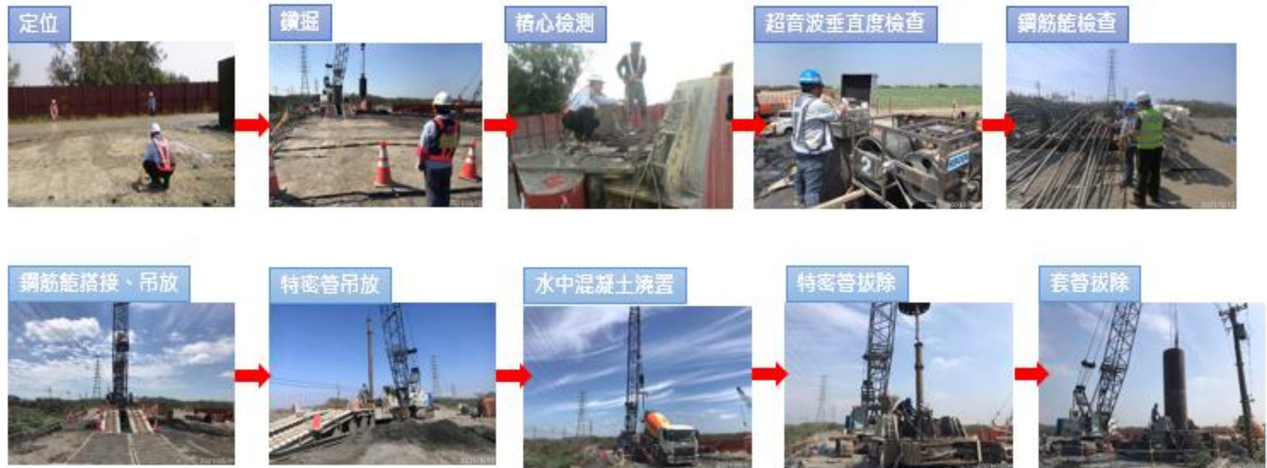
圖 8-8 基樁施工相片
