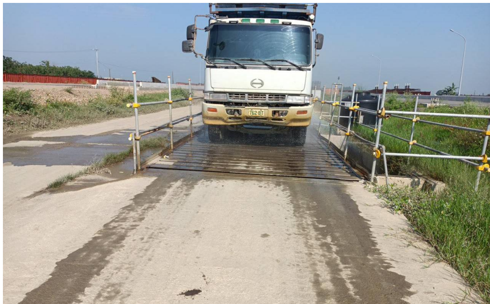
圖 9-17 工區出入口設置洗車台及沖洗設備
