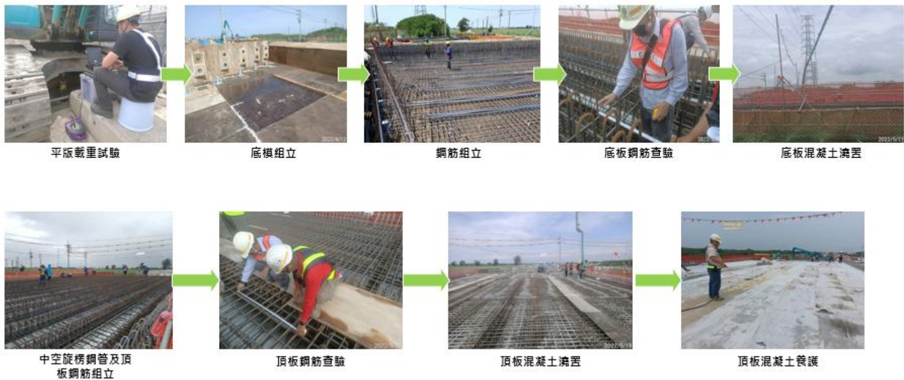
圖 8-16 中空板梁排水橋施工相片
