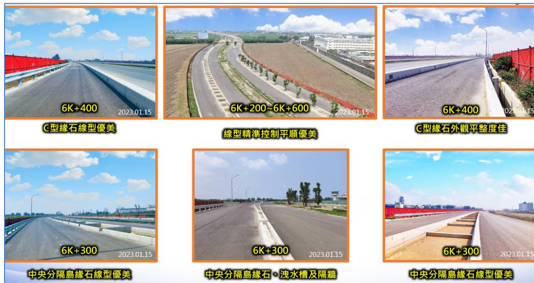
圖 1-15 型緣石實體分隔，中央分隔島緣石現況照片
