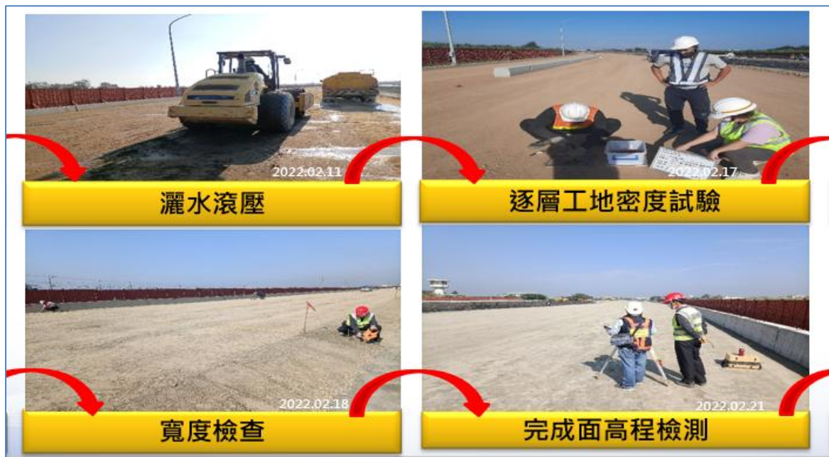
圖 1-13 級配料底層以機動平路機攤平分層填築
