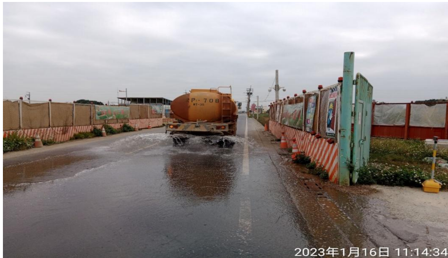
圖 9-18 工區內施工便道清洗及灑水
