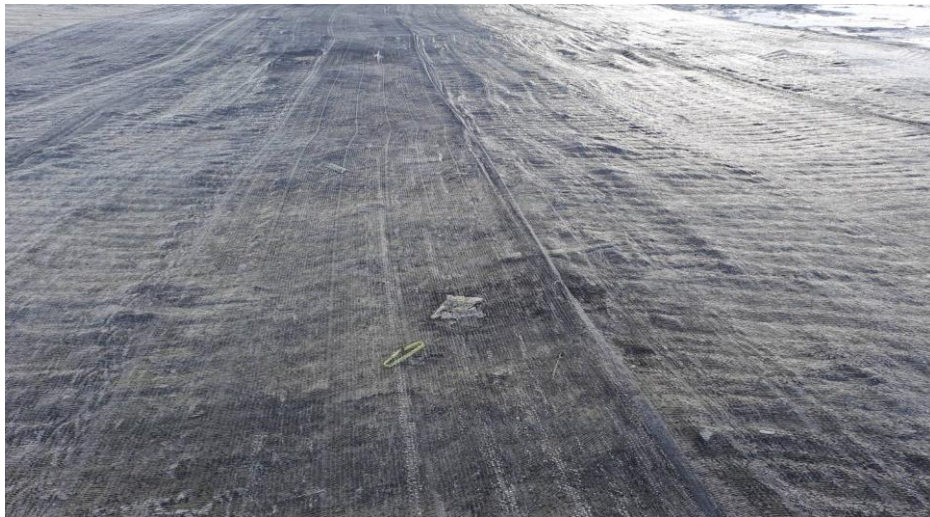
圖 9-19 裸露地表覆蓋防塵網
