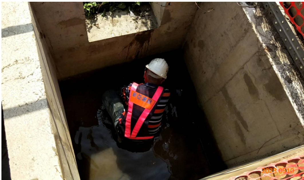
圖 9-22 臨時沉砂池清除淤泥
