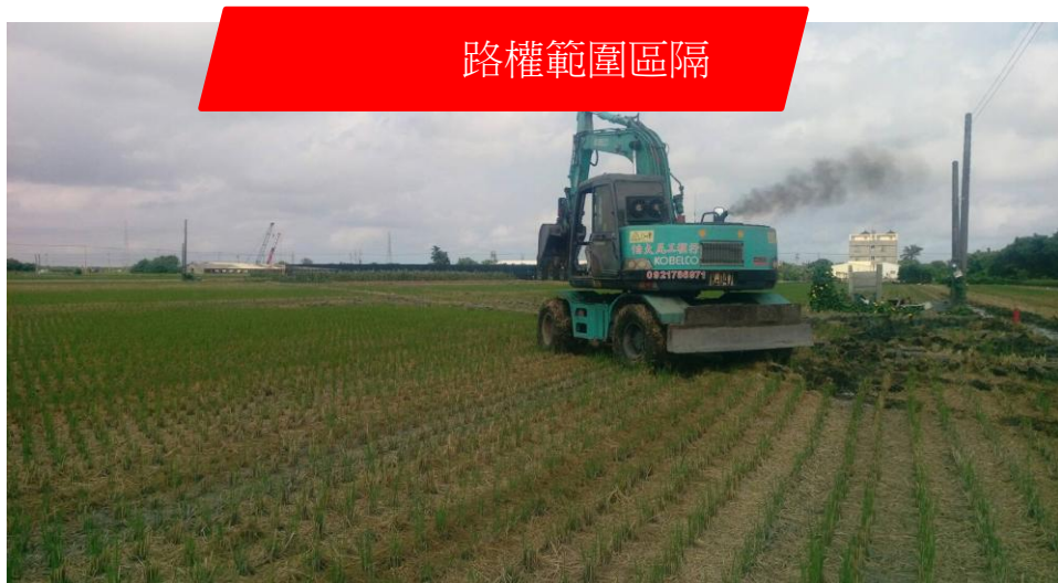
圖 11-2 本工程用地路權範圍施工公告及區隔照片
