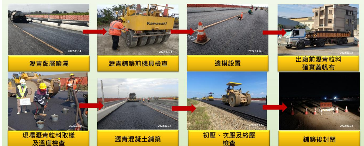
圖 3-1 瀝青混凝土鋪面施工要領
