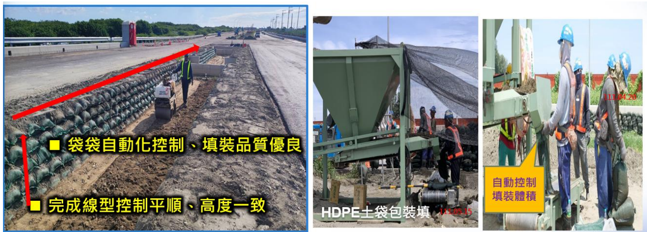
圖 1-12 HDPE 土袋包自動裝填機
