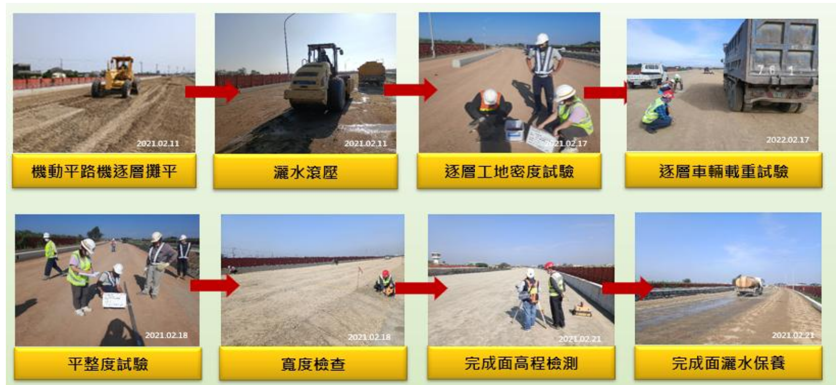
圖 8-12 級配粒料底層施工照片
