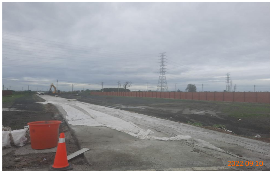
圖 9-20 工地車行路徑全線鋪設混凝土
