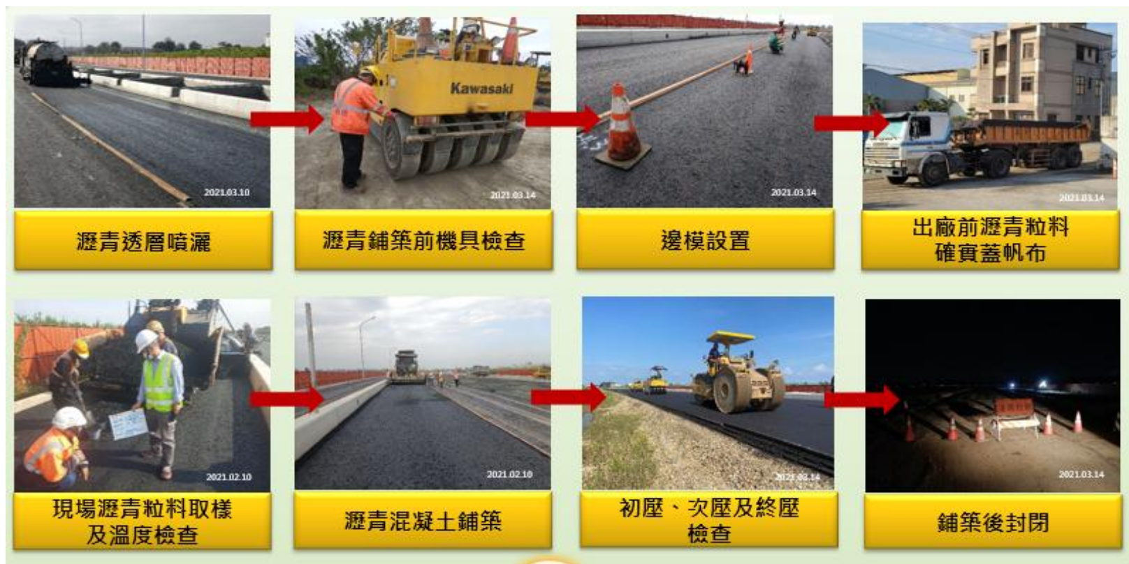
圖 8-14 瀝青混凝土施工相片
