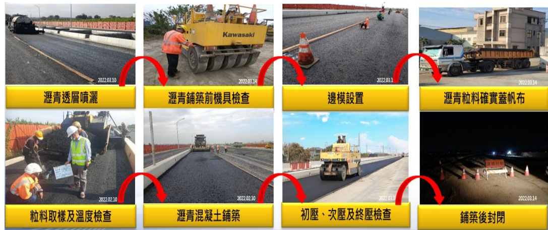
圖 1-14 瀝青混凝土鋪面施工流程
