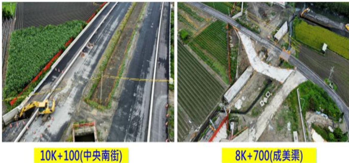
圖 6-3 台電管線遷移照片
