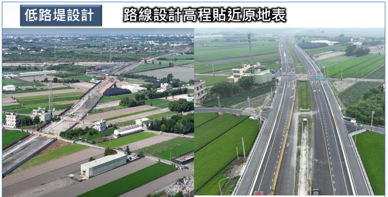
圖 1-25 採低路堤設計施工中及完成後照片
