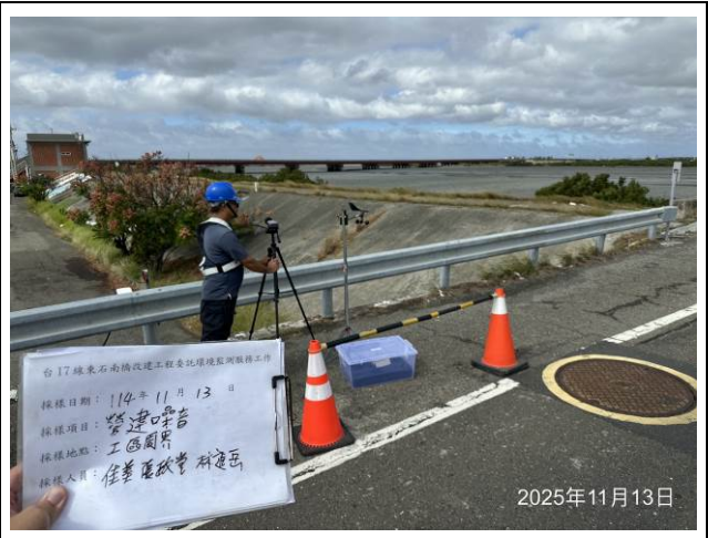
營建噪音(工區周界)-11月
