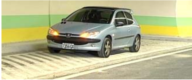
(圖 9) 緊急停車彎 (資料來源：八卦山隧道宣導短片)
