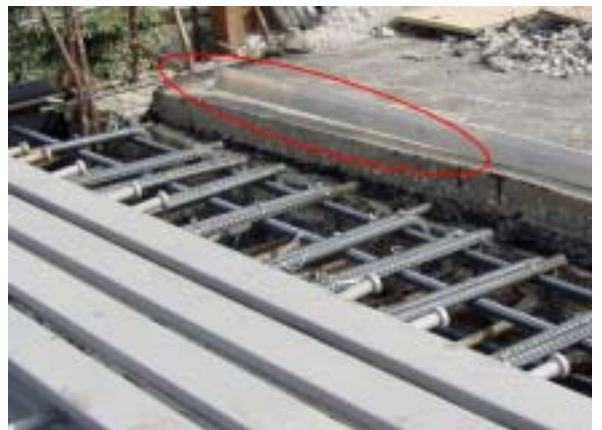
圖4.48 AC面層不平順兩端經常發現有下垂情形
