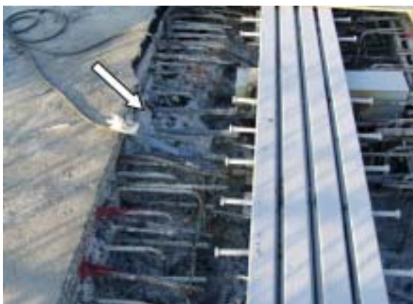
圖4.43 混凝土流入預留槽內影響伸縮縫安裝及鋼筋綁紮施工
