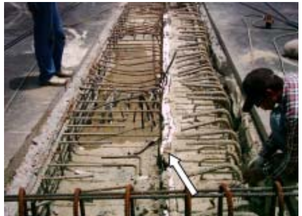
圖4.40 以保麗龍板隔離端隔梁縫距離確保
