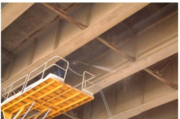
照片 9-12 以 4000PSI 水刀清洗鋼構件
