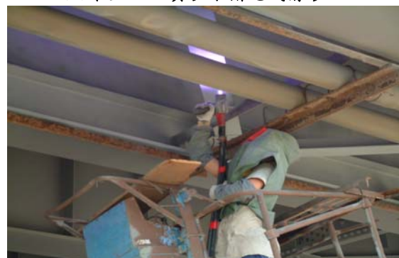
照片 9-16 鋅鋁熔射情形
