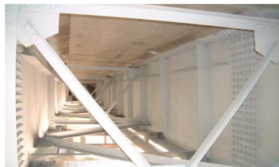
照片 9-18 鋅鋁熔射完成情形
