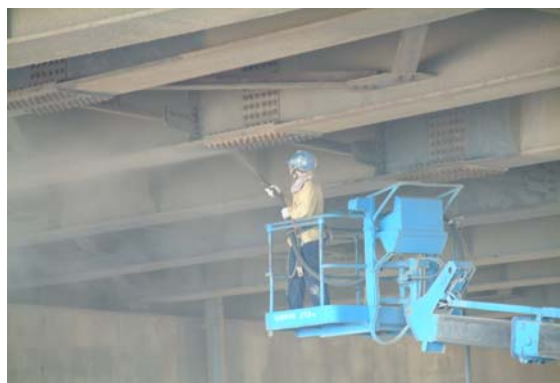
照片 9-13 A1~P3 間噴砂除鏽情形
