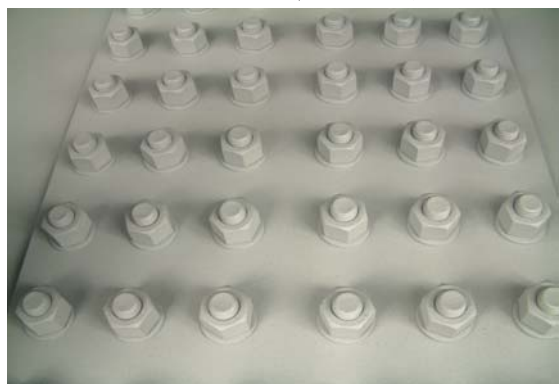
照片 9-19 鋅鋁熔射完成情形
