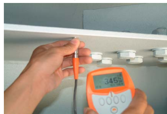
照片 9-20 鋅鋁熔射完成後膜厚計檢測情形
