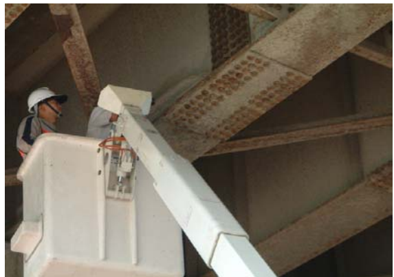
照片 9-4 油漆前檢測生鏽情形
