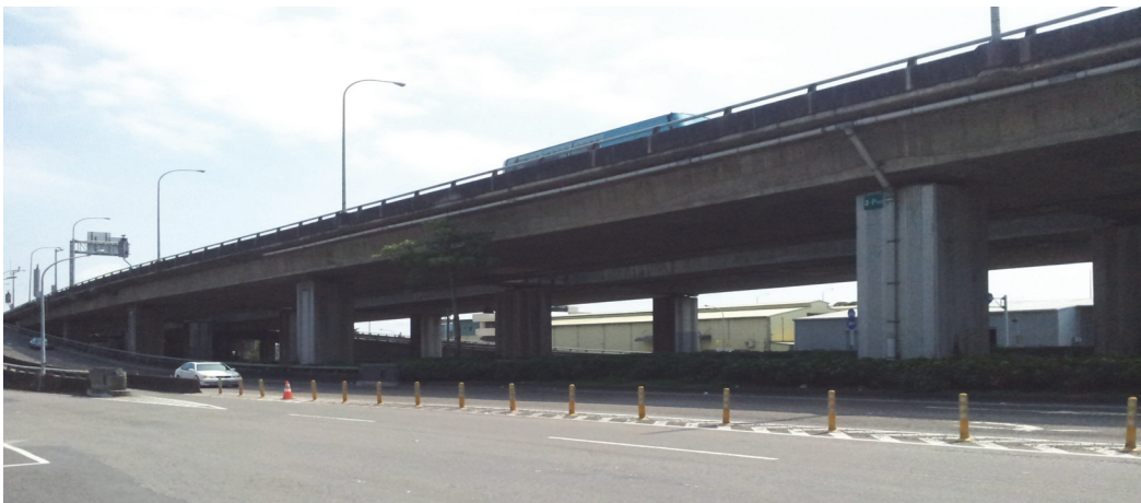
圖七 快速道路匝道出口與平面道路交會處之交通桿
