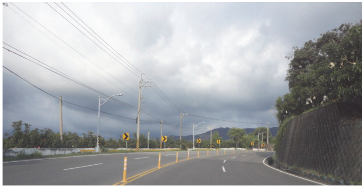
圖十一 道路幾何線形急彎處之交通桿
