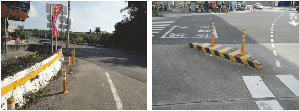
圖二十一 混凝土護欄旁與交通島上方之交通桿
