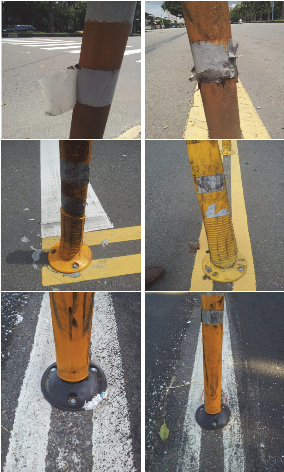
圖三十三 典型交通桿反光材料缺失之例
