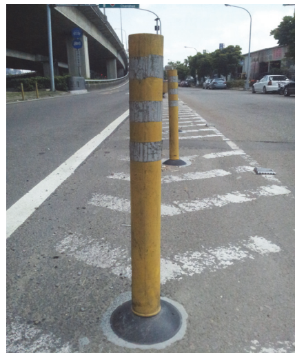
圖八 快速道路匝道入口與平面道路交會處之交通桿
