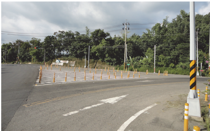
圖十六 槽化區邊緣之交通桿
