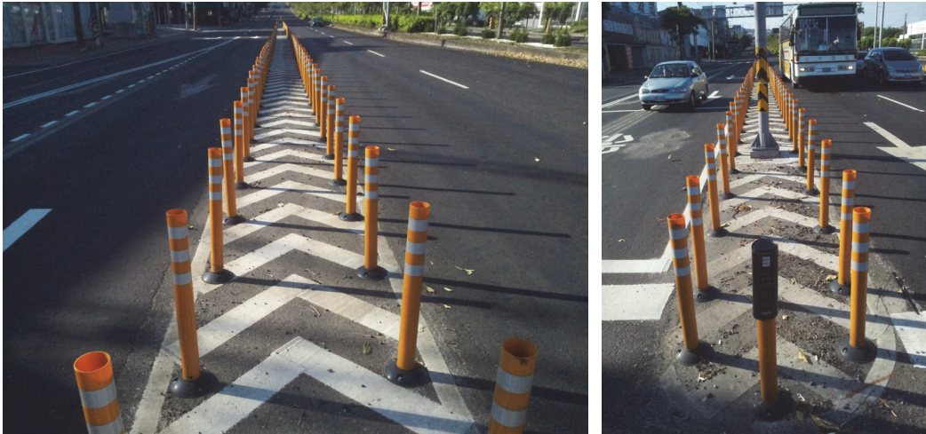
圖九 平面道路主線與側車道清除區上之交通桿
