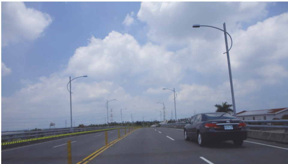
圖十三 高架橋上中央分隔標線上方之交通桿
