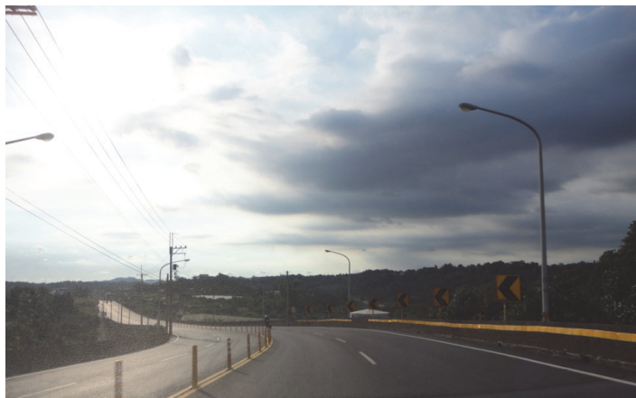
圖十二 道路幾何線形不良處之交通桿
