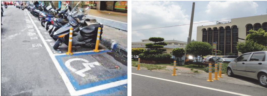
圖十五 以交通桿分隔停車格位
