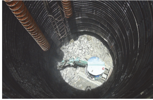
F2 井基降挖施工
