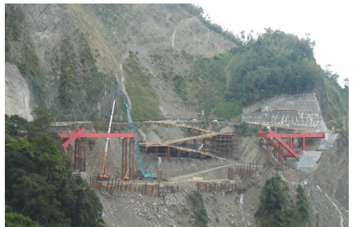
平面鋼梁吊裝
