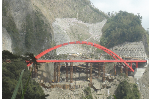
鋼拱橋吊索施工
