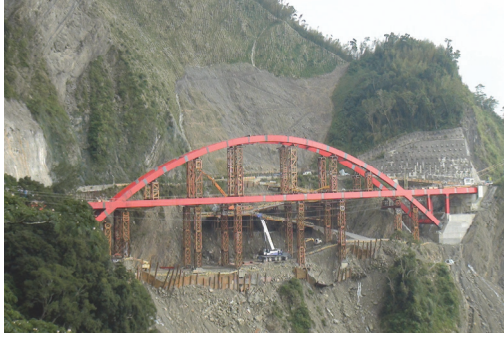
上拱肋鋼梁閉合吊裝
