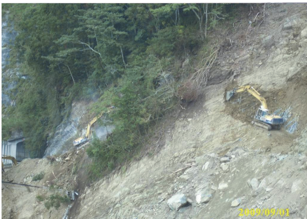
圖 2 台 18 線 71k+100 路基流失便道搶修中(由東往西拍攝)
