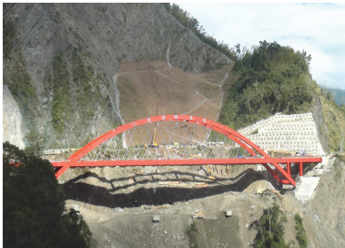
鋼拱橋吊索施工完成
