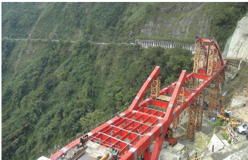
鋼梁上拱肋吊梁施工
