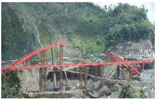
鋼梁吊裝施工鳥瞰圖
