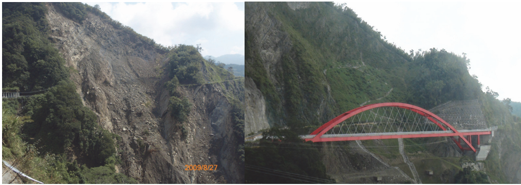
圖 17 芙谷峨橋施工前、後相片
