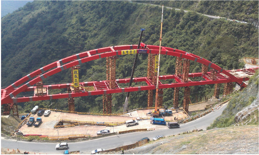
圖 26 鋼拱橋吊裝完成現況
