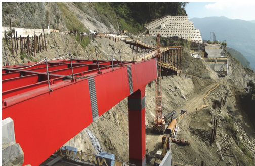
臨時支撐基樁施工
