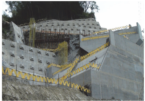
A2-F2 橋台及基座施工
