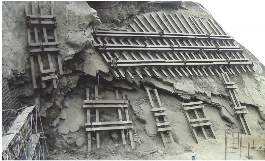
圖20 F2基座上邊坡以地錨配合H型鋼方式來保護邊坡
