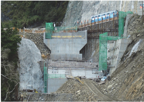
A1-F1 橋台及基座施工
