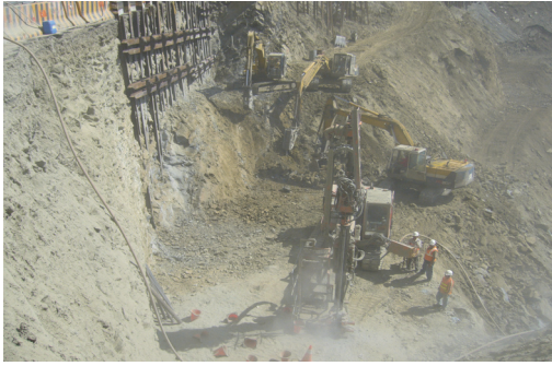
A1 井基引孔降控
