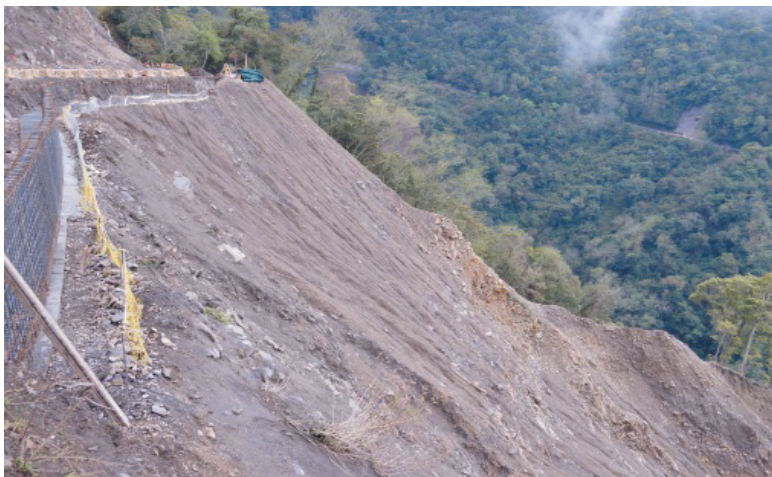
圖 14 建議下邊坡坡面予以保護，坡腳亦應加以護岸保護，以避免河水長期掏刷作用
