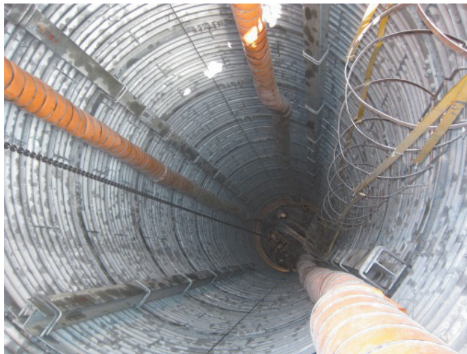
圖 33 嘉寶隧道短期改善工程集水井施工
