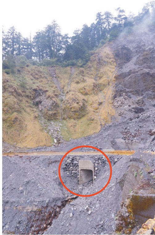
圖 21 昌仕橋目前採過水路路面，維持交通
