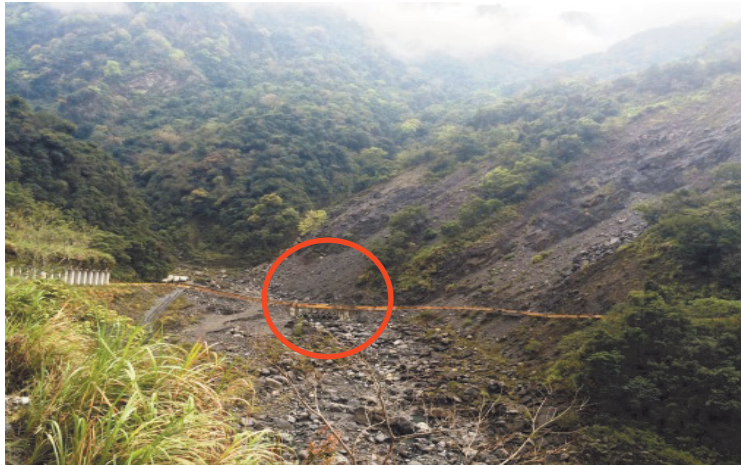
圖 2 唯金溪目前通過野溪處採用涵管過水路面
