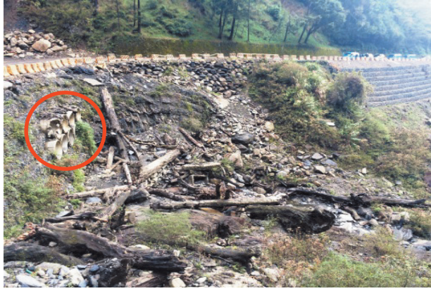
圖 9 禮觀橋處過水路面涵管容易堵塞而溢流受損壞，建議改為三孔 7m*7m 箱涵
