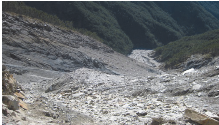
圖 28 下邊坡受河水沖刷而滑動，路基不宜建於填方地區
