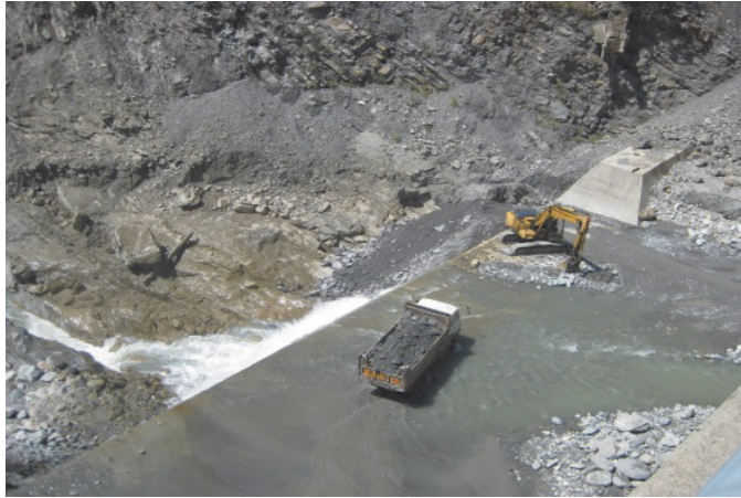
圖 32 橋址下游保護工混凝土受磨損，保護層破壞，鋼筋裸露，下游河床受刷深
