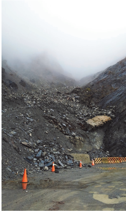
圖 19 昌仕橋上游邊坡之崩坍，自南橫公路施工前即長期存在
