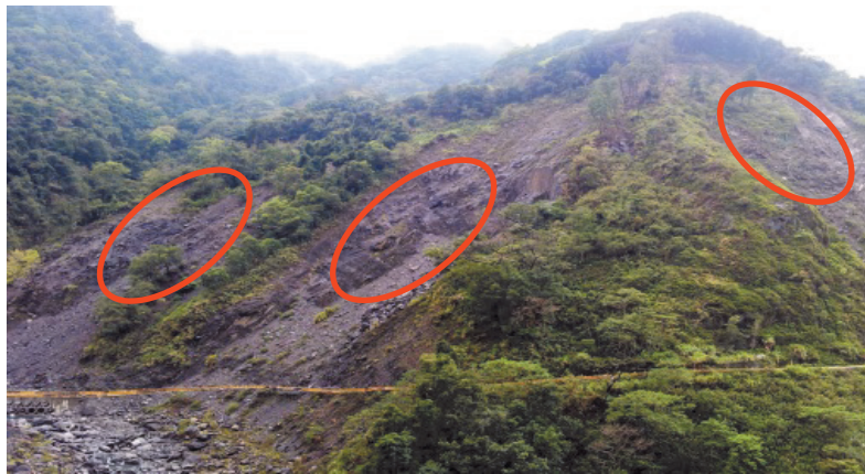
圖 4 唯金溪崩塌區 A、B、C 現況情形
