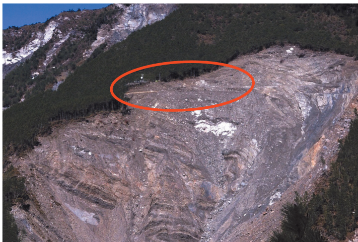
圖 26 路基有部分係在回填層上
