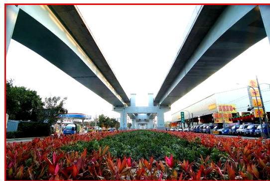
圖 33 本工程完工照片(六)
