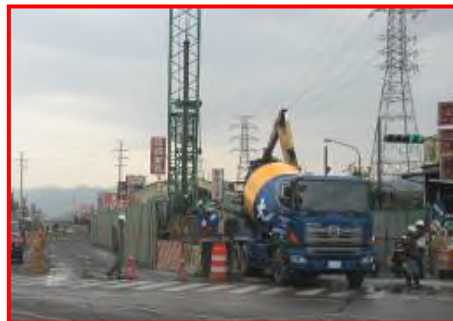
圖 15 基樁施工空間受限
