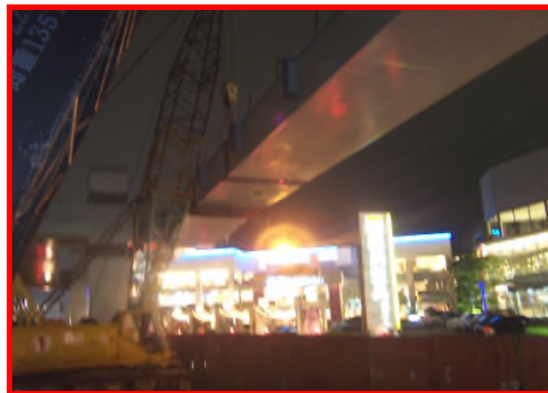
圖 25 鋼箱型梁夜間吊裝
