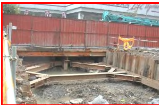
圖 16 基礎開挖擋土支撐
