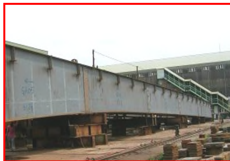
圖 22 鋼結構於鋼構廠假安裝
