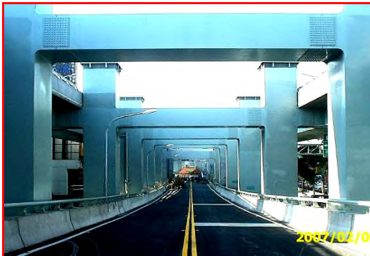
圖 30 本工程完工照片(三)
