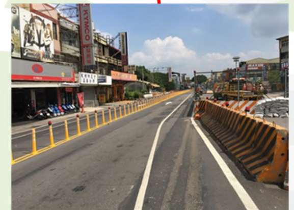
北上施工區段交維
