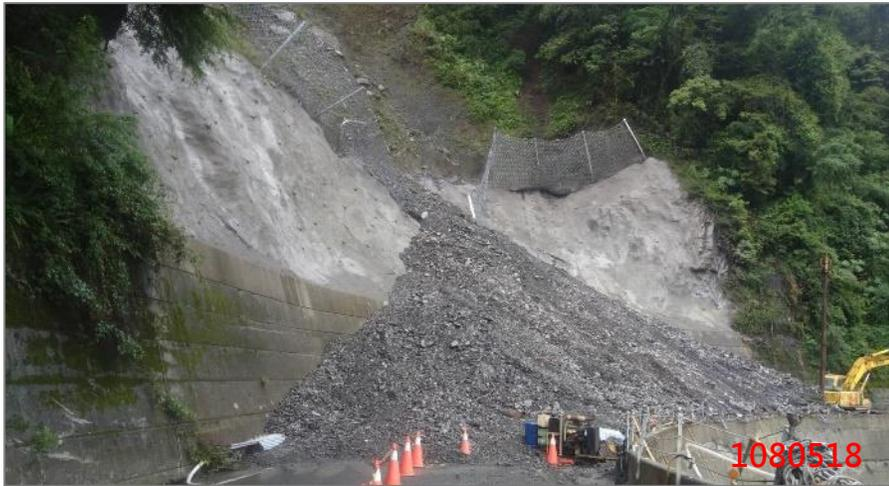
108年5月18日:豪大雨防落石網損壞
