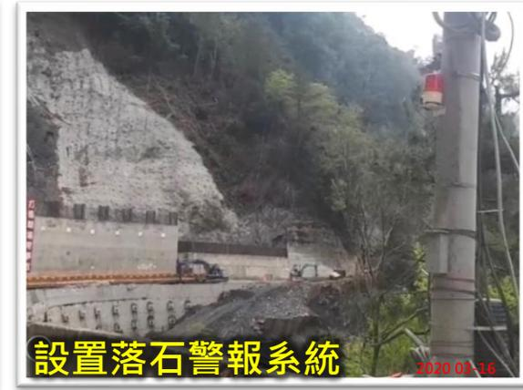
設置落石警報系統
