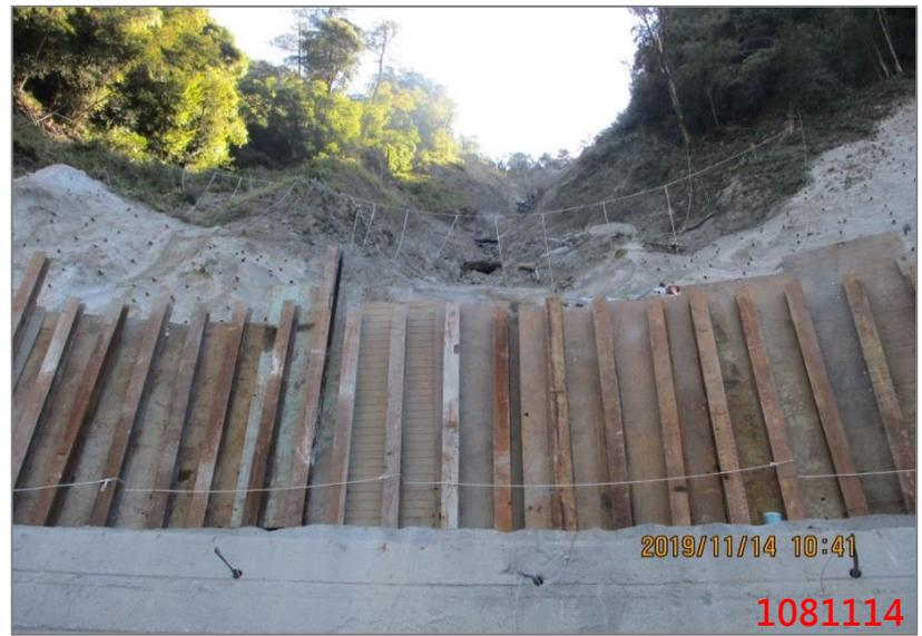
攔石柵(H型鋼+鋼板)
