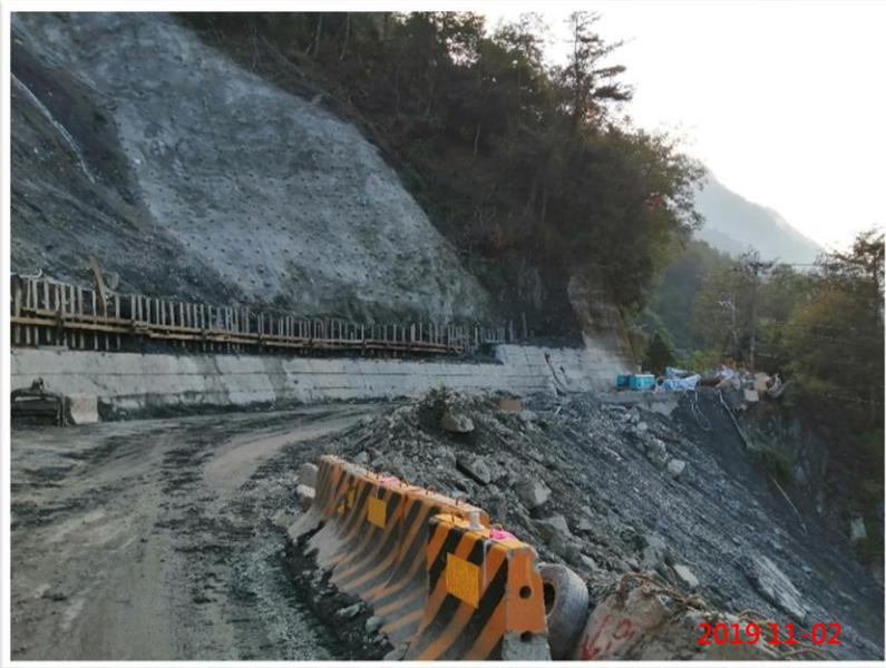
上邊坡擋土支撐及噴凝土保護階段完成後，後續結構體進場施工，將有**更多勞工須進行防護**，必須再行加強防護措施及手段。
