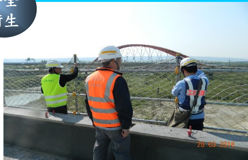
橋面安全欄杆檢查
