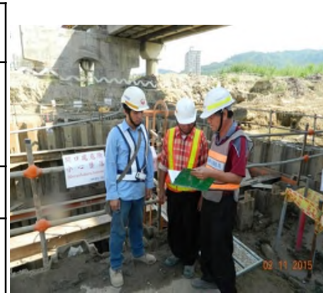
擋土支撐作業主管查證
