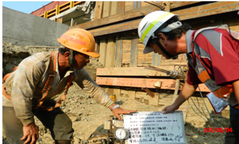
擋土支撐地錨檢查
