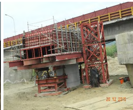
模板支撐與安全措施全貌
