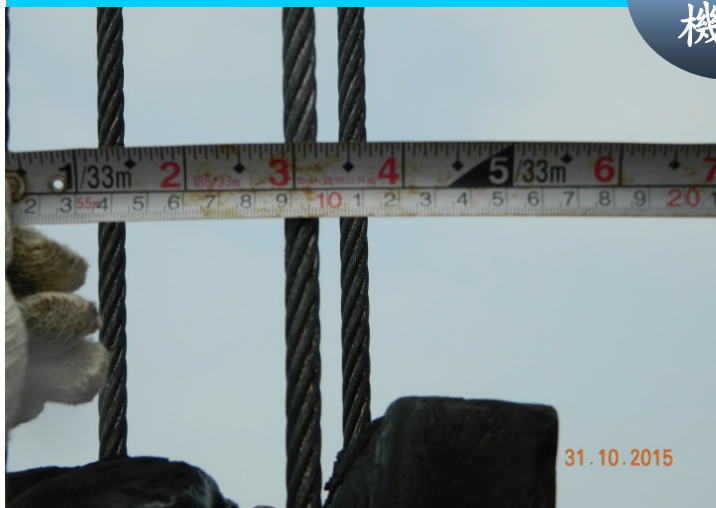
吊車鋼索檢查
