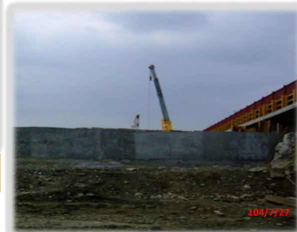
設置混凝土防洪牆
