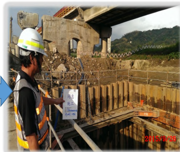
安全欄杆改善完畢 同意施工
