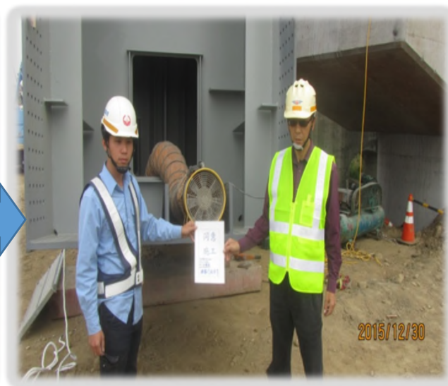
通風設備改善完畢 同意施工
