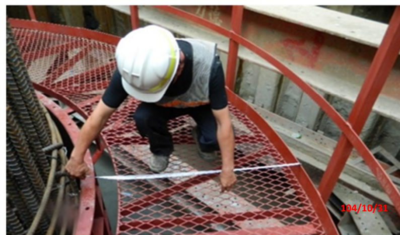
施工安全平台檢查
