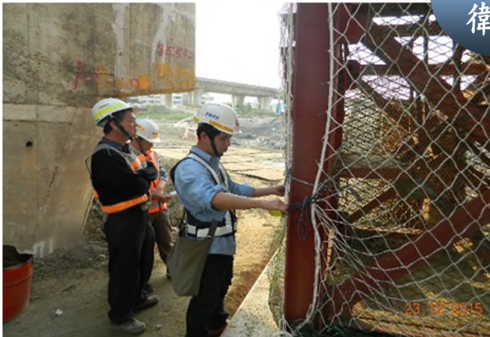
上下設備檢查
