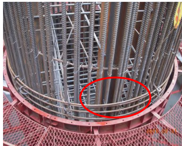
施工樣架與柱內箍筋接合檢查
