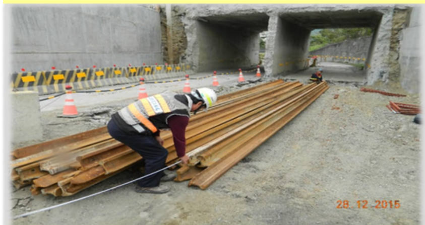
鋼軌樁長度檢查
