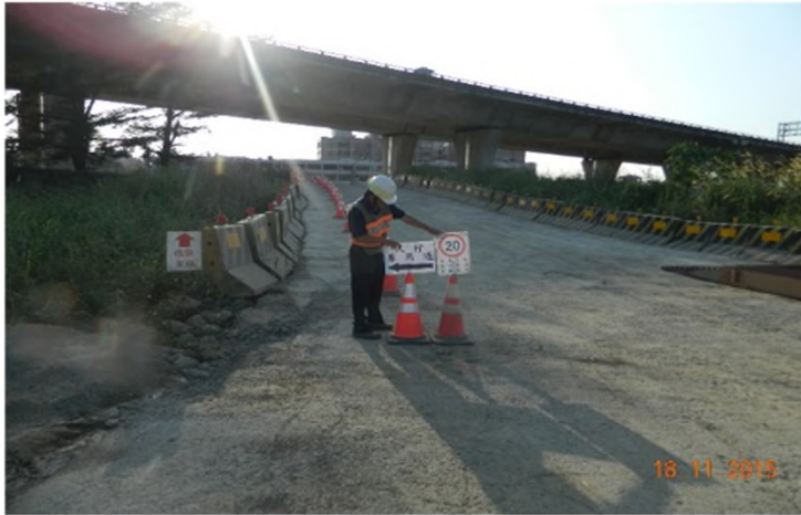
施工便道人車分道
