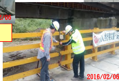
0206地震後鋼便橋檢查
