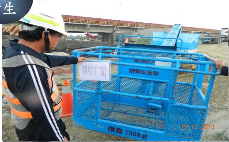
高空作業車檢查
