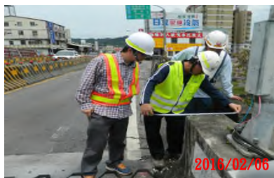
0206地震後舊橋檢查
