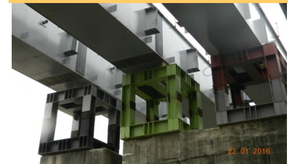
吊裝作業臨時支撐
