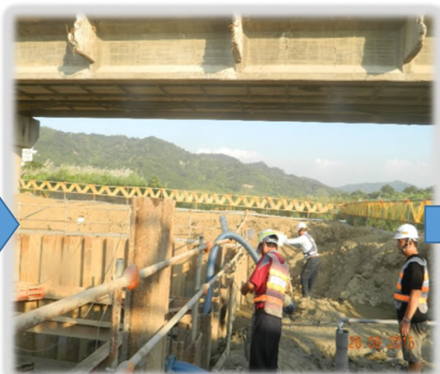
安全欄杆檢查
