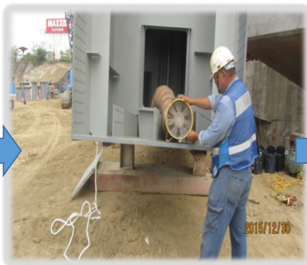
通風設備改善中
