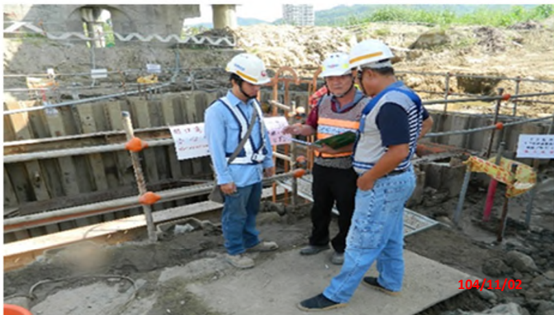
露天開挖作業主管查證
