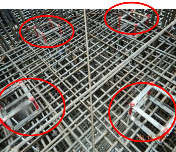
施工樣架基礎檢查
