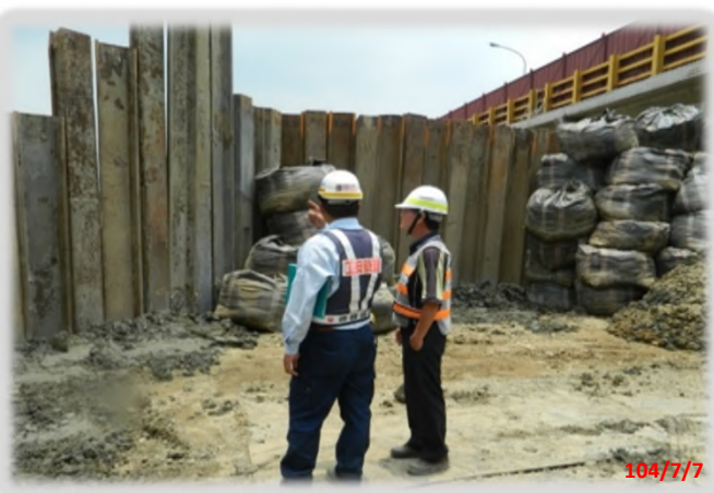
現地鋼板樁設施
