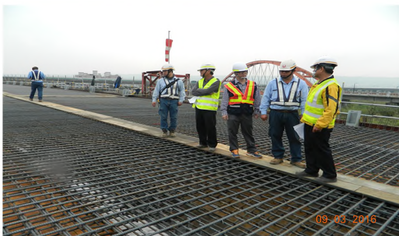
橋面施工鋪設安全走道
