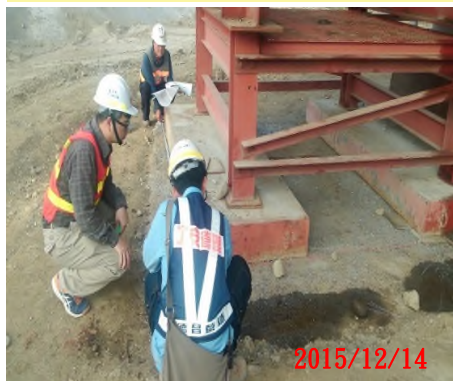
模板支撐基礎檢查
