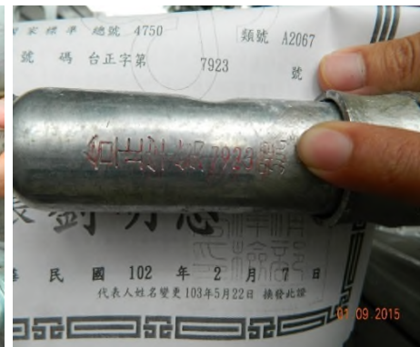
施工架規格檢查
