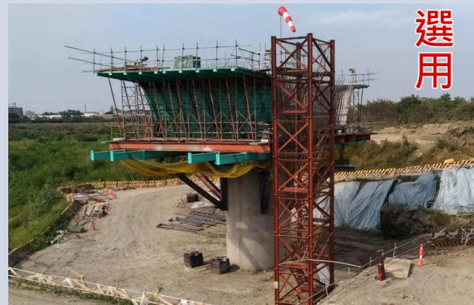
模版支撐由重型支撐架將載重傳遞至河床面
