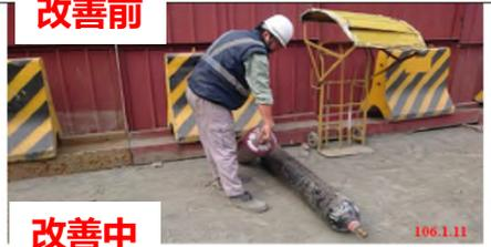
說明: 立即派人將氧氣乙快鋼瓶扶正放置於固定架, 並設置遮擋設備。
