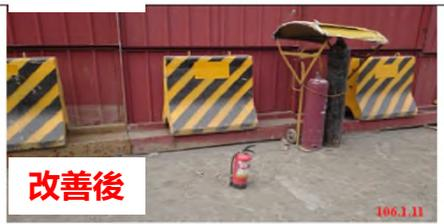
說明: 已將氧氣乙快鋼瓶扶正放置於固定架, 並設置遮擋設備改善完成。
