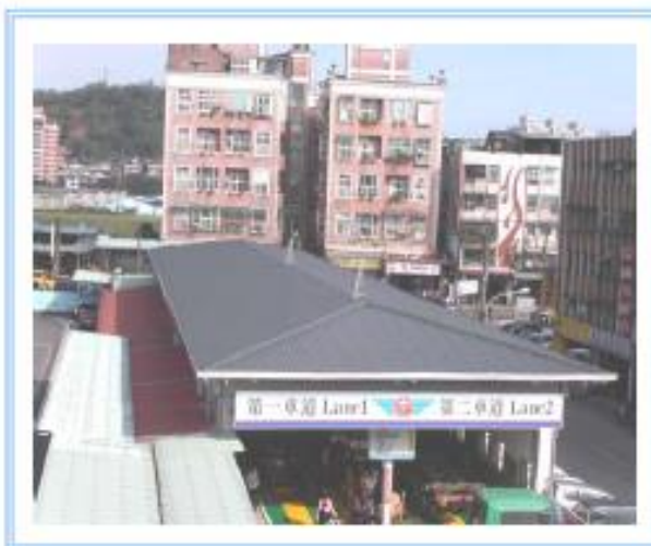
(圖 3 - 15 本站檢驗室屋頂加蓋遮陽板)
