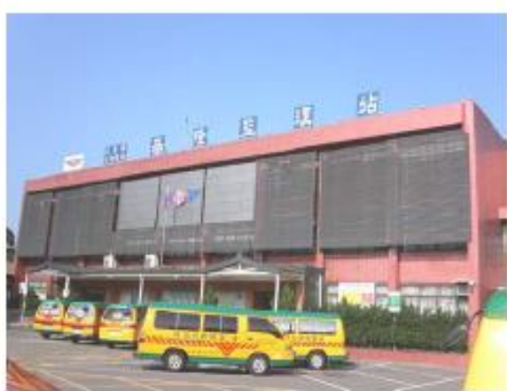
(圖 3 - 16 牆面加設置外遮陽板)
