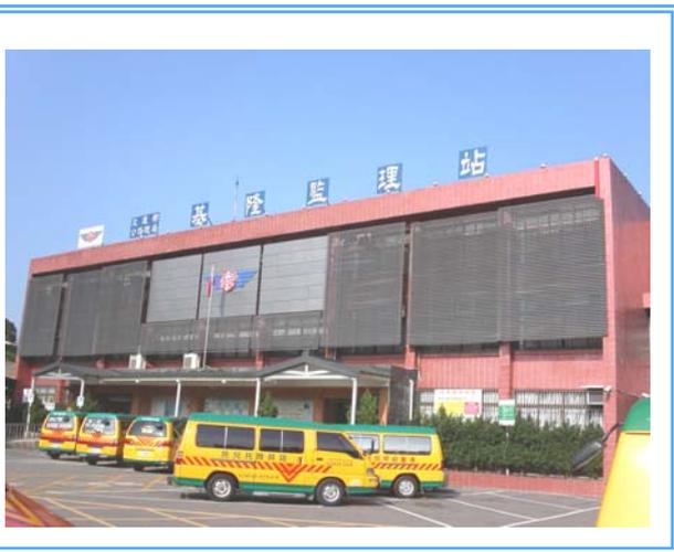
(圖 3 - 16 牆面加設置外遮陽板)
