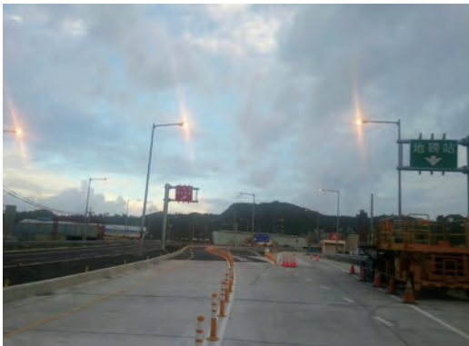
蘇澳東澳段公路照明設備之單機測試
