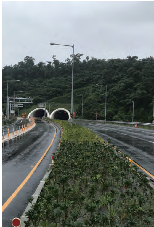
東澳管制站灌木種植完成照片
