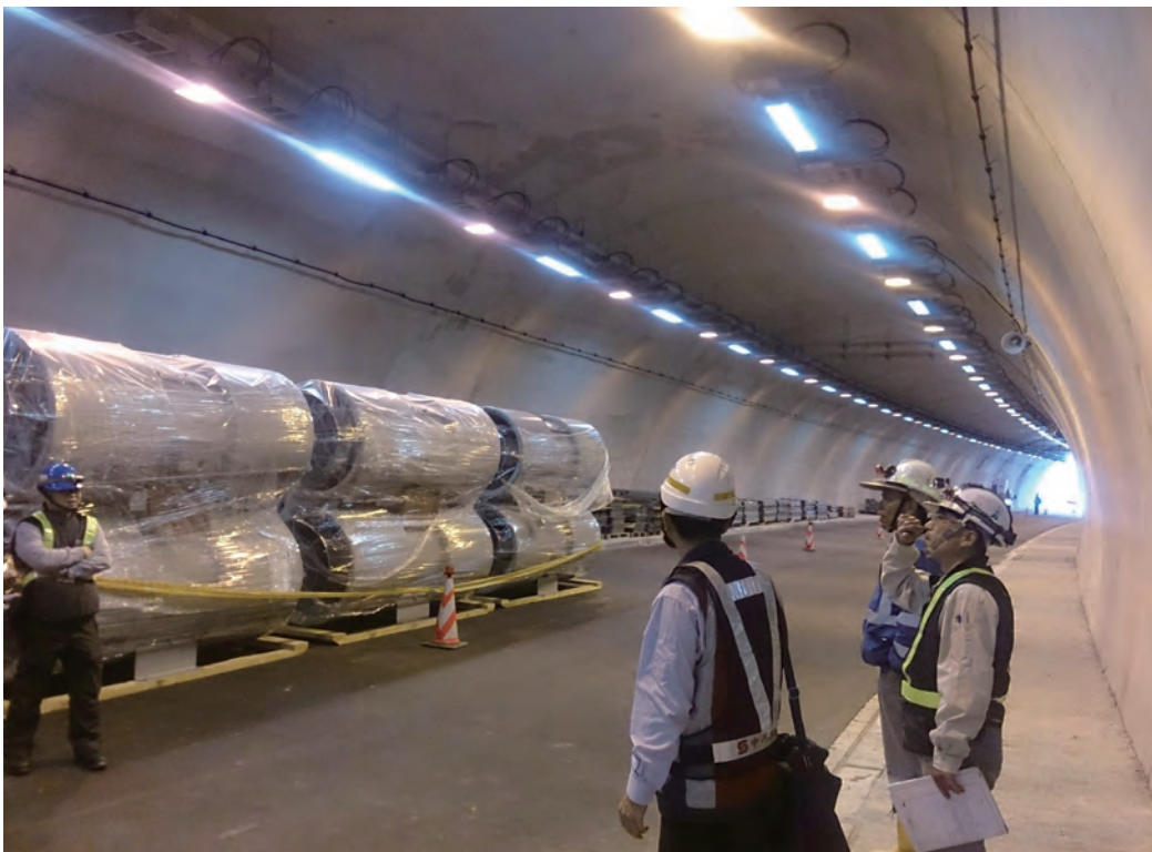
東岳隧道照明設備之單機測試
