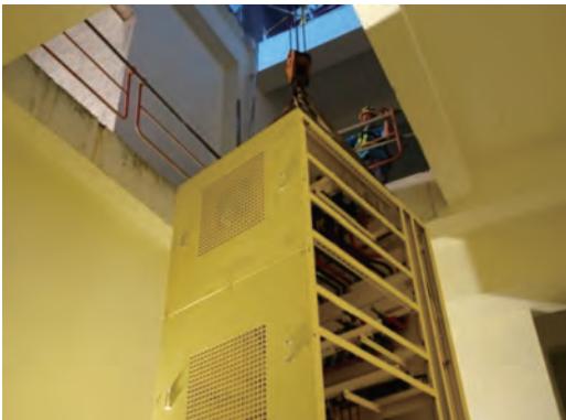
緊急柴油發電機由北口機房二樓吊掛至一樓作業
