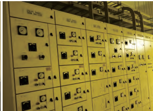
北口機房一樓緊急柴油發電機固定安裝
