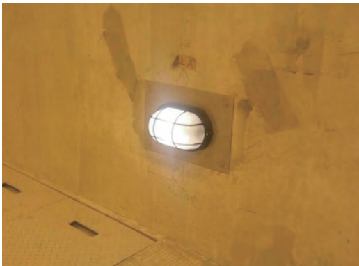
蘇澳隧道火災緊急照明燈之單機測試
