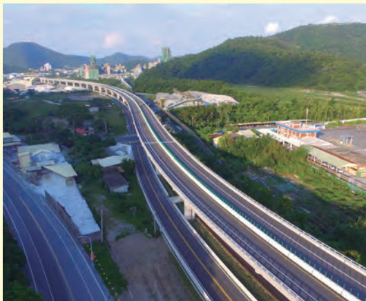
白米高架橋下內側空間設置載重車輛專用道路
