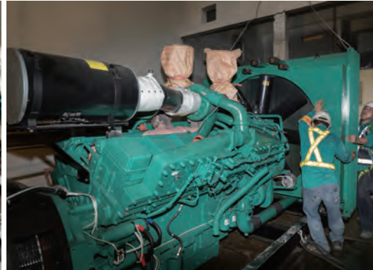
北口機房地下一樓電氣室（二）配電盤固定安裝
