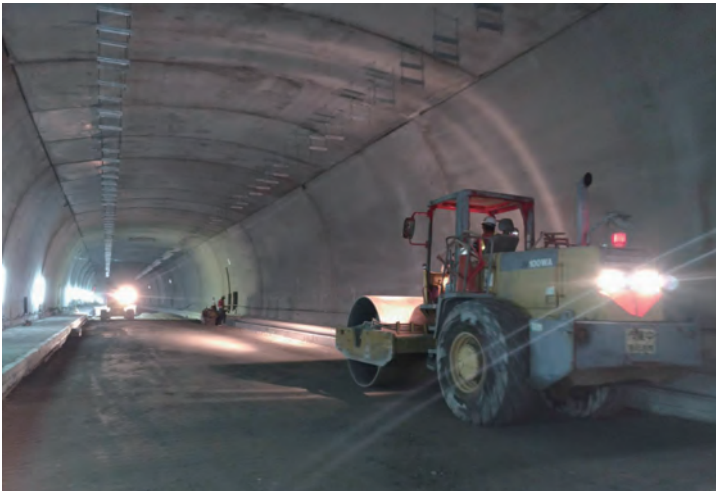
北上線進行路面級配回填作業
