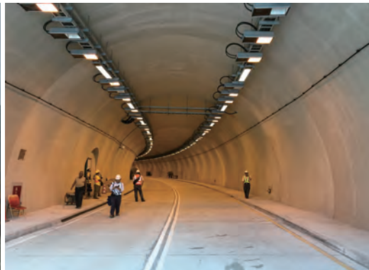
蘇澳隧道照明設備之單機測試
