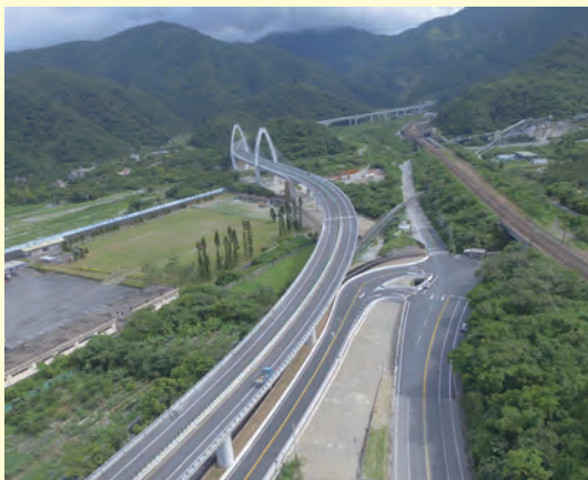
白米高架橋下載重車輛專用道路繞離社區末端出口
