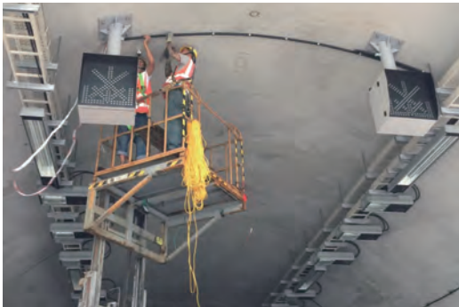
LCS 設備安裝
