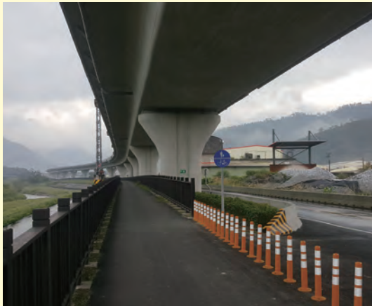
白米高架橋下打造自行車道與載重車專用道路
