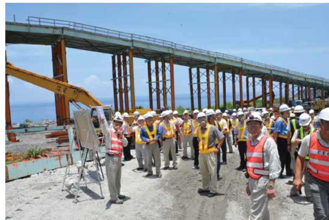
101年06月27日第5次推動小組委員視察B3標工地
