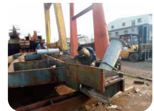
• 間隔梁成品電銲
