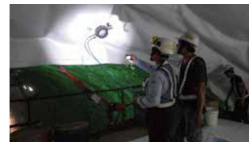
• 主隧道防水膜真空罩檢驗
