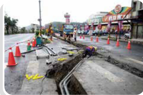
• 於蘇港路進行土木管道工程施作
