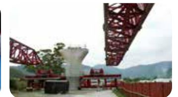
12. 確認下一墩支撐架搭設是否完成
