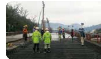
10.頂板鋼筋綁紮及混凝土澆置
