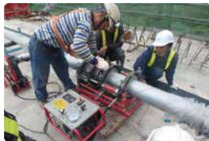
• HDPE管對接等前置作業
