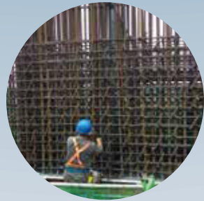
2. 墩柱鋼筋綁紮
