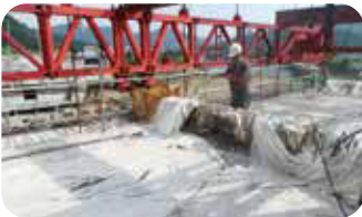
3.混凝土澆置後養護
