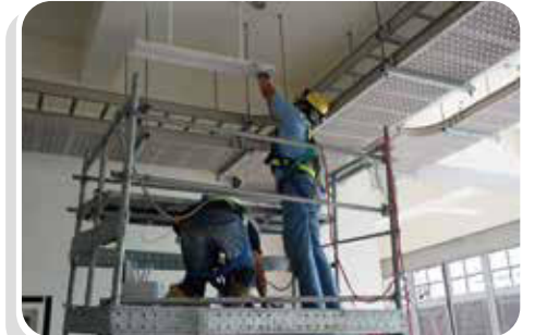
• 東澳隧道南口機房燈具安裝
