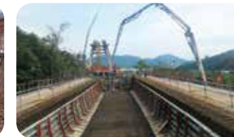
8.底腹板混凝土澆置
