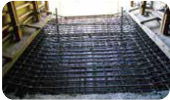
8.底板鋼筋綁紮
