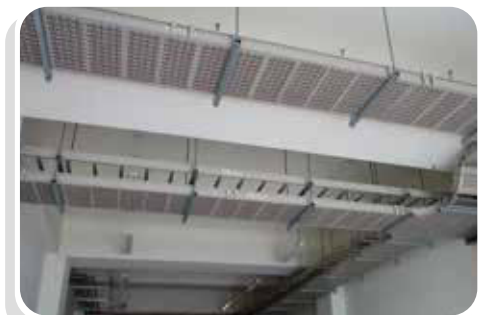
• 東澳隧道南口機房電纜架安裝
