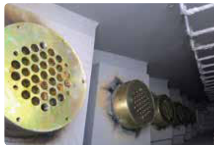
• 鋼箱固定錨座安裝
