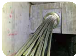
12.完成安裝之外置預力錨碇端
