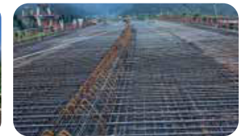
6. 混凝土澆置前置作業
