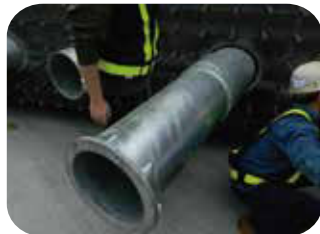
4.鋼殼之外置預力套管
