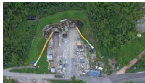
• 中仁隧道南口
