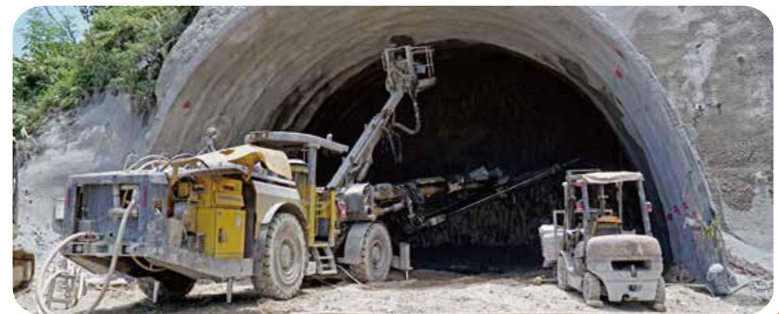
• 中仁隧道北口施作
