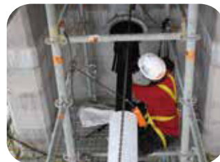
9.外置預力上端之安裝
