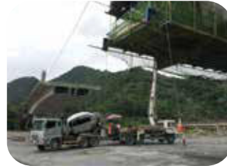
3.P2節塊澆置混凝土
