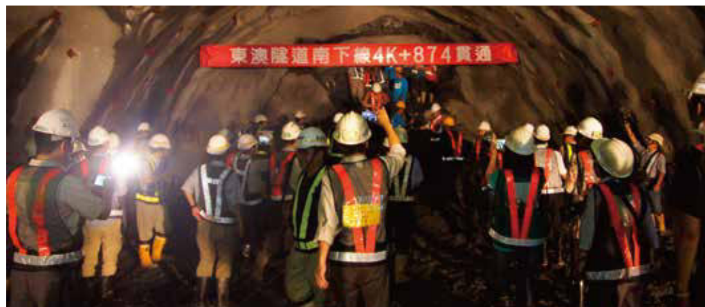
• 東澳隧道南下線貫通
