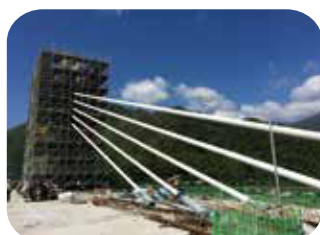
13.P2安裝完成之外置預力
