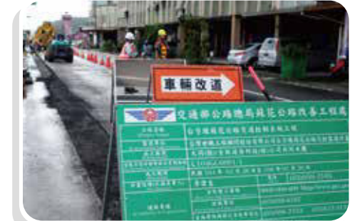
• 於蘇港路進行土木管道工程施作
