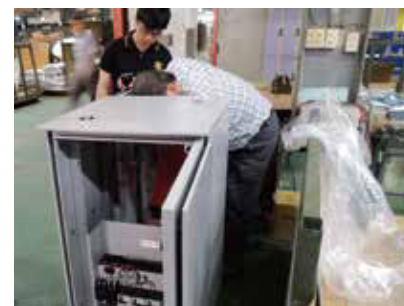
• 105年5月4日終端設備箱體材料抽驗
