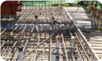
9.頂板鋼筋及套管安裝
