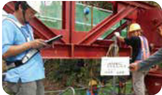
5.預力施拉完成
