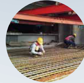
5. 底板鋼筋綁紮
