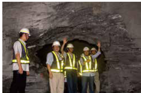
• 觀音隧道南下線全線貫通
