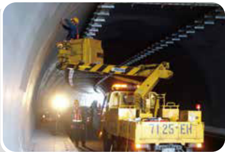
• 東岳隧道無線電話及隧道廣播系統漏波電纜吊架施作
