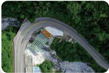
• 仁水隧道南口鋼便橋施作情形
