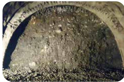
• 北口NS3開挖面
