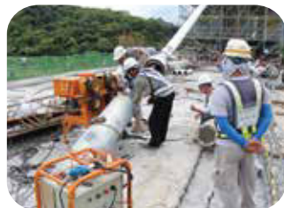
8.外置預力鋼索穿線作業
