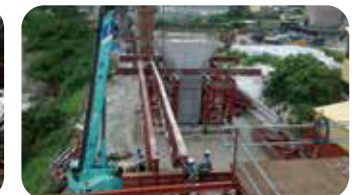
3.架設橫縱梁及主桁架
