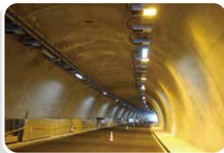
• 東岳隧道燈具安裝及測試
