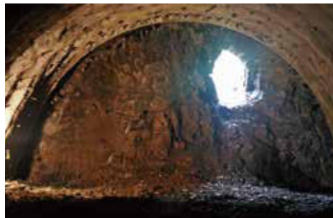
• 觀音隧道南口SS8上半工作面貫通
