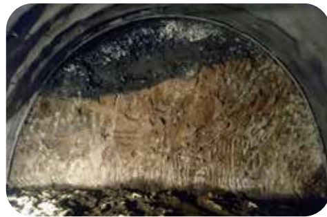
• 北口SS4開挖面
