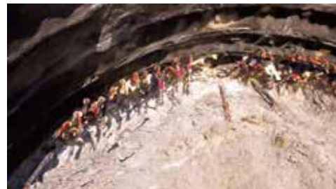
• 可削式耐衝擊管輪進挖除情形
