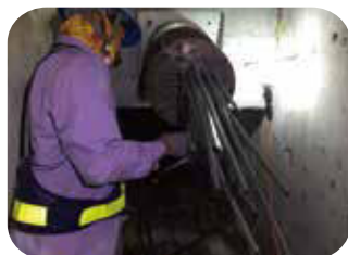
10.外置預力鋼索下端之夾片安裝
