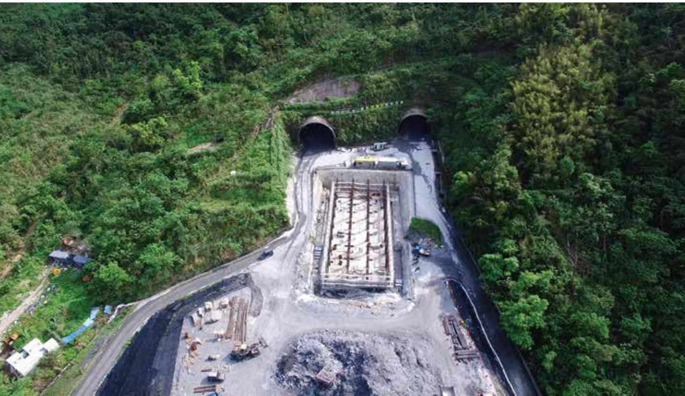
• 觀音隧道北口空拍
