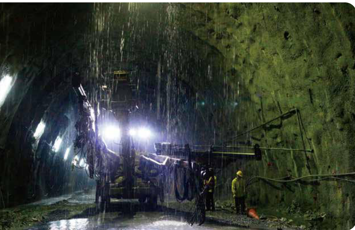
• 6k+155.4 (T552) 兩側受橫移斷層影響及層間剪裂帶影響，造成開挖面破碎夾剪裂泥
