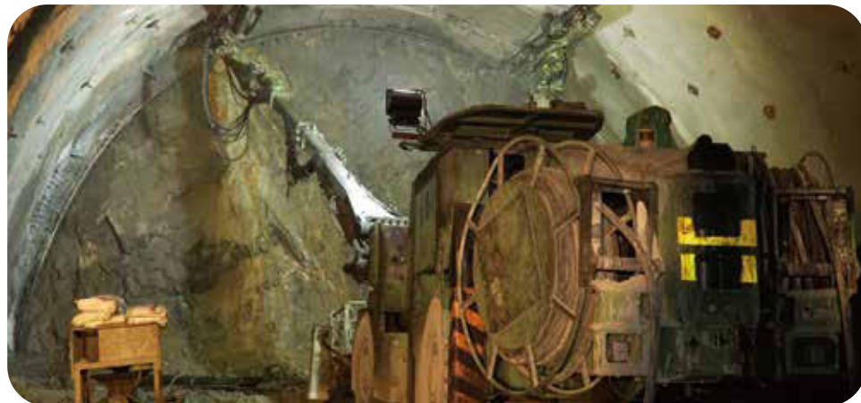
• 中仁隧道施作
