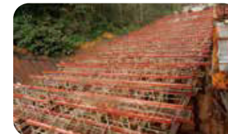
4.組立鷹架組及排設
