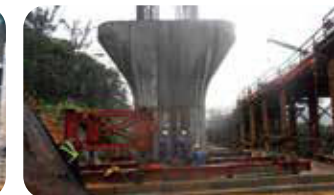
2.鋪設底梁及支撐塔
