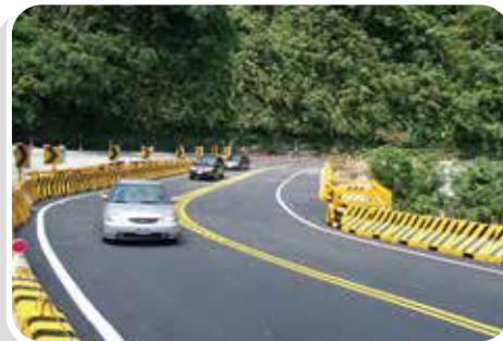
• 南口鋼便橋改道完成並開放通車
