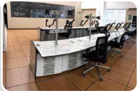
• 四工處緊急應變中心控制台外觀
