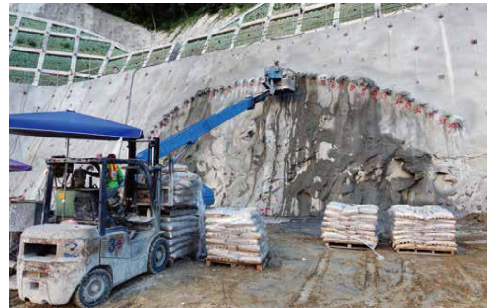
• 中仁隧道北口施作
