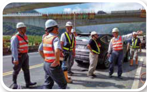
• 工程處人員於工地現場
