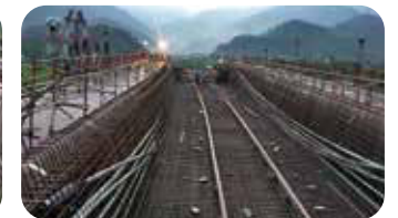
3. 預力套管安裝及穿線
