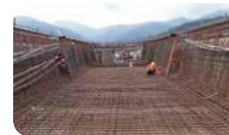
7.底腹板鋼筋綁紮預力套管安裝
