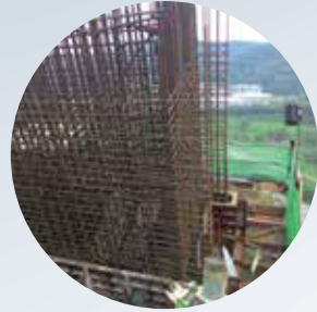
6. 墩柱內模安裝
