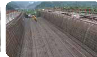
2. 底、腹板鋼筋綁紮
