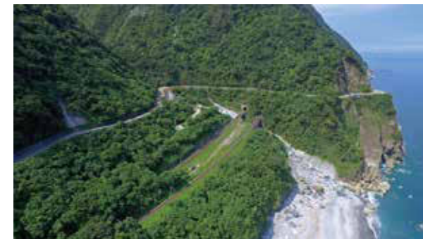
• 仁水隧道南口現況
