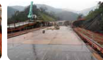
5.鋪設底模及軌道
