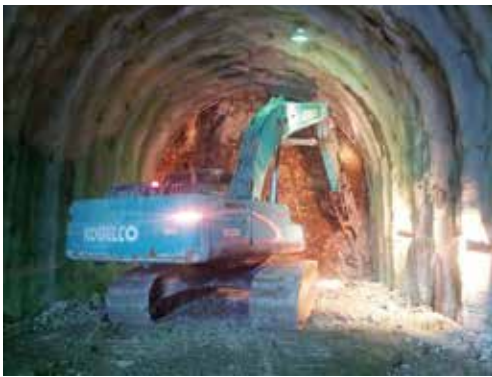
● 機械開挖及修挖
