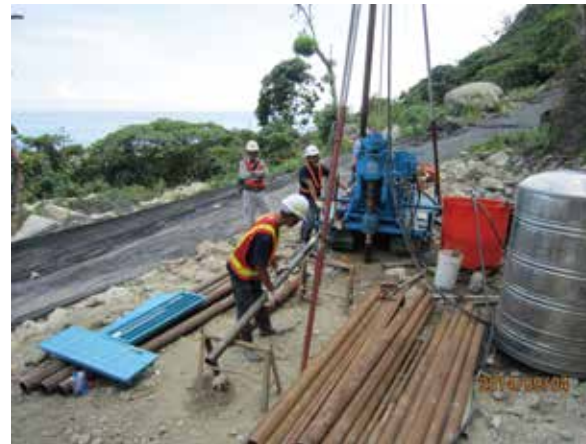
● 補充地質鑽探孔深量測
