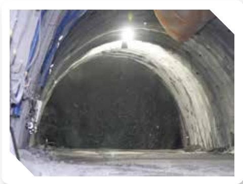
● NS3.NN5隧道爆破後貫通
