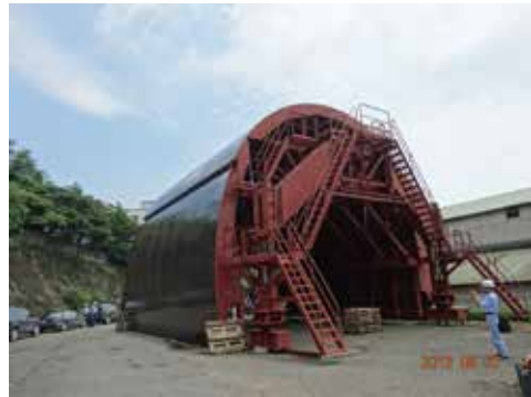
● 鋼模假組立現場查驗
