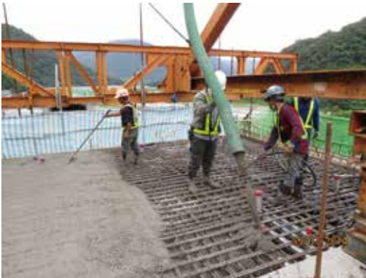
● 節塊混凝土澆置於台9線側設置帆布
