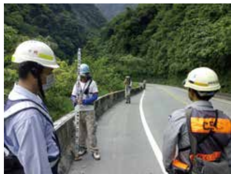
● 導線測量作業
