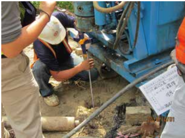
● 補充地質鑽探鑽孔作業
