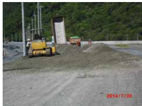
● 級配粒料底層施作
