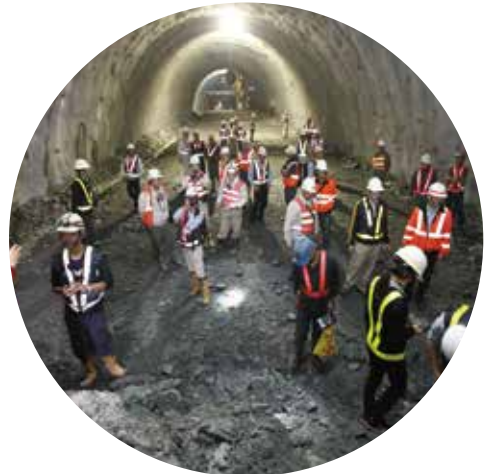
● NS3.NN5隧道貫通後相關隧道施工隧道團隊人員合影留念及隧道內景象
