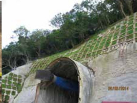
● 中央導坑洞口假隧道
