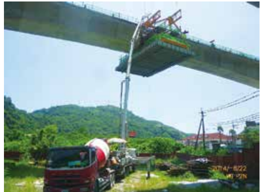
● P2N懸臂工作車已跨越過台9線道路
