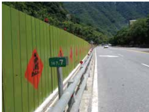
● 第一階段交維圍籬組立情形
