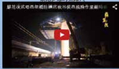
B1標武塔高架橋防護處置板吊裝施作攝影
