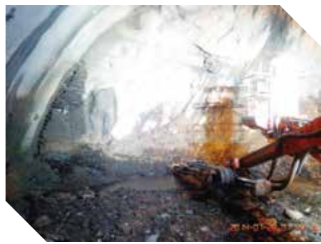
● 鑽堡機鑽設預裂孔
