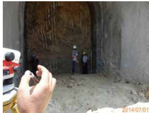
● 北口橫坑工區-R02輪鋼支保組立高程測量
