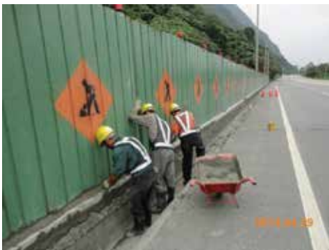
● 北口橫坑工區鄰台9線施工圍籬防溢座施作
