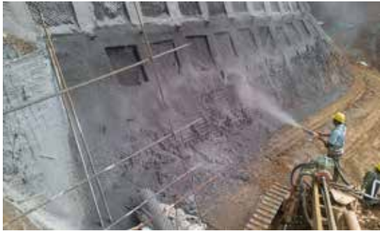
● 自由型格梁及邊坡噴凝土
