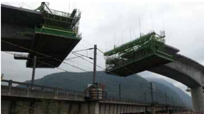
● P11~P12工作車增設防護大底板及垂直防護網
