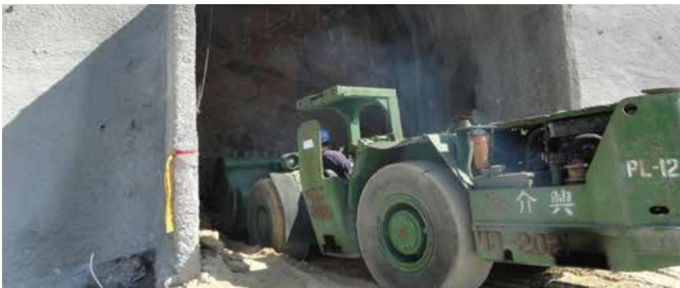
● 北口橫坑工區-開挖出渣
