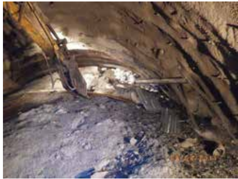
● 土方及砂包回填完成
