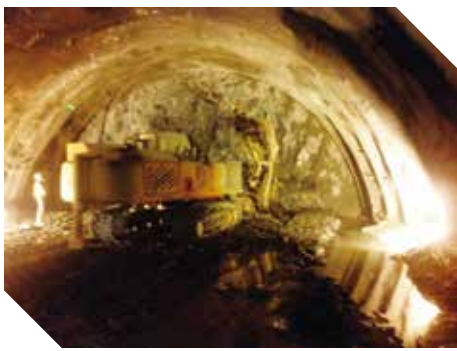
● 地錨鑽機鑽設預裂孔
