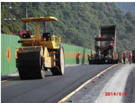
● AC路面鋪設
