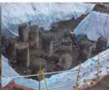
2013-04-04 全套管基樁樁頭處理
