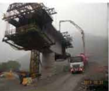
2013-10-31 N2 節塊混凝土澆置
