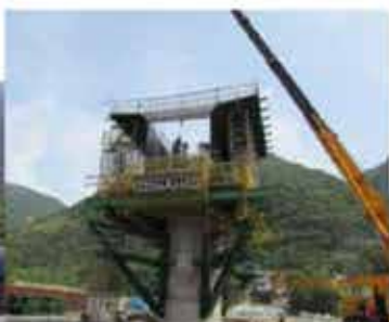
2013-08-18 柱頭塊鋼筋組立
