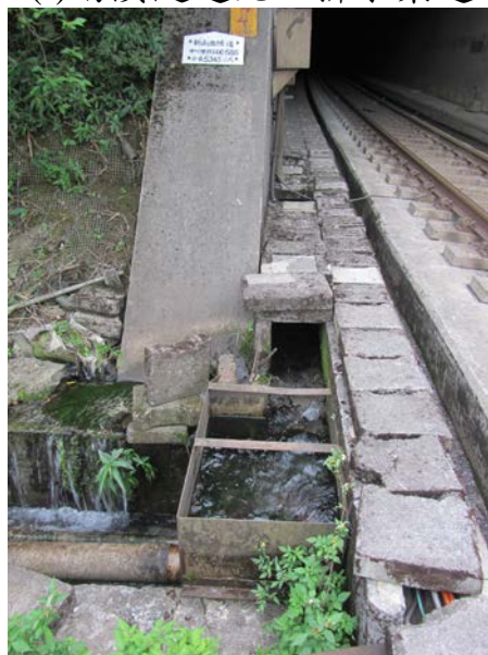
(h)新南澳隧道北口排水渠道
