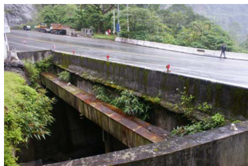
(d) 橫跨鼓音溪觀音二號橋現況
