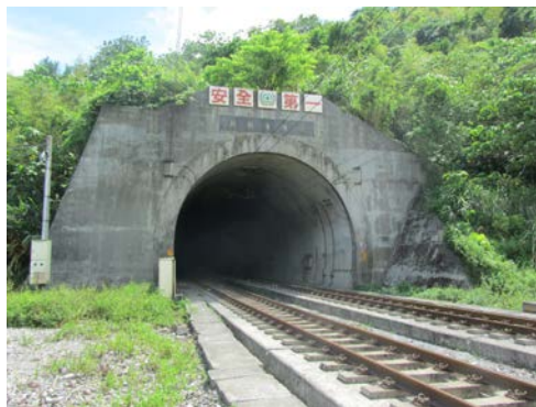
(d)新觀音隧道北口現況
