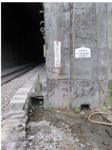
(g)南澳隧道南口排水渠道
