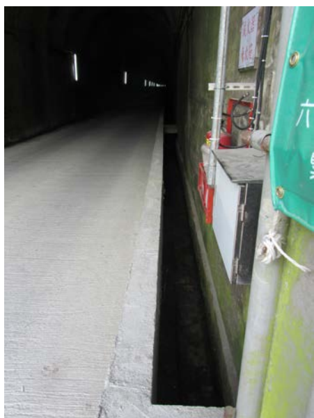
(e)觀音隧道北口排水渠道
