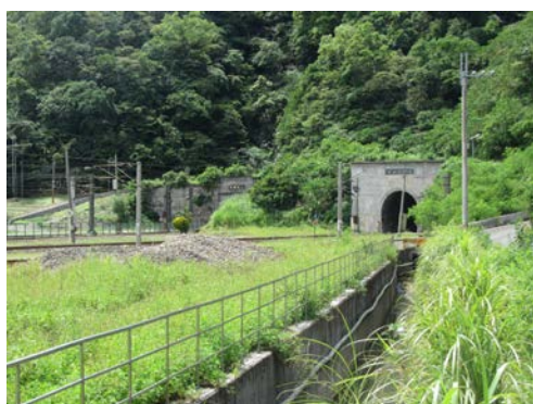
(a)永春隧道北口排水渠道
