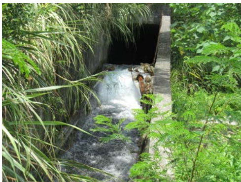
(c)新永春隧道南口排水渠道
