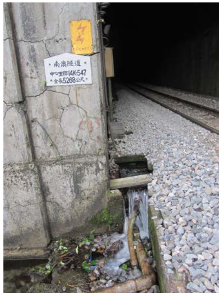
(f)南澳隧道北口排水渠道
