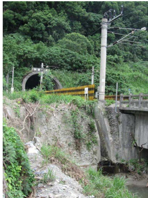
(j)新和平隧道南口排水渠道
