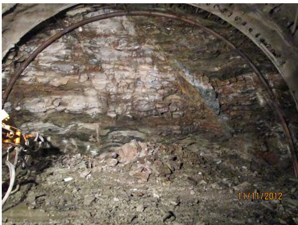
圖 3.1-7 觀音隧道北口北上線 2K+734.2 開挖面狀況
