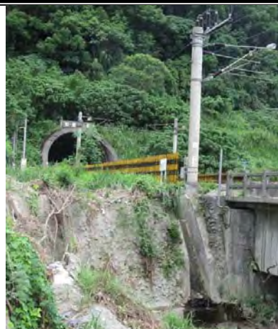
(j)新和平隧道南口排水渠道
