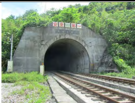
(d)新觀音隧道北口現況
