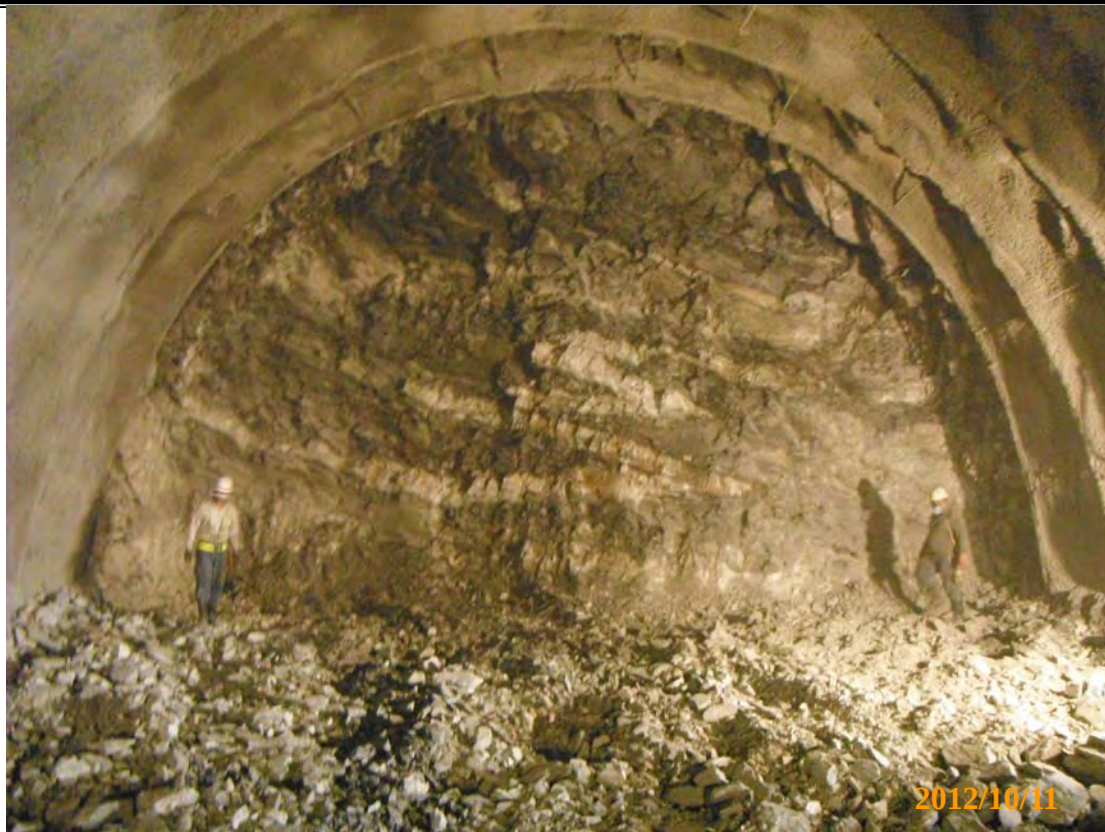
圖 2.1-3 觀音隧道里程 7K+558 開挖面影像照片
