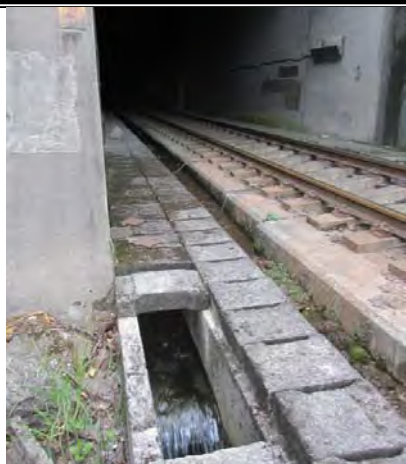
(i)新南澳隧道南口排水渠道
