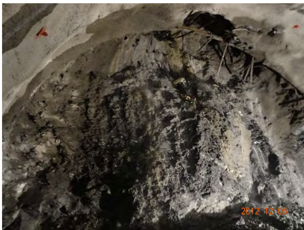
圖 3.1-13 觀音隧道北上線里程 6K+610 開挖面岩盤狀況
