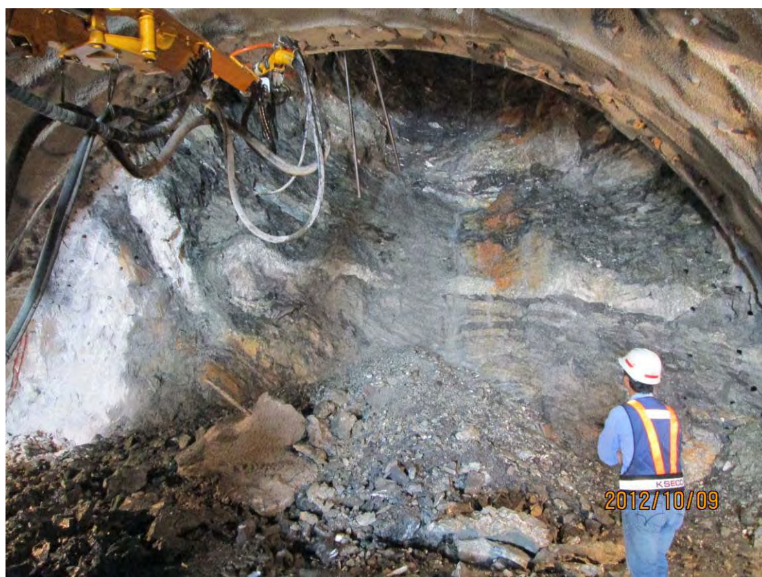
圖 3.1-16 谷風隧道施工橫坑里程 0K+359 開挖面地質狀況
