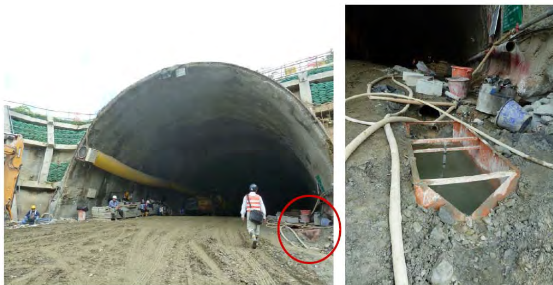
圖 3.1-1 觀音隧道北口北上線洞口量水堰情況
