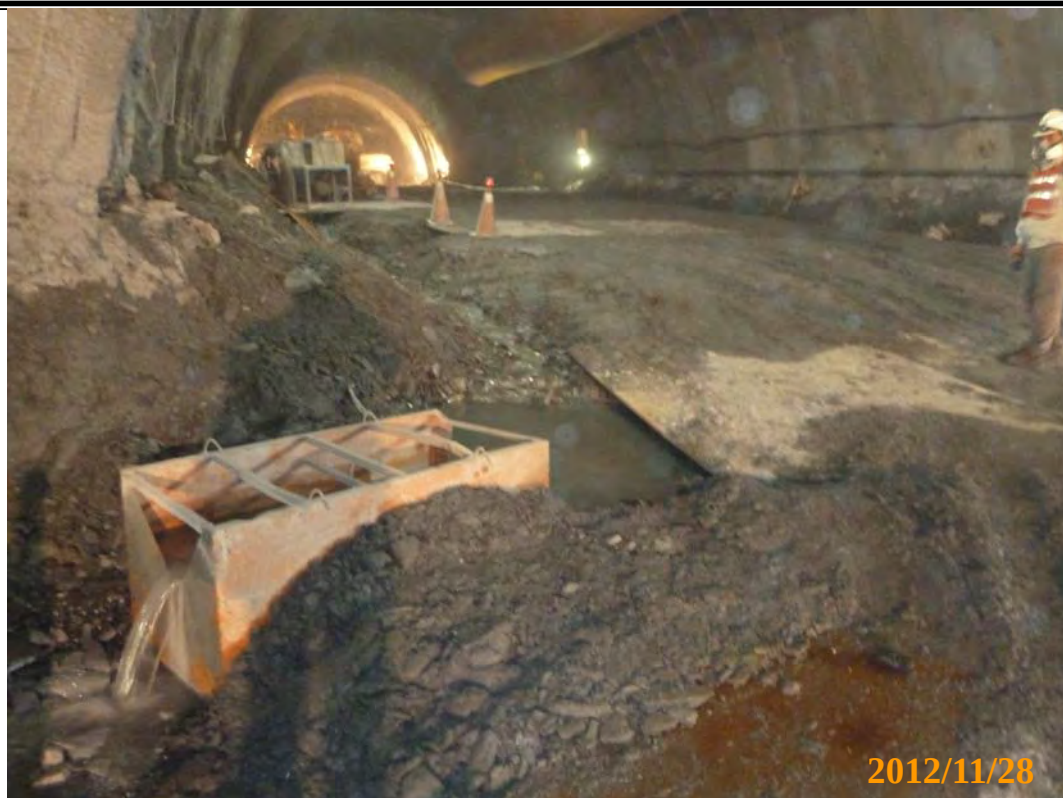
圖 3.1-4 觀音隧道里程 8k+225 施工橫坑與舊北迴鐵路隧道交會處之量水堰情況
