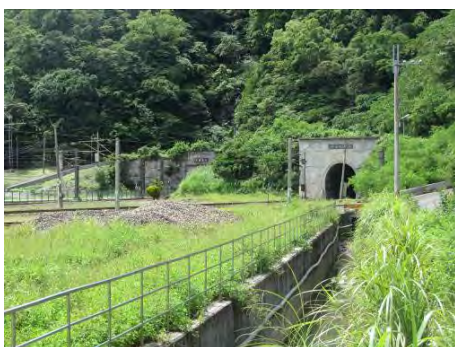
(a)永春隧道北口排水渠道
