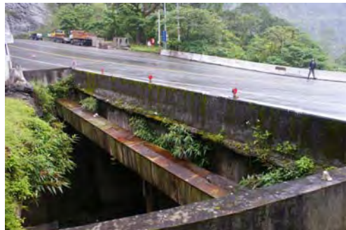
(d) 橫跨鼓音溪觀音二號橋現況
