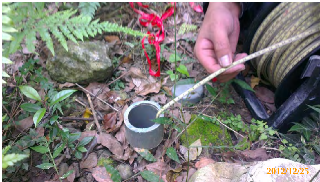
圖 3.5-3 PD-4 既有地下水位井現場量測作業情形
