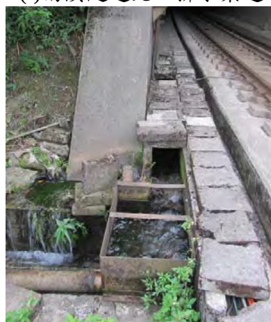
(h)新南澳隧道北口排水渠道
