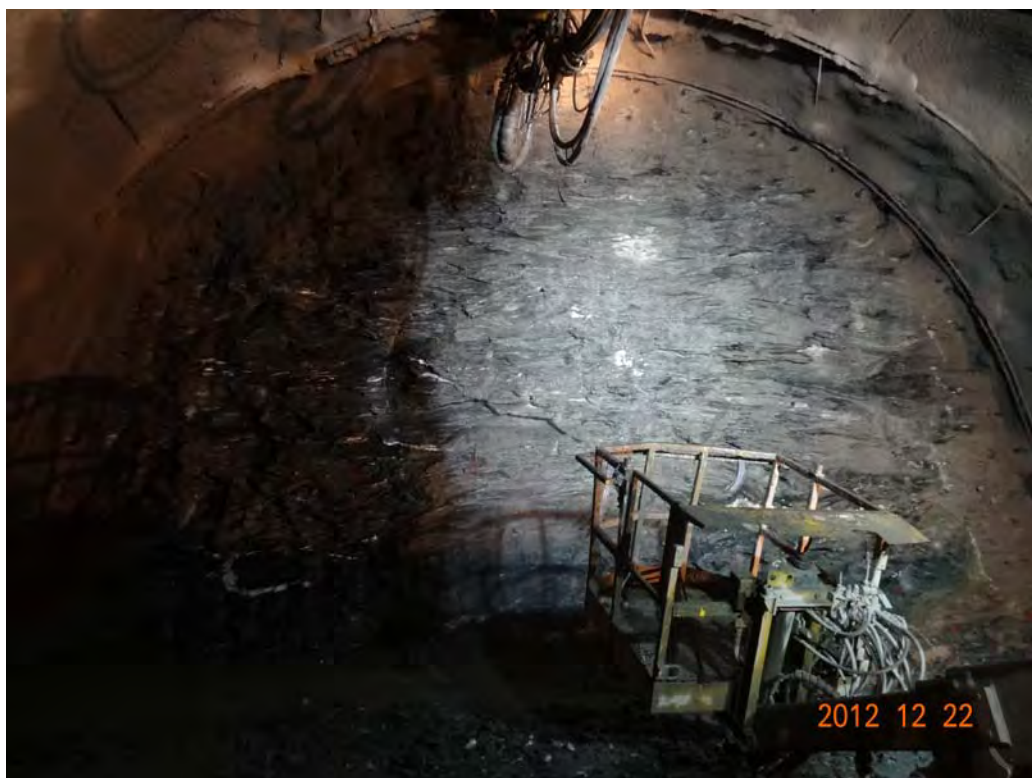
圖 3.1-8 觀音隧道北口北上線 2K+833.2 開挖面岩盤狀況
