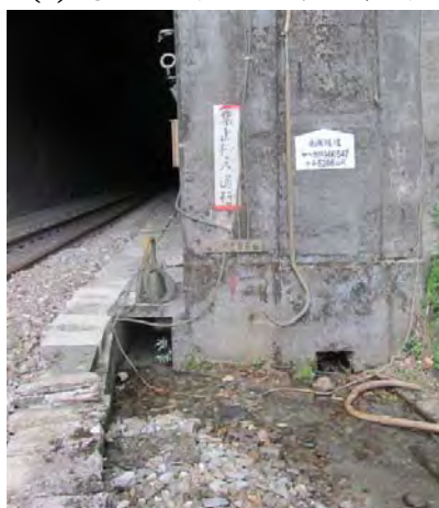
(g)南澳隧道南口排水渠道
