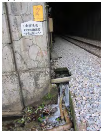
(f)南澳隧道北口排水渠道
