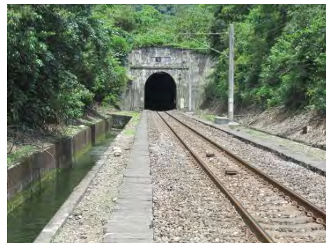
(b)永春隧道南口之排水渠道
