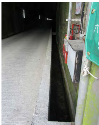
(e)觀音隧道北口排水渠道
