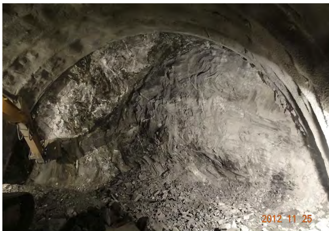
圖 3.1-14 谷風隧道 10K+768 橫坑里程 0K+461.2 開挖面地質狀況
