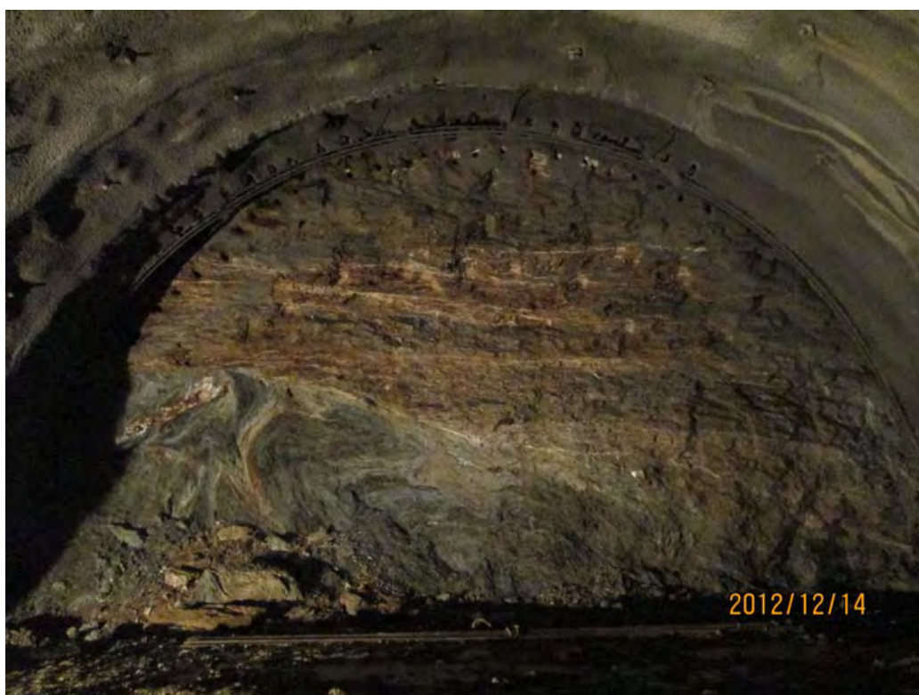
圖 3.1-9 觀音隧道北口南下線 2K+750.6 開挖面岩盤狀況
