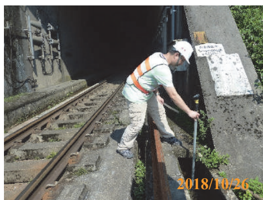
(b)新南澳隧道南口排水渠道
