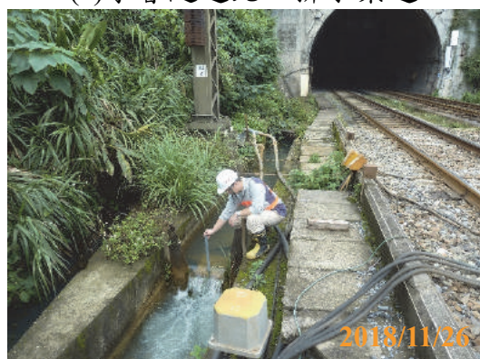
(c)新觀音隧道南口排水渠道
