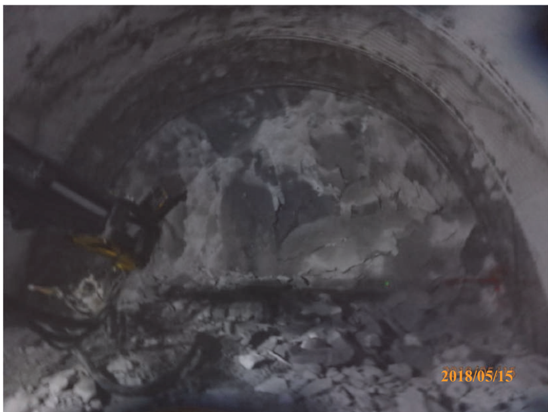
圖 2.1-2 中仁隧道南口南下線里程 2K+378.5 開挖面照片
