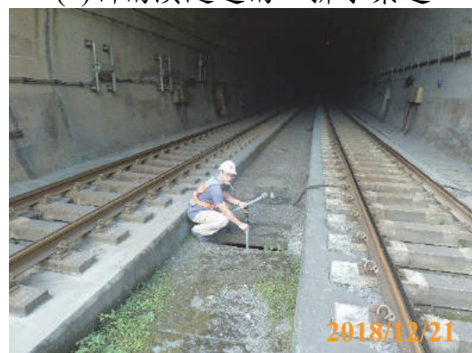
(d)新和平隧道北口排水渠道
