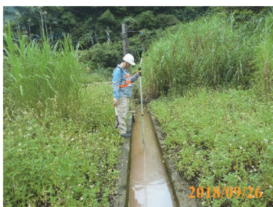
(a)永春隧道北口排水渠道
