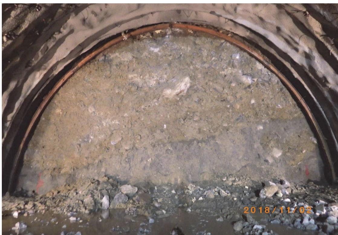
圖 2.1-3 仁水隧道北洞口里程 3K+247.0 開挖面照片
