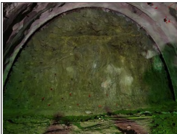
➤ C1 標南口：隧道北上線鑽炸準備， 開挖面鑽炸藥孔
