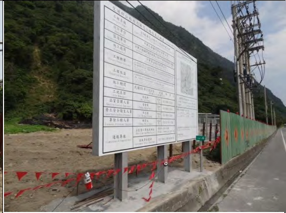
➤ C1 標北口橫坑工區：工程告示牌設置
