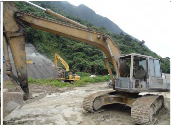
➤ C1 標北口橫坑：新進場機具，挖土機(欣達)
