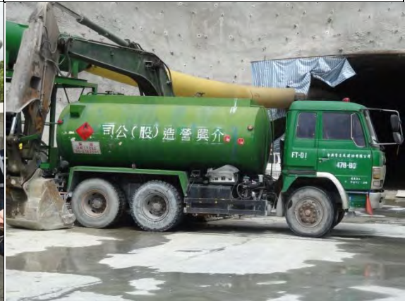
➤ C1 標南口：機具加油作業(油罐車 FT-01)
