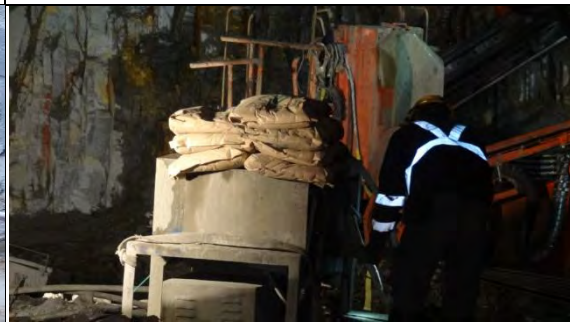
➤ A2 標工區(北口)：隧道灌漿作業使用工料，MA-威建 01 水泥砂漿
