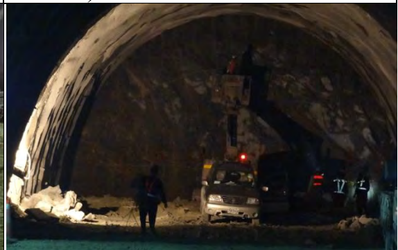
➤ C1 標南口：隧道北上線炸孔裝藥結線
