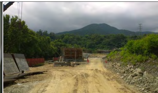
➤ A3 標幸福高架橋工區：AS1 橋台模板組立
