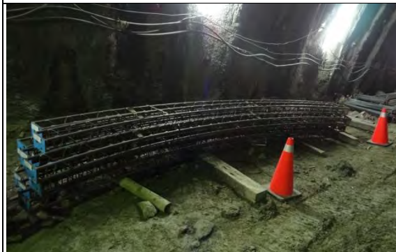
➤ C1 標南口：隧道北上線洞內桁架支撐堆置區
