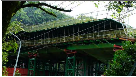
➤ A3 標工區：幸福高架橋工區 PS2 上構與 MA-樂志 04 工作車構件
