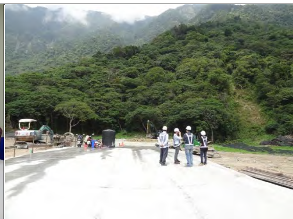
➤ C1 標北口橫坑：施工便道鋪設，使用工料 MA-00060 混凝土 245
