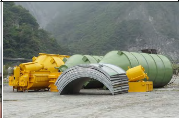
➤ C1 標南口：預拌廠工料堆置區
