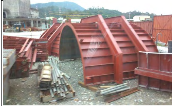
➤ A1 標工區：新進工料(MA-榮工 012 墩柱鋼模)
