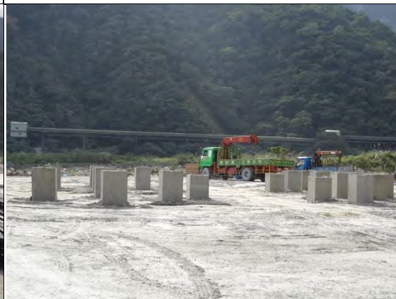
➤ C1 標南口：預拌廠基礎混凝土澆 置，使用工料 MA00113 混凝土 350
