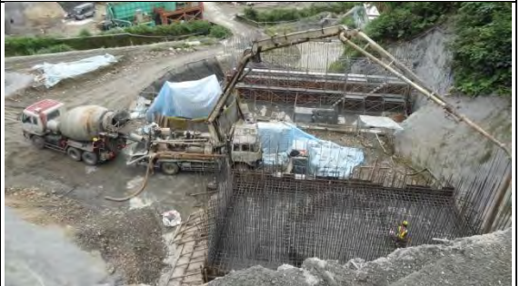
➤ A2 標北口工區：AN2 橋台基礎混凝土澆置
