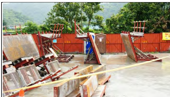
➤ A1 標白米高架橋工區：P37、P38 墩柱鋼模(4 月份填報)
