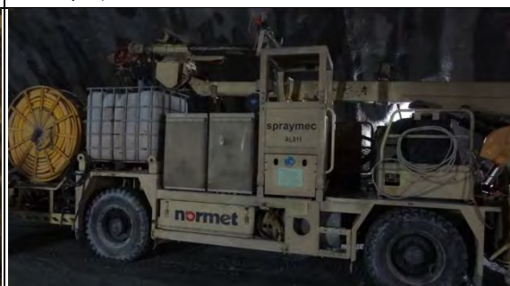
➤ A2 標南口工區：南下線隧道內設置機具(AL-011 噴漿機)
