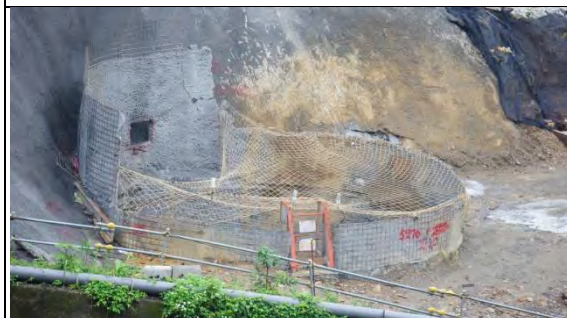
➤ A1 標工區：PS10 井式基礎現況
