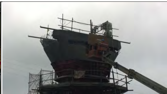
➤ A1 標白米高架橋工區：水刀拆除 P10 帽樑混凝土結構
