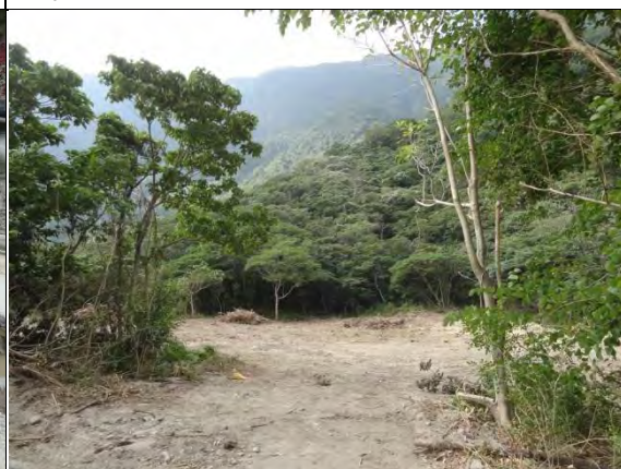
➤ C1 標北口：橫坑工區清除掘除
