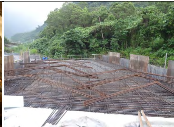
➤ C1 標南口：排水箱涵第一節塊頂板鋼筋綁札作業
