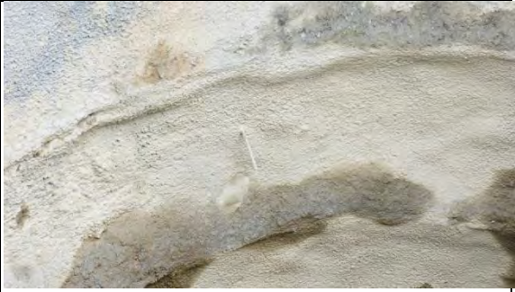
➤ A1 標白米高架橋工區：P33 井式基礎地質改良現況
