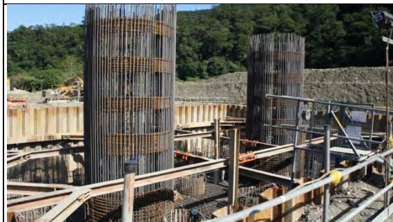
➤ A1 標工區：P4 基礎鋼筋綁紮工程
