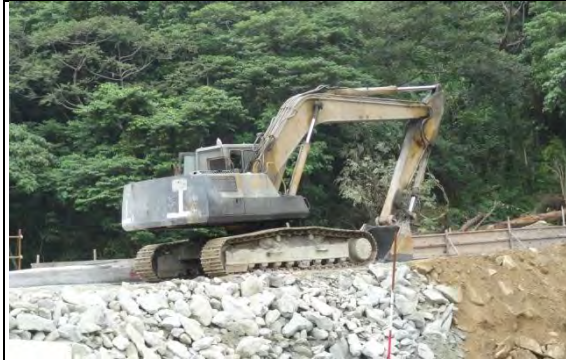
➤ C1 標北口橫坑工區：新進場機具 (外租挖土機)
