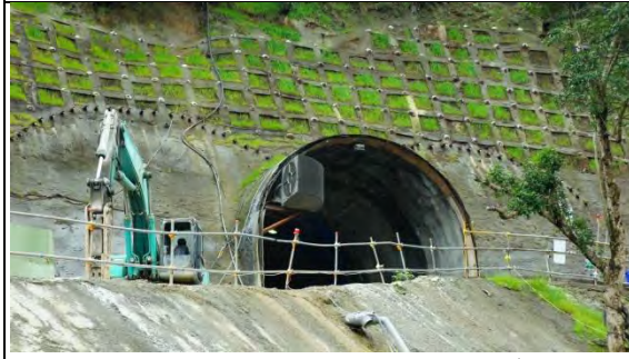
➤ A3 標工區：東岳隧道北口導坑與開挖機具(配特 01 挖土機)
