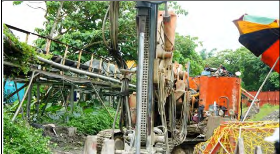
➤ A1 標白米高架橋工區：P34 井式基礎地質改良使用機具(鑽堡機)
