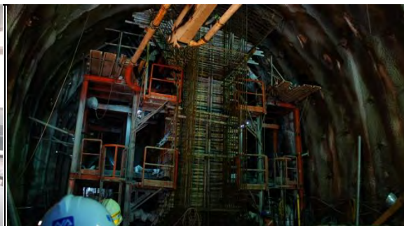
➤ A3 標東岳隧道工區：中間牆混凝土澆置作業
