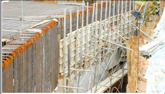
➤ A1 標蘇澳隧道工區：本月份新增回收再利用材料(模板與支撐架)
