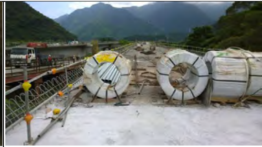
➤ A3 標東澳北溪河川橋工區：預力材料 MA-樂志 01(預力鋼腱)
