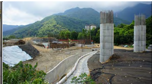
➤ A3 標工區：排水箱涵現況(前段已埋入)
