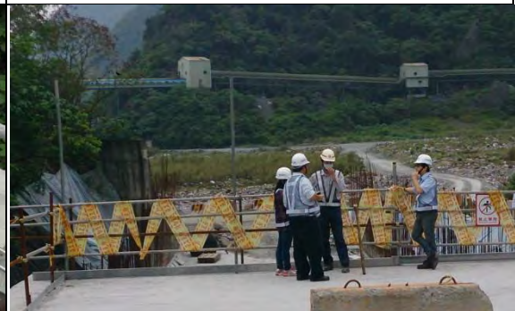
C1 標南口：排水箱涵頂板施工進度
