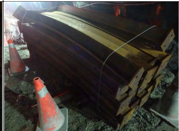
➤ C1 標南口：隧道北上線新進場材料堆置區(洞台支保)
