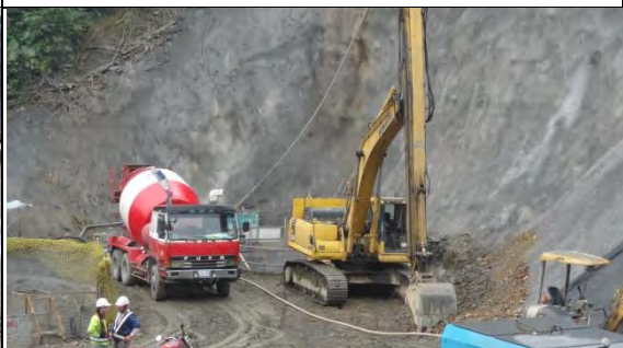
➤ A2 標工區：AN2 橋台井式基礎降挖作業
