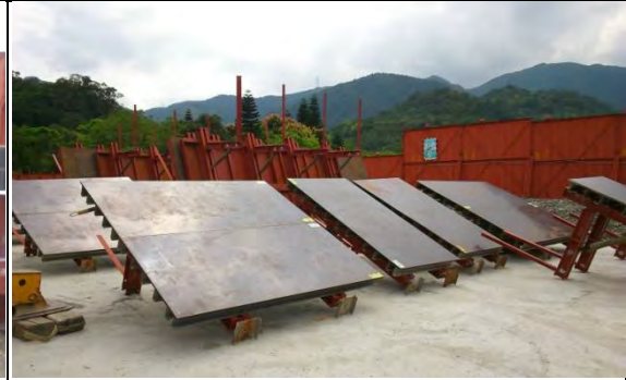
➤ A1 標工區：新進工料(MA-榮工 011 基礎鋼模)
