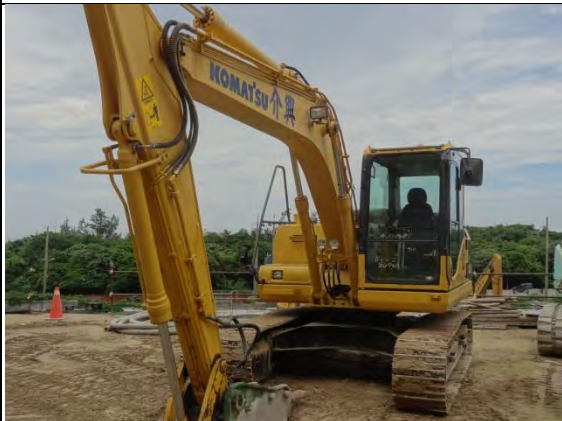
➤ C1 標北口橫坑：新進場機具，BH-96 挖土機
