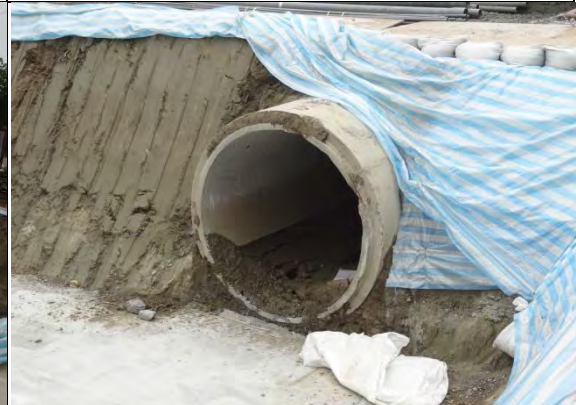
➤ C1 標北口橫坑工區：臨時沉砂池 鋼筋混凝土管埋設
