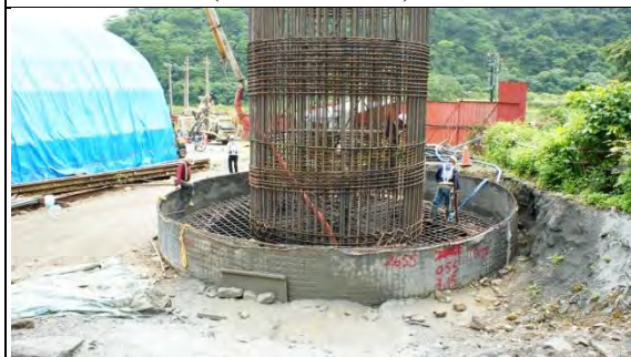
➤ A1 標永樂高架橋工區：PN9 井式基礎澆置作業
