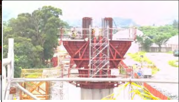
➤ A1 標永樂高架橋工區：P12 墩柱帽樑鋼筋綁紮
