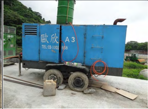
➤ C1 標北口橫坑工區：新進場機具，ZU-003：空壓機(歐欣)
