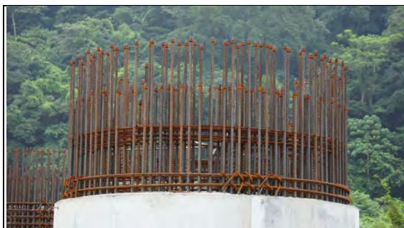
➤ A1 標工區：PN1 基礎墩柱鋼筋與鋼筋公頭續接器
