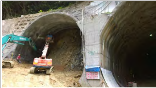
➤ A3 標東岳隧道工區：北口北上線開挖(ME-配特 16、ME-配特 19)
