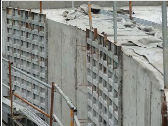
➤ C1 標南口：排水箱涵側牆模版及車牙螺桿
