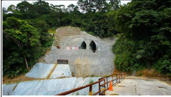
➤ A3 標工區：東岳隧道南口導坑中間牆
