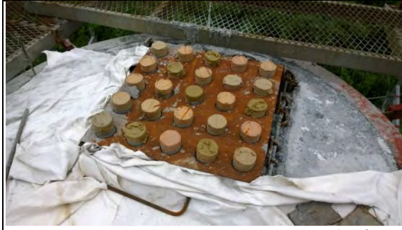
➤ A1 標白米高架橋工區：P11 盤式支撐混凝土支撐墊
