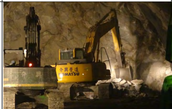
➤ C1 標南口：隧道北上線修挖作業 新進場挖土機(右)(BH-94)
