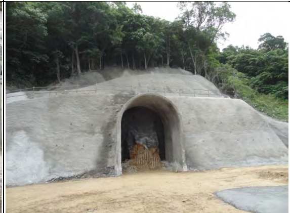
➤ C1 標北口橫坑：洞口假隧道組立作業
