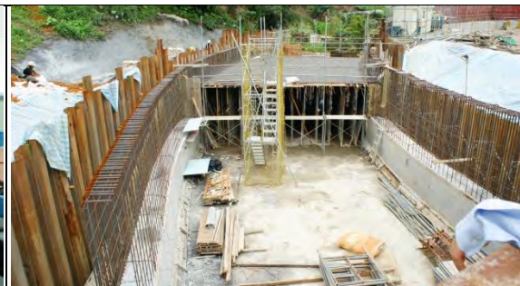
➤ A1 標蘇澳隧道工區：排水箱涵
