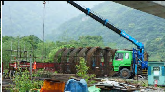
➤ A3 標工區：PN7&PS7 墩柱樣架
