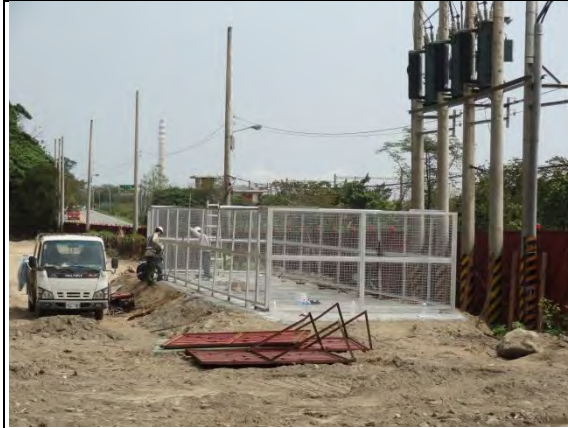
➤ C1 標北口橫坑工區：受電站防護圍籬組裝
