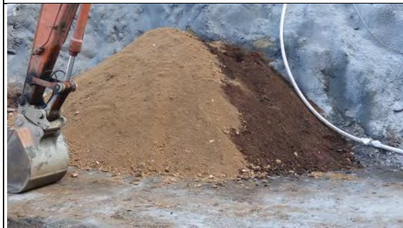
➤ A2 標工區(北口)：邊坡自由型格梁樑施噴使用工料-有機土
