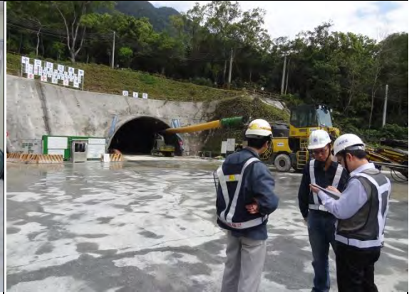
➤ 查證人員巡視隧道南口工區
