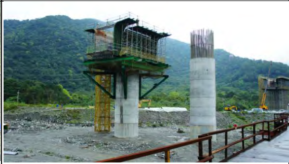
➤ A3 標工區：東澳北溪河川橋工區 PN13 柱頭板與 PS13 墩柱施作
