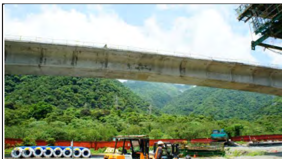
➤ A3 標東澳北溪河川橋工區：PS3 與 PS4 節塊閉合處
