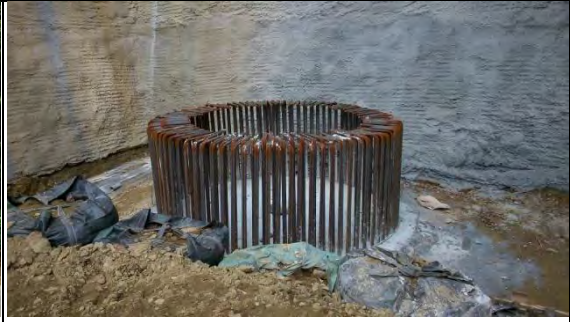
➤ A3 標工區：AN1 井式基礎現況
