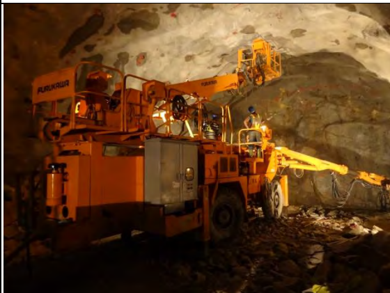
➤ C1 標南口：南下線隧道新進場機具，ZU-002：鑽堡機(聯鈺)
