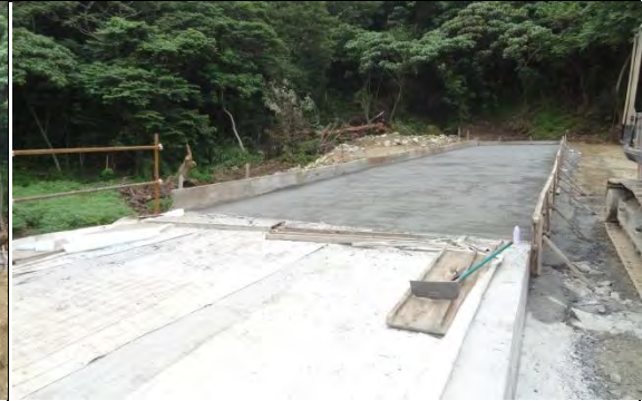
➤ C1 標北口橫坑工區：施工便道底 板澆置(MA-00035 混凝土 175)
