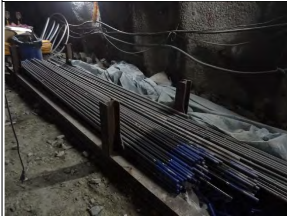
➤ C1 標南口：隧道北上線工料堆置區，MA-105-3 SN 岩栓
