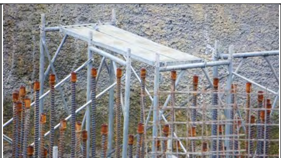
➤ A1 標工區：PN7 井式基礎墩柱鋼筋與鋼筋母頭續接器
