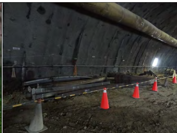
➤ C1 標南口：隧道北上線支保組堆 置區
