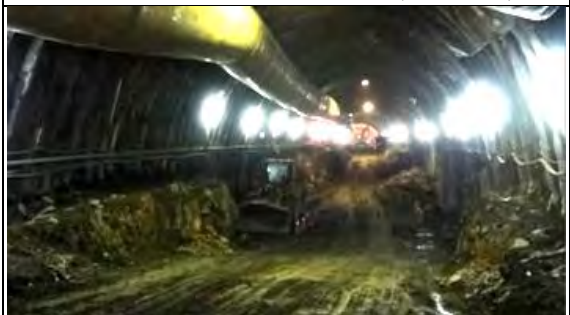
➤ A2 標北口工區：北上線隧道台階(洞台)開挖
