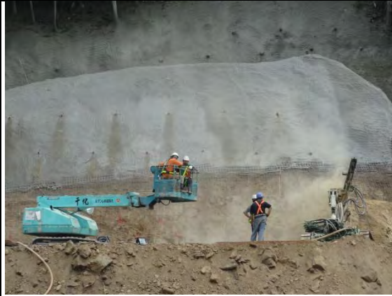
➤ C1 標北口橫坑工區：邊坡灌漿錨筋鑽孔
