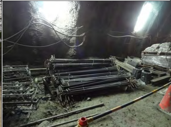
➤ C1 標南口：隧道北上線工料堆置區，MA-00112 拉桿
