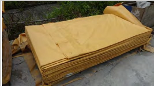
➤ A2 標南口工區：隧道通風風管堆置區
