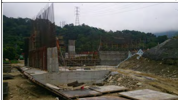
➤ A3 標幸福高架橋工區：橋台基礎施工進度及鋼模
