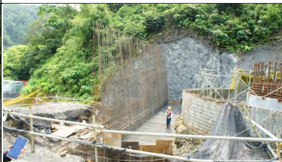
➤ A2 標北口工區：擋土牆鋼筋綁扎作業
