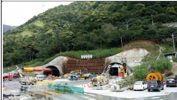
➤ A2 標工區：東澳隧道南口工程現況(修挖、出碴作業)
