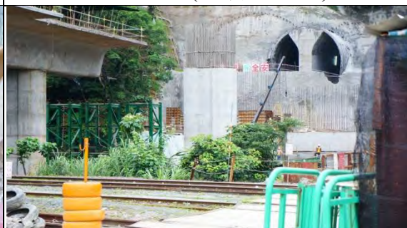
➤ A3 標幸福高架橋工區：東岳隧道南口中間牆外觀
