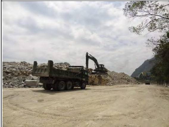
➤ C1 標南口二工區：暫置土方作業，使用機具，挖土機 BH-92、傾卸車 DT-33
