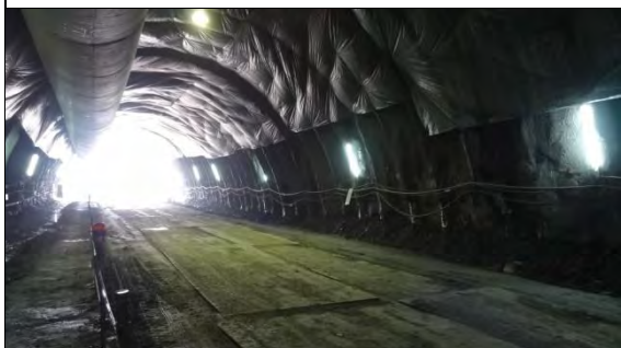
➤ A2 標工區：北口南下線隧道環境改善
