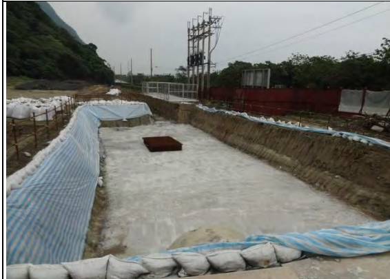
➤ C1 標北口橫坑工區：臨時沉砂池設 置
