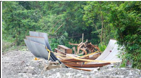
➤ A1 標工區：3 月份新增工程材料 (防撞鋼板)
