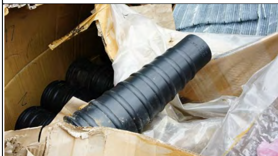
➤ A3 標東澳北溪河川橋工區：協力廠商材料(MA-樂志 06、07 端錨套管)
