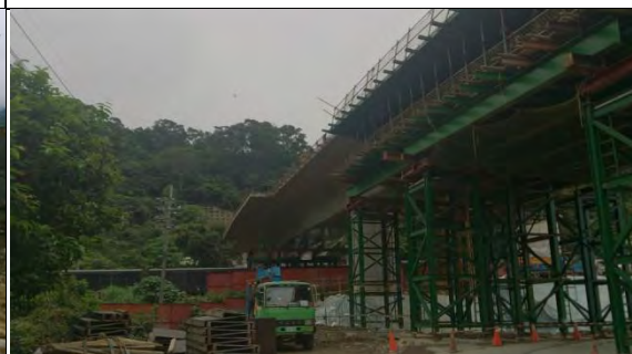
➤ A3 標幸福高架橋工區：PS1、PS2 場撐
