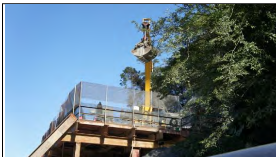
➤ A1 標工區：PN6 井基及北勝機具 ME-北勝 01(挖土機 PC300)
