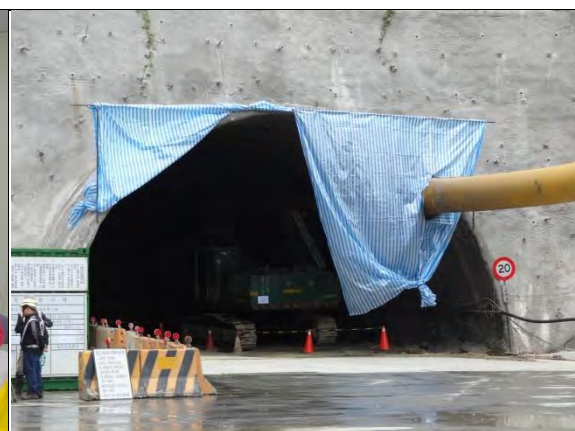
➤ C1 標南口：隧道北上線鑽炸準備，洞口隔音簾幕架設
