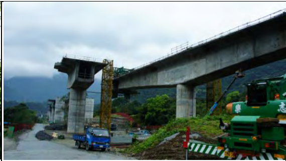
➤ A3 標工區：東澳北溪河川橋工區 PN4&PS4 墩柱
