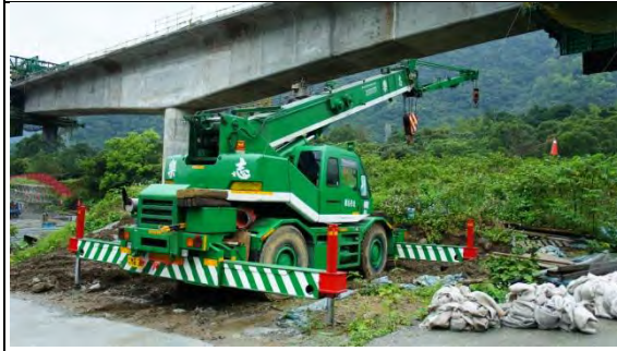
➤ A3 標工區：ME-樂志 14 吊卡車
