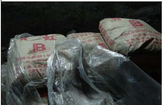
➤ C1 標南口：隧道北上線工料堆置 區，MA-00082-1 水泥砂漿(II 型)
