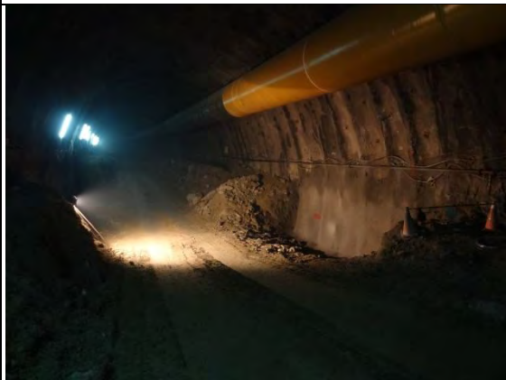
➤ C1 標南口：北上線隧道洞台開挖作業
