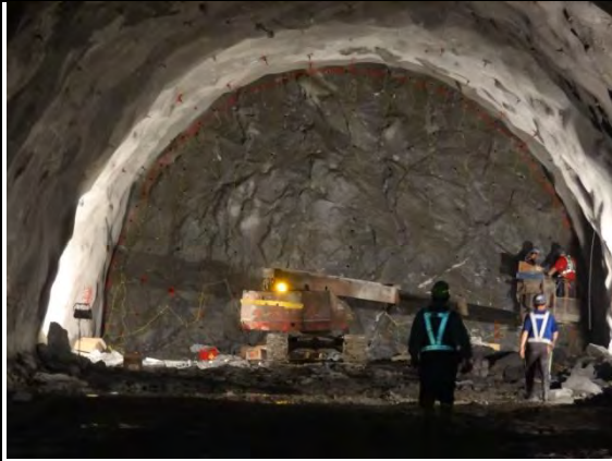
➤ C1 標南口：北上線隧道開挖面炸孔裝藥結線作業
