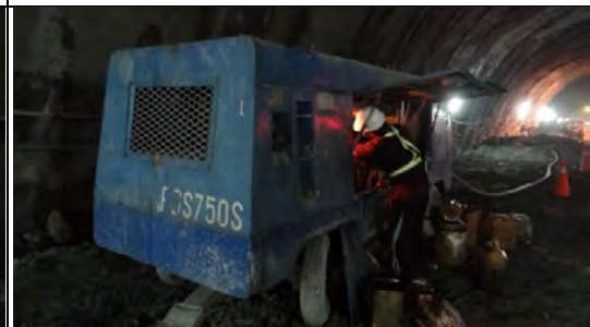
➤ A2 標南口工區：南下線台階降挖作業使用機具，ME-昆成 02 (空壓機)
