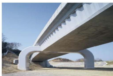
圖 5.1.3-4 波形鋼腹板設計及應用
