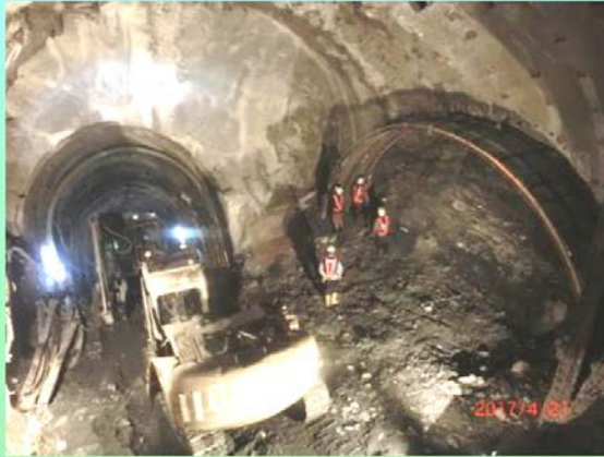
7k+890通風管道4/21施工情形
