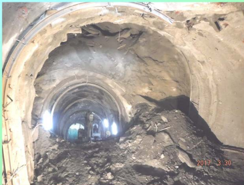
B2標7k+890中斜坑3/30抽坍後相片
