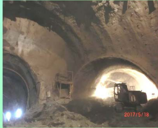
7k+890通風管道第12輪上半開挖施工
