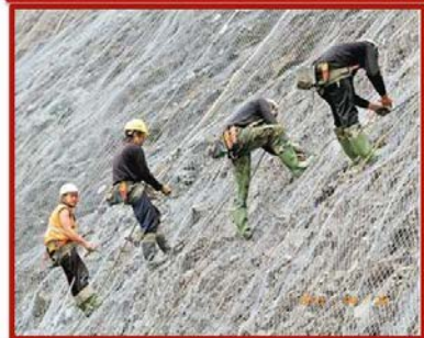
傳統邊坡作業工法
