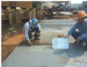
全滲透焊道UT檢驗
