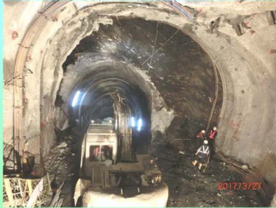
B2標7k+890通風管道3/27施工正常情形
