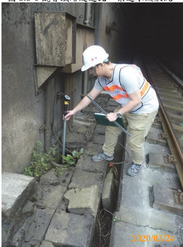
圖 3.3-3 新南澳鐵路隧道北口渠道水流狀況
