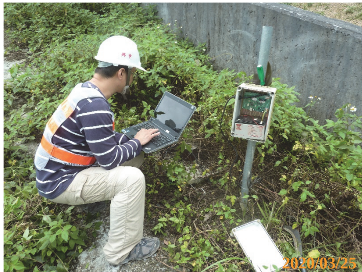
圖 3.5-2 BT-04 自記式水位觀測井資料下載作業情形
