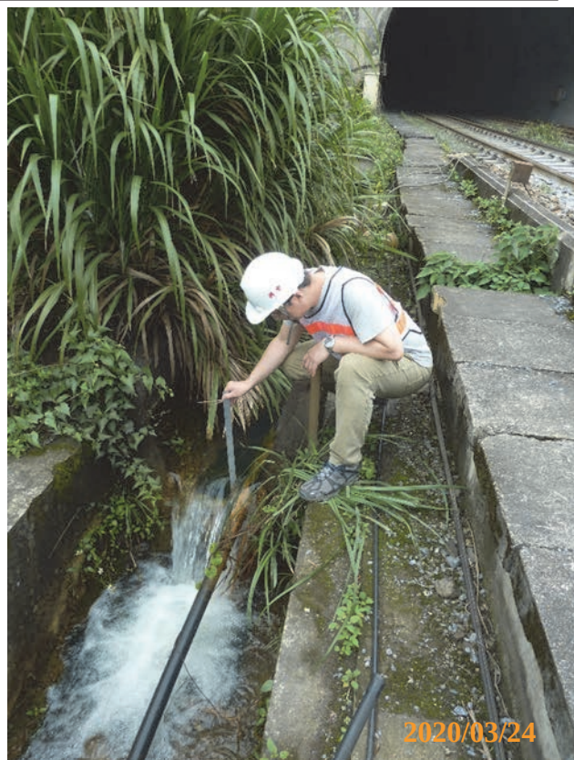
圖 3.3-2 新觀音鐵路隧道南口渠道水流狀況
